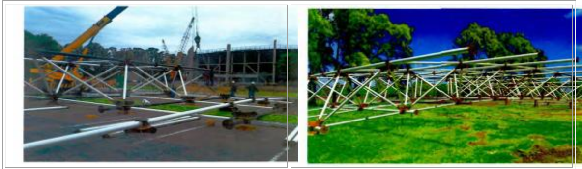
Armado en obra de la estéreoestructura E3
