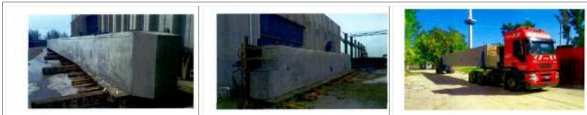
Columna perimetral en la planta Ivecor
