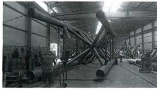
Pre-armado de arco tramo 6
