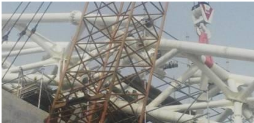
Vista del arco colocado
