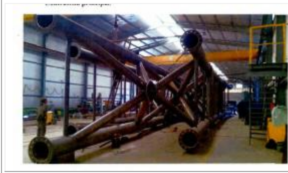
Tramos de Arcos 8-9-10
