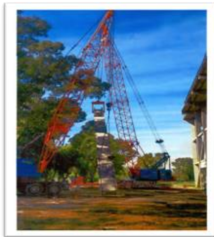
Viga perimetral en la planta Ivecor
