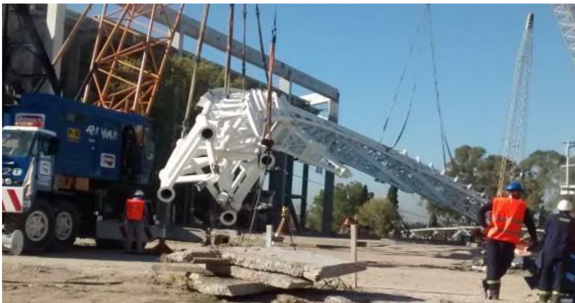
Sujeción de los arcos durante el proceso de izado
