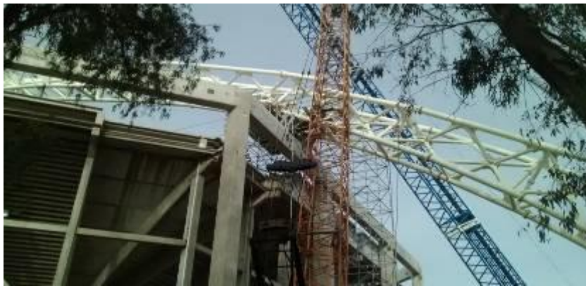
Vista del arco colocado
