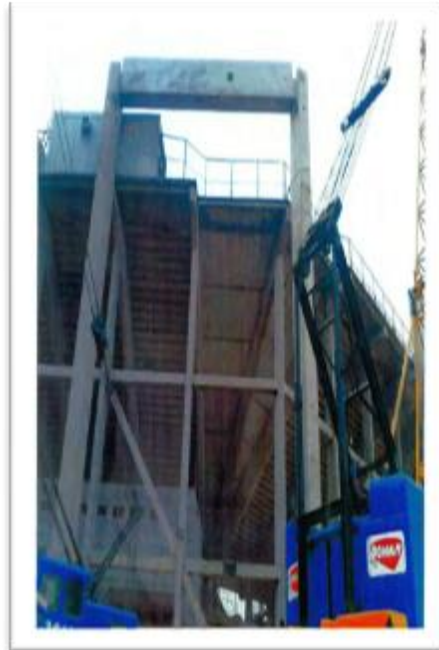
Montaje de columna y viga perimetral
