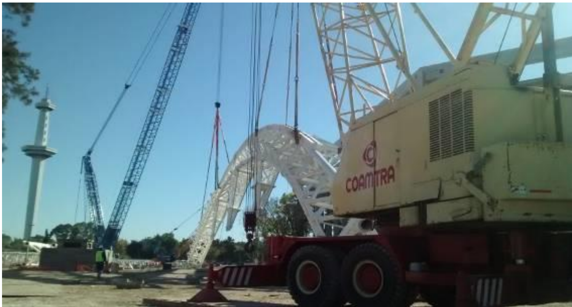
Grúas izando el arco de hierro
