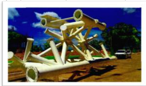
Tramo 9 armado en obra
