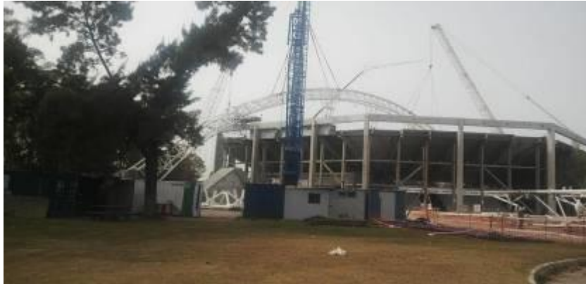
Vista del arco colocado
