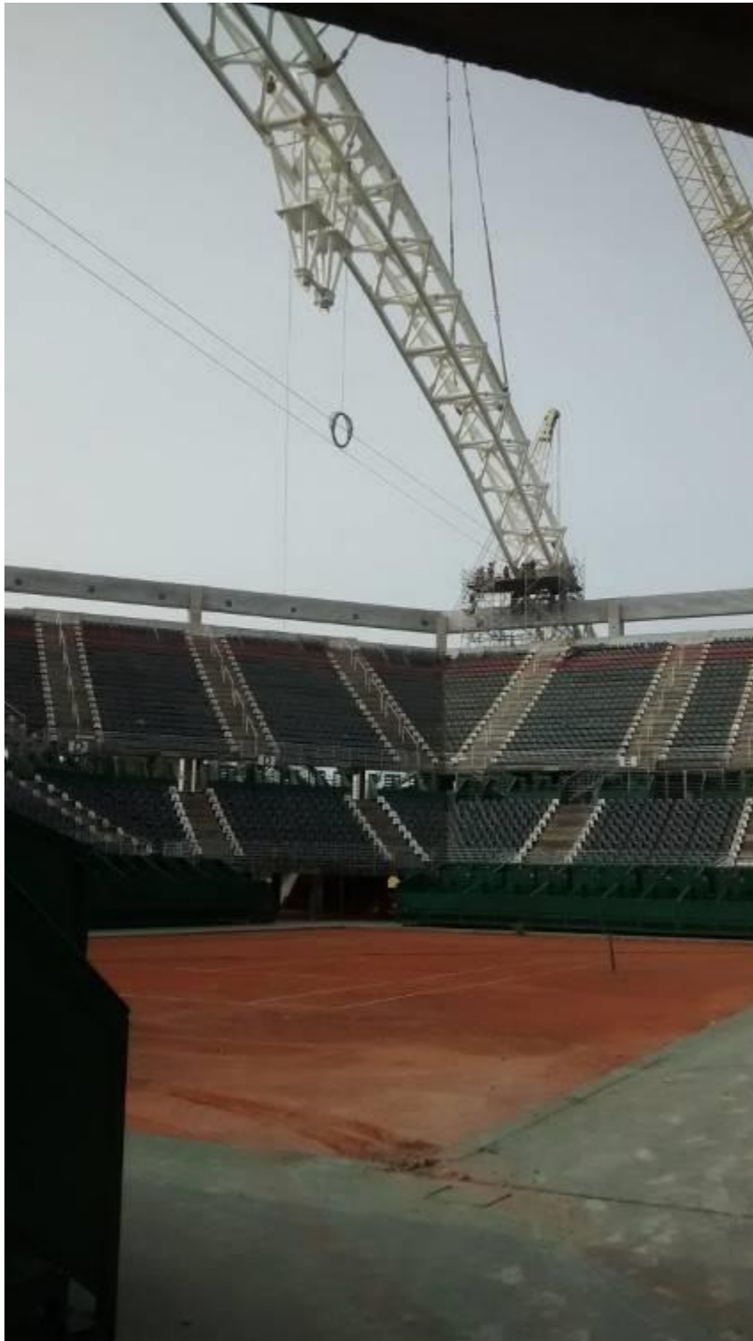
Vista del arco colocado
