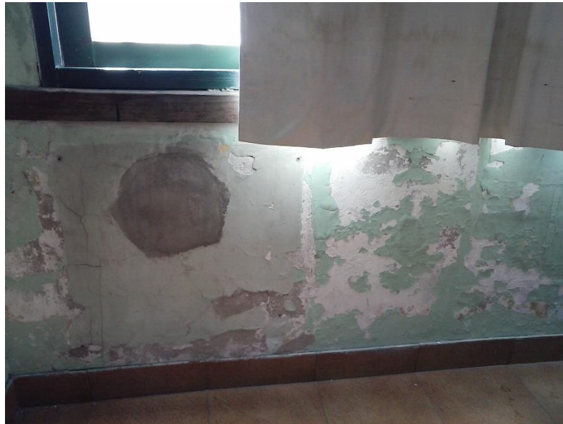
Humedad en aulas
