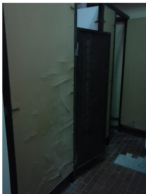
Puertas y pisos de baños en mal estado. Filtraciones en aulas por falta del sobretecho del edificio, obra pendiente.
