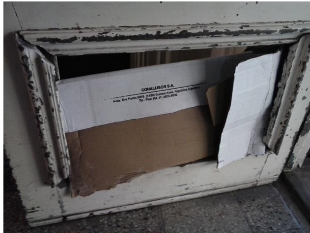
Rejillas faltantes o deterioradas en patio central y puerta de acceso al edificio
