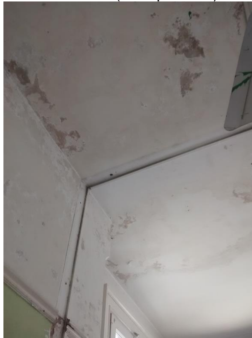
Filtraciones en techos (nivel primario).
