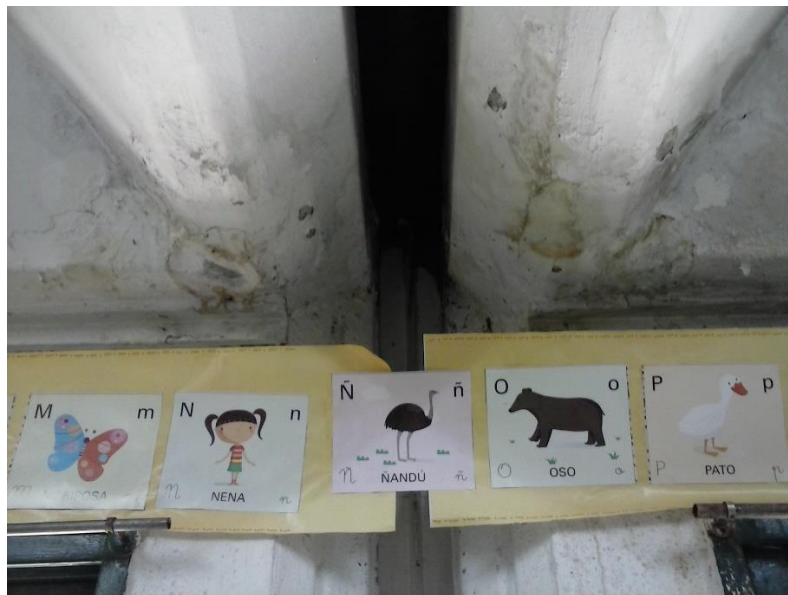
Filtraciones de techos de aula
