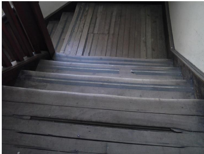
Escalera de acceso a aulas deteriorada y sin baranda
