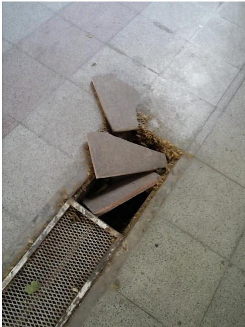
Rejillas faltantes o deterioradas en patio central y puerta de acceso al edificio
