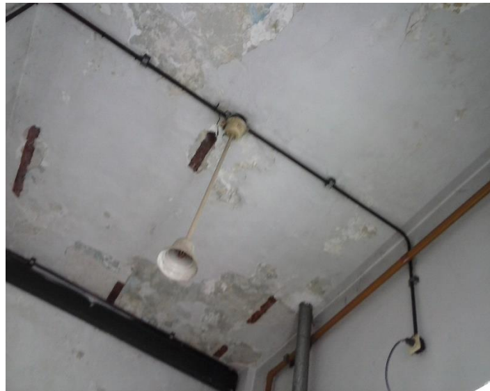
Techo de aula desafecta con filtraciones
