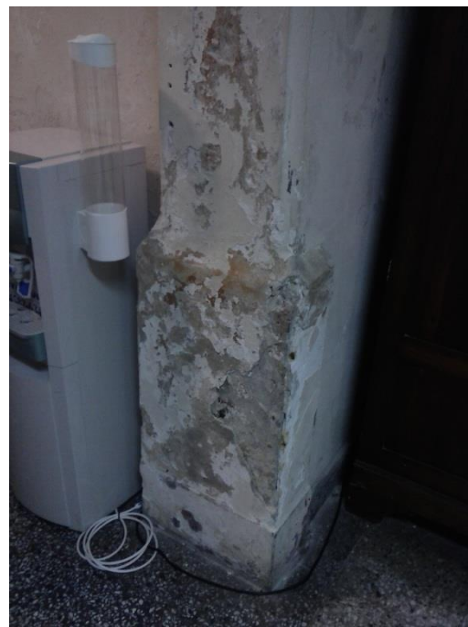
Filtraciones y desprendimiento de revocos
