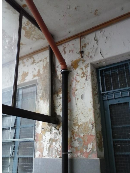
Filtraciones por desagües insuficientes
