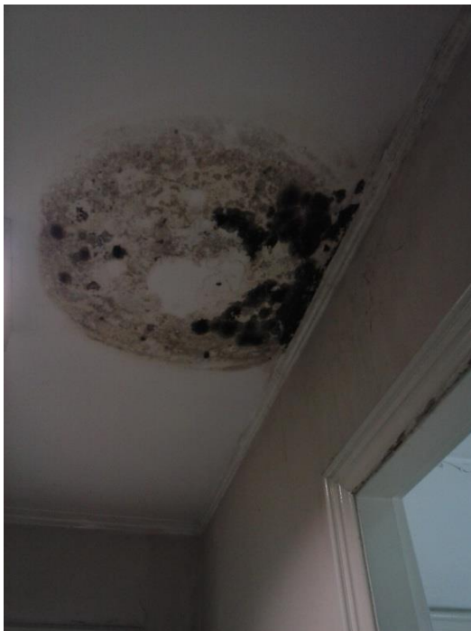
Filtraciones y desprendimiento de revocos
