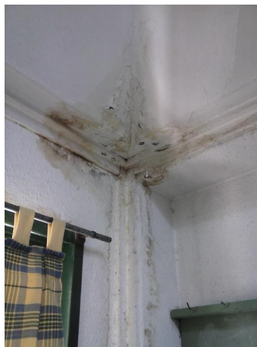
Puertas y pisos de baños en mal estado. Filtraciones en aulas por falta del sobretecho del edificio, obra pendiente.
