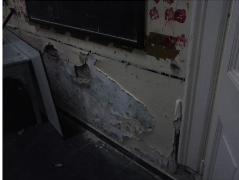
Humedad en aulas
