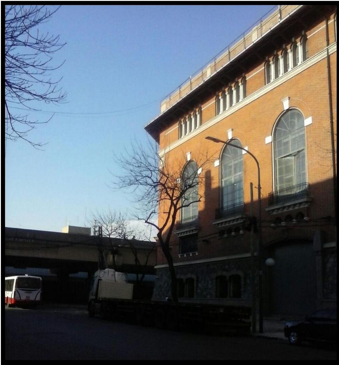
En ejecución al 23 de mayo de 2016.
