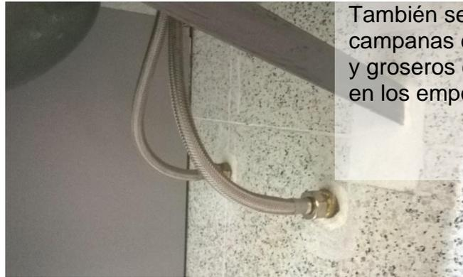
También se verifica la ausencia de campanas en conexiones flexibles y groseros detalles de terminación en los empotramientos.
