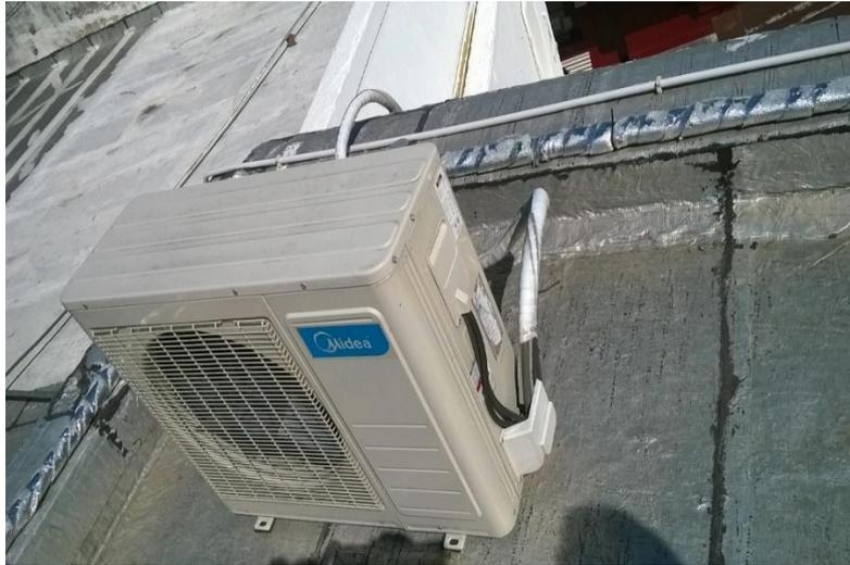
Foto 26 Equipo de AA en techo (simplemente apoyado)
