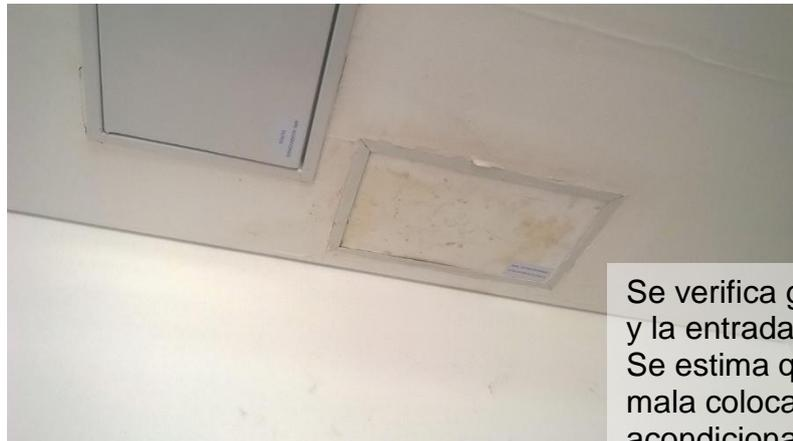
Se verifica gotera que afecta los techos y la entrada de guardia de ambulancias. Se estima que el origen radica en la mala colocación de los equipos de aire acondicionado.
