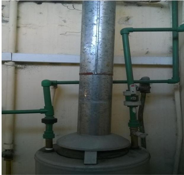
Fotos 24 Termotanque de alta recuperación
