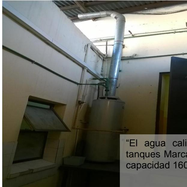
“El agua caliente provendrá de dos termo tanques Marca RHEEM de Alta Recuperación capacidad 160 lts” PET
