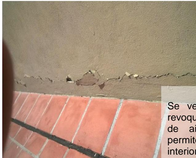
Se verifican rajaduras en el revoque, por sobre la baveta de aislación hidrófuga que permiten el ingreso de agua al interior de las mamposterías.
