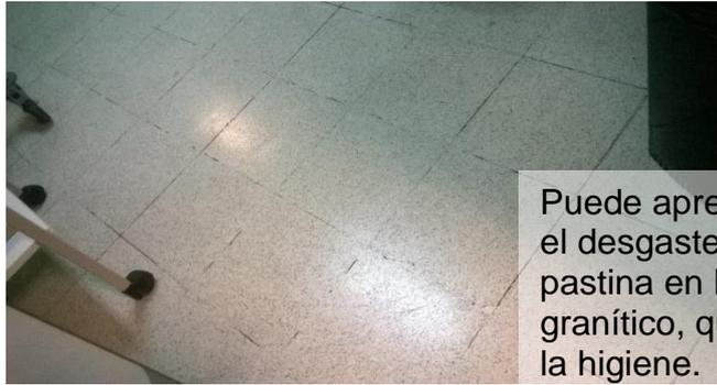
Puede apreciarse en la fotografía el desgaste prematuro de la pastina en las juntas del solado granítico, que afecta la sanidad y la higiene.
