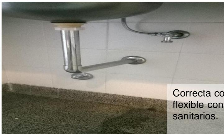
Correcta colocación de sopapa, flexible con campana y zócalos sanitarios.
