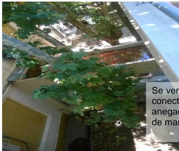
Se verificó que el techo del volumen conector del edificio se encontraba anegado, aparentemente, por falta de mantenimiento.
