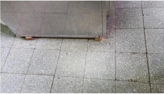
Hundimiento del piso y nivelación de la cocina con maderas.
