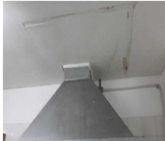
Cieloraso de cocina con pintura levantada
