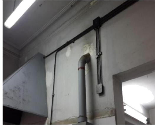
Paredes de sector cocina
