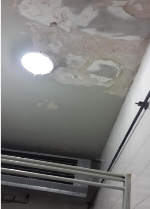
Techo del interior de cámara frigorífica
