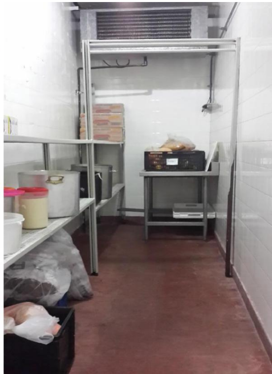
Sector lavado y conservación de vajilla Interior de cámara frigorífica
