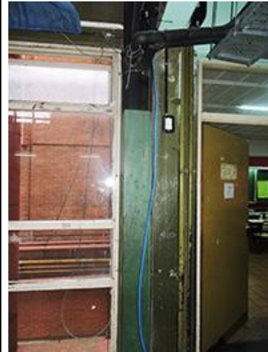
Cables de la instalación eléctrica sueltos
