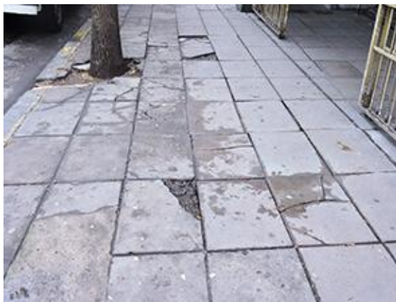
Acera con baldosas rotas y desprendidas
