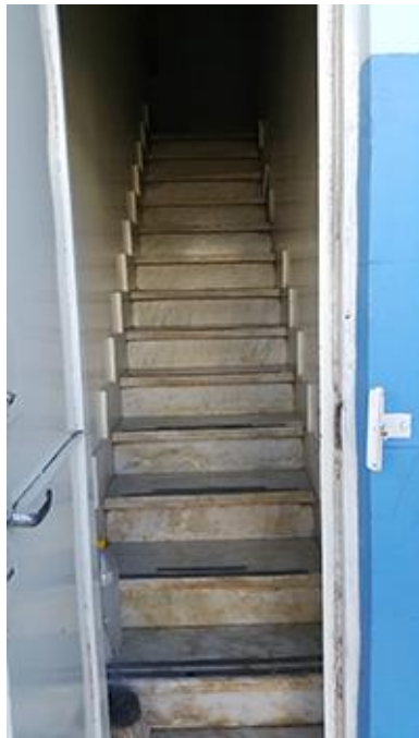
Acceso a la vivienda de la casera de ancho inferior al exigido.
