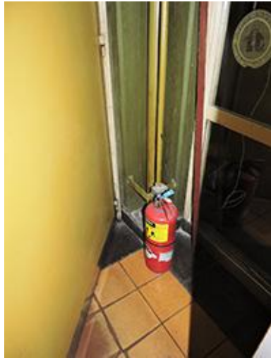
Extintores en lugares de difícil acceso, sin colgar con su correspondiente señalética
