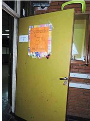
Todas las puertas abren en sentido contrario al de la evacuación
