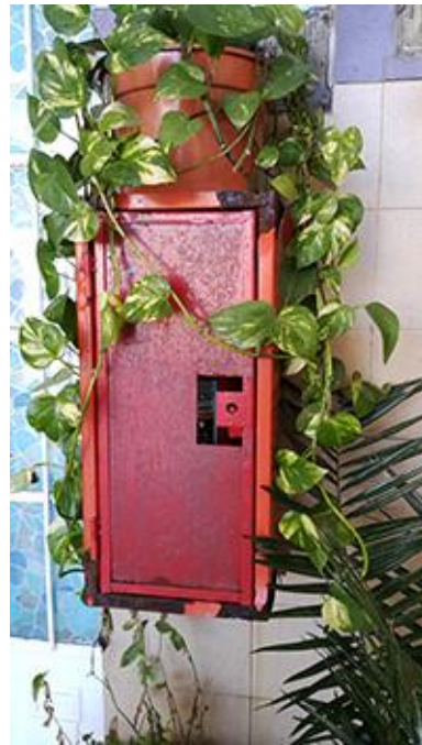
Extintores dentro de recintos con tapa de chapa de hierro y obstaculizados con plantas.
