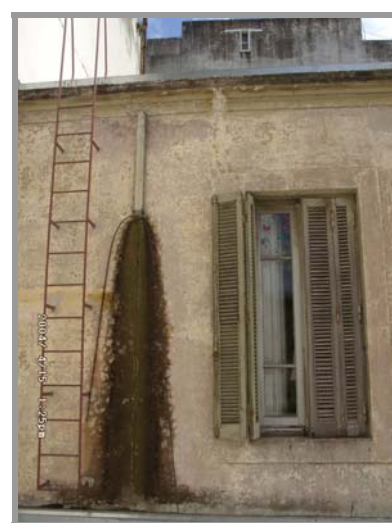
Foto Nro.2: Vista desagüe azotea
