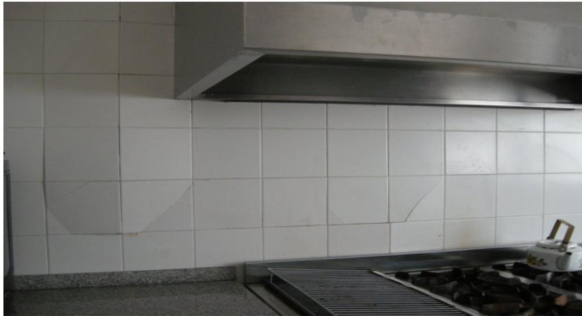
Deficiencias en la colocación de revestimientos sobre muro medianero, sector cocina
