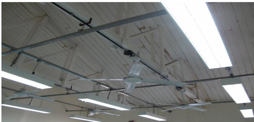
Trabajos de pinturas realizados sin una previa reparación de filtraciones de cubiertas
