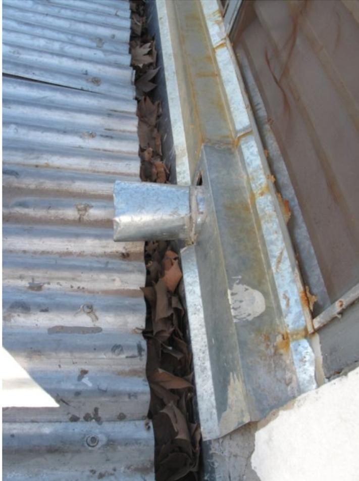
AL no proyectarse rejas de protección para las canaletas de desagüe de la cubierta metálica, provoca el taponamiento de las mismas
