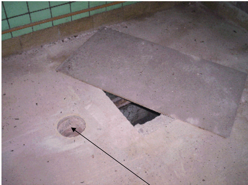
Se observa la verificación estructural en piso...
