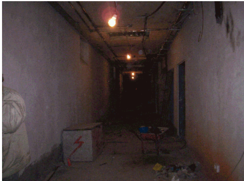
CONSTRUCCION: OBRA LAVADERO CENTRAL
