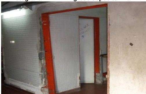
fotografía 14 ingreso depósito final
