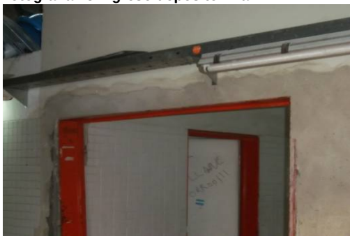
fotografía 13 ingreso depósito final
