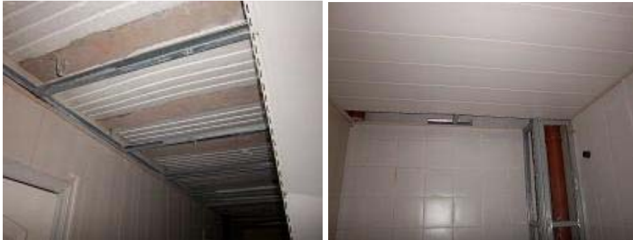
5. Losa premoldeada 6. Cielorraso de láminas de PVC
