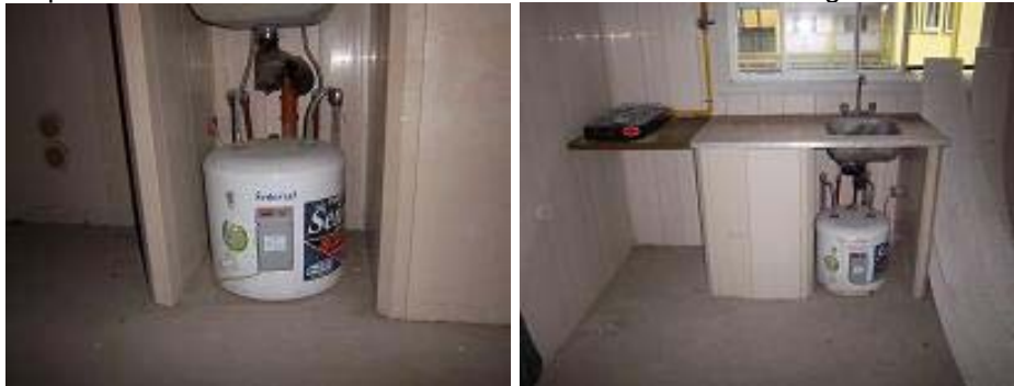
9. Termotanque eléctrico b/ mesada. 10. Anafe con conexión exterior de gas.
