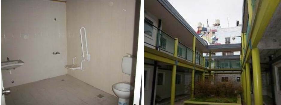
3. Baño para discapacitado 4. Estructura de H° A°
