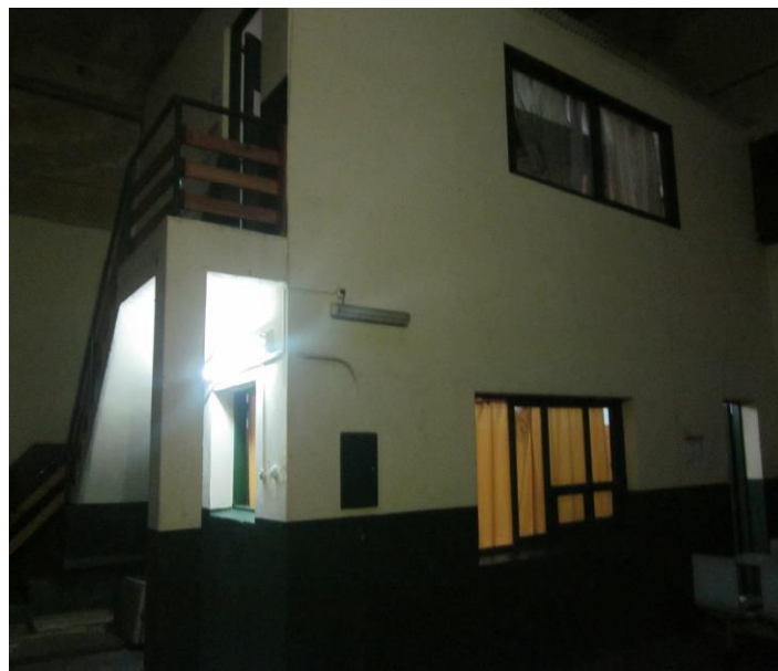
Foto: "Vista dormitorios 7 y 7 bis desde el galpón"
