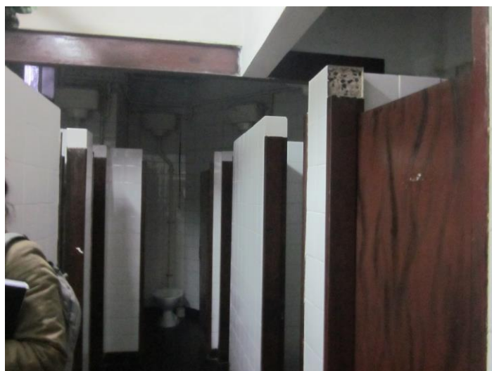
Foto "El Amparo baño 1° piso"
