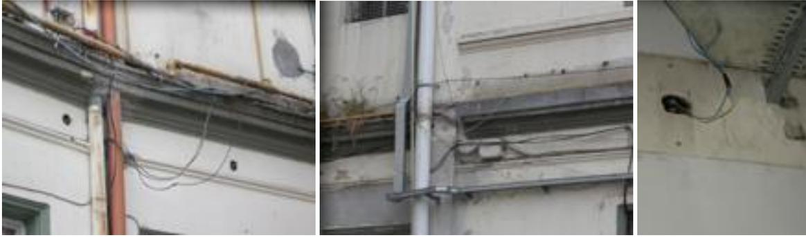
8.1.4 Filtraciones, algunas de ellas próximas a la instalación eléctrica
