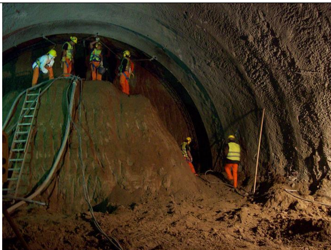
Frente de excavación. Túnel hacia Estación Las Heras.
