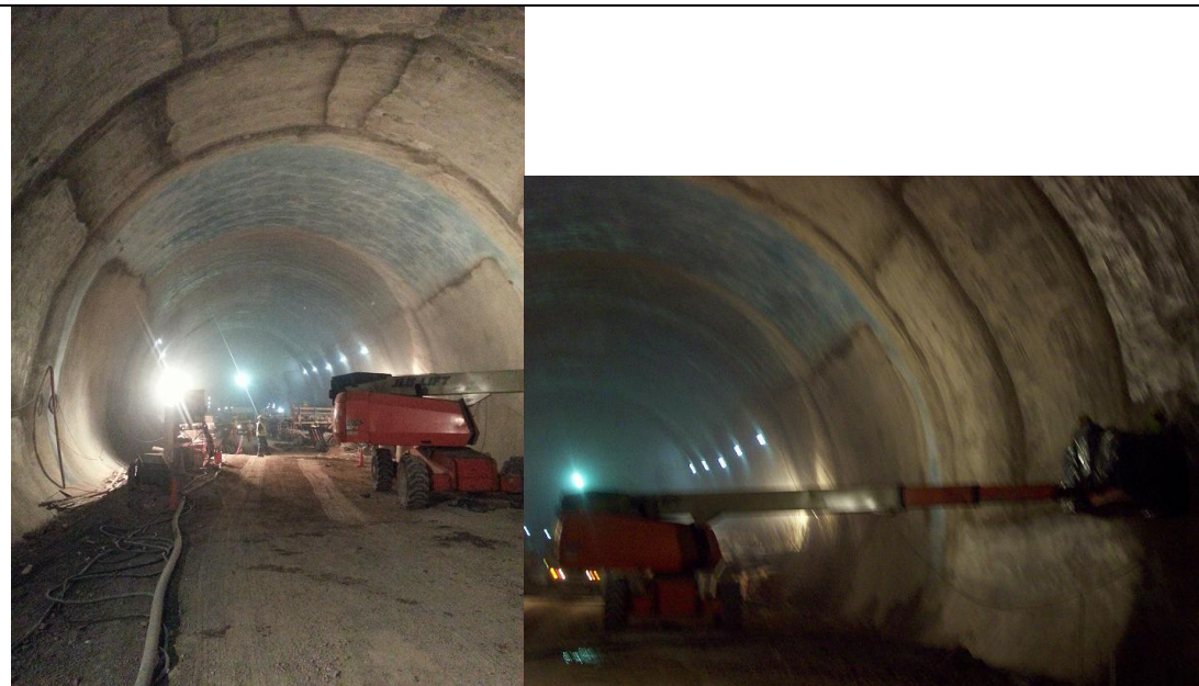
Estación Las Heras. Alisado para colocación de membrana hidrófuga (capa azul) y finalmente recubrimiento protector.
