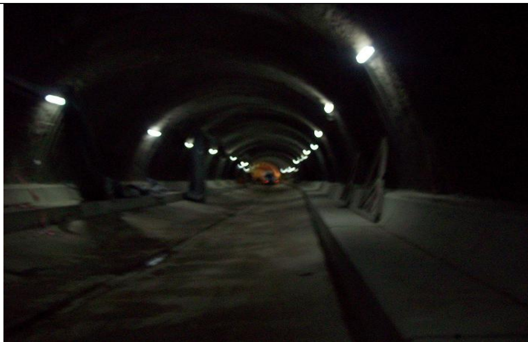
Túnel de acceso a futura Estación Plaza Francia
