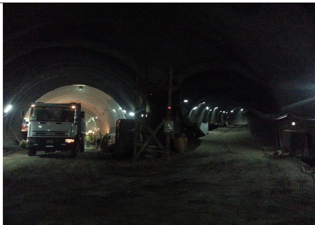
A la derecha rampa Pacheco de Melo a la izquierda túnel en dirección a Santa Fe.
