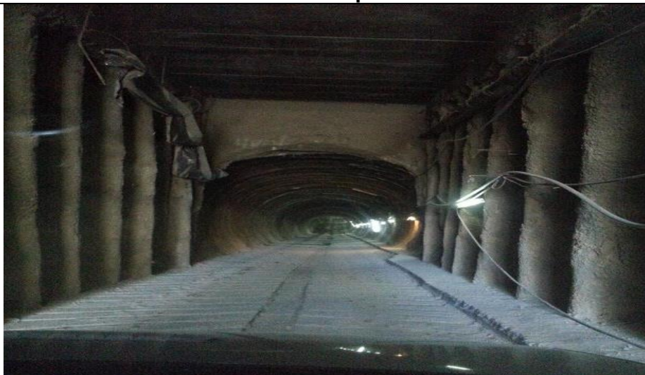
Acceso al túnel rampa mansilla.
