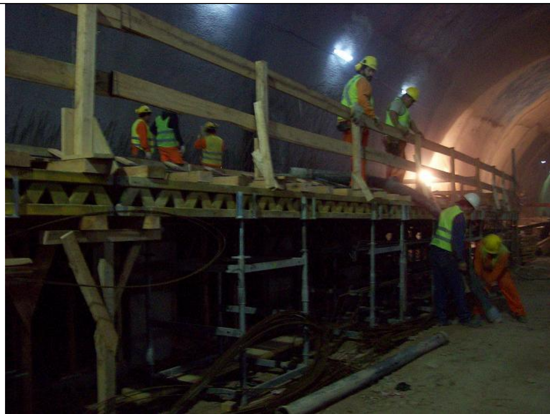
Estación Las Heras. Sector andenes.
