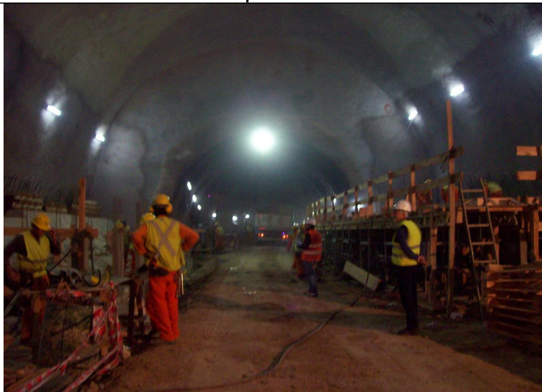
Estación Las Heras. Sector andenes.
