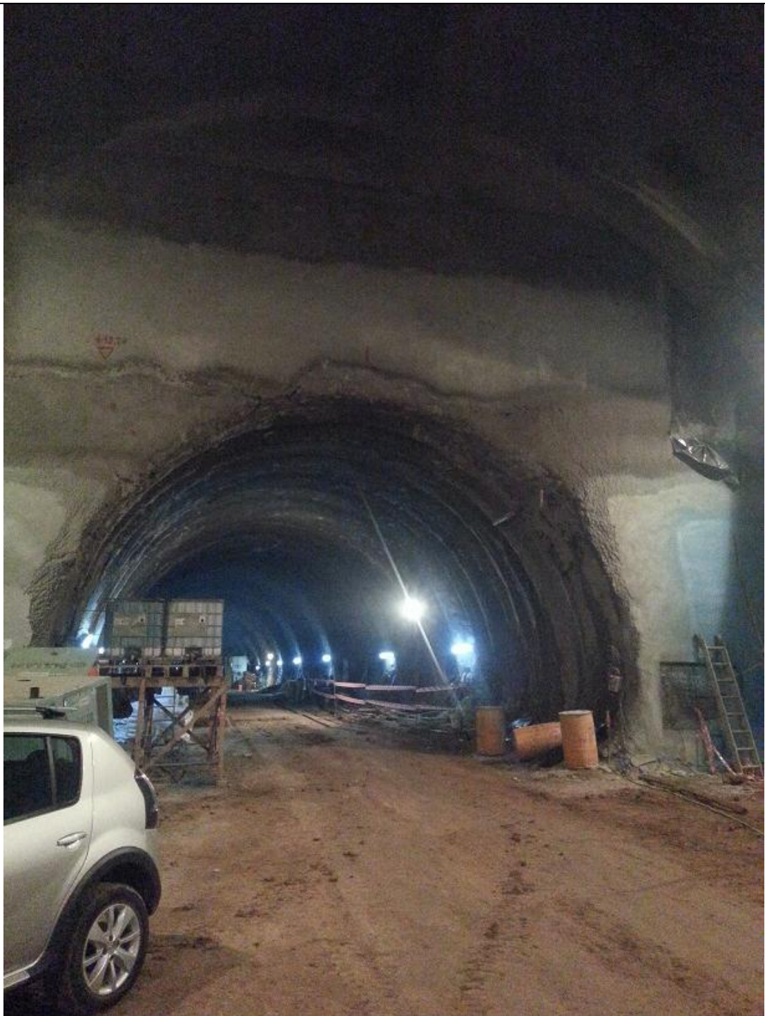
Acceso desde la Estación Santa Fe hacia el túnel.
