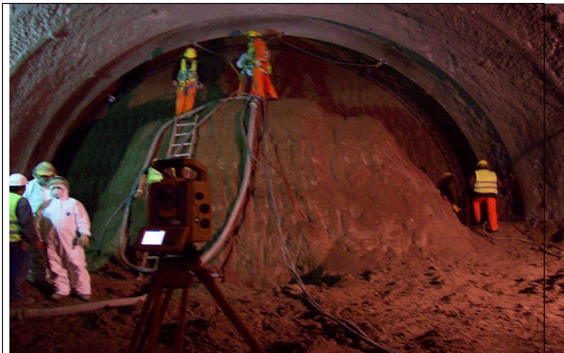
Frente de excavación. Túnel hacia Estación Las Heras.
