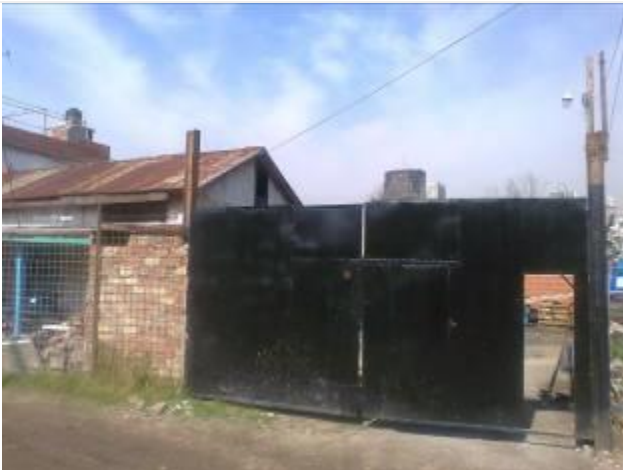
Foto 58 - Obrador de la Contratista en construcción sobre terrenos pertenecientes al FFCC
