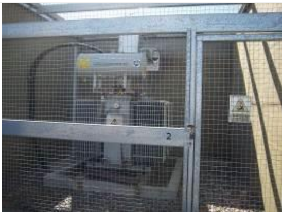
Foto 24 - Transformador
