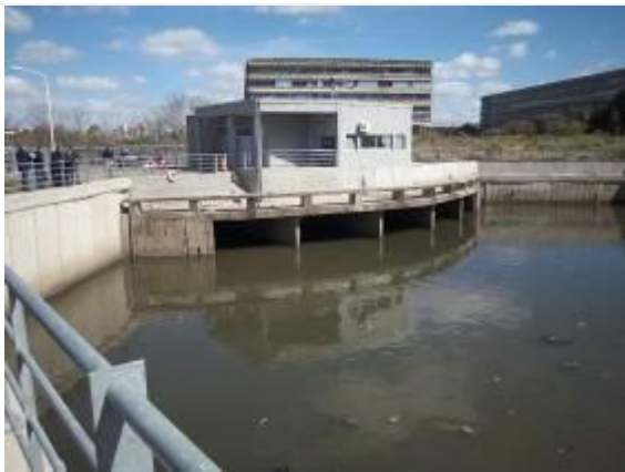
Foto 22 – Embalse en desembocadura de Arroyo Vega
