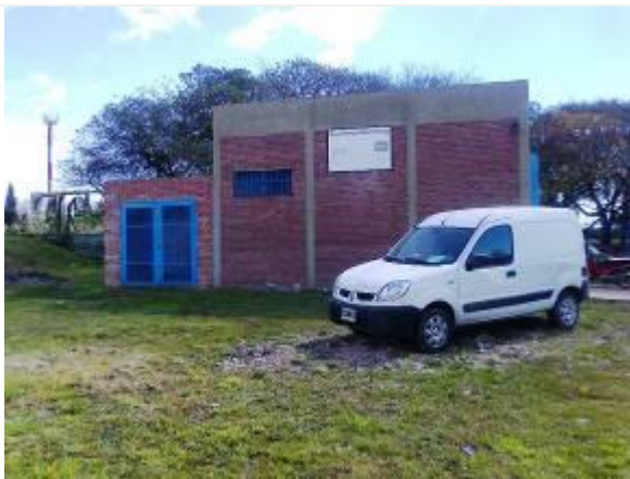
Foto 14 - Sala de Bombas “Nueva”
