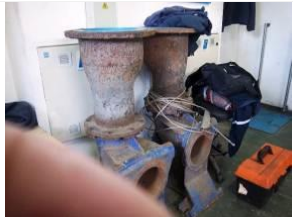
Foto 19 - Conductos herrumbrados fuera de servicio
