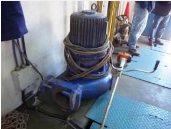
Foto 18 - Bomba fuera de servicio para reparación
