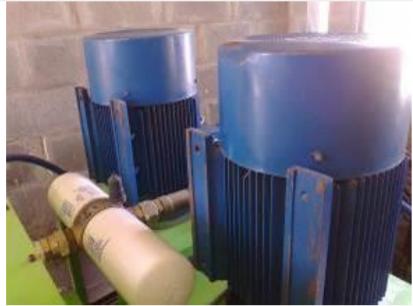
Foto 31 - Bombas del sistema hidráulico que recalientan
