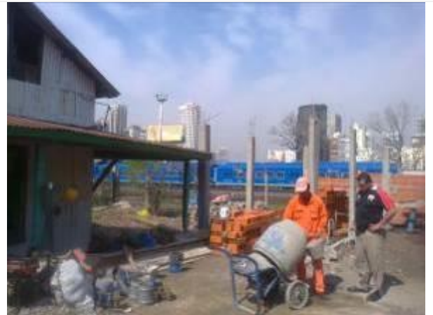
Foto 59 - Ejecución del Obrador de la Contratista
