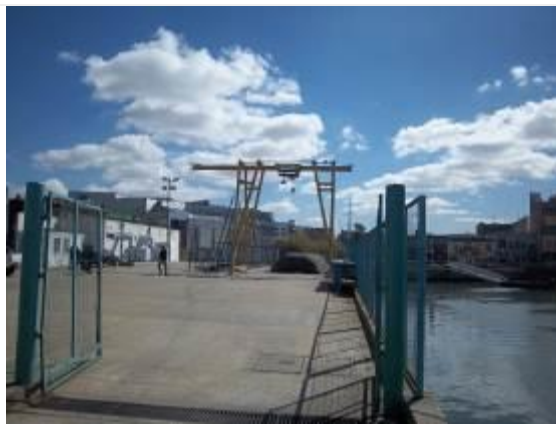
Foto 1 – Vista de Estación de bombeo Nº 1
