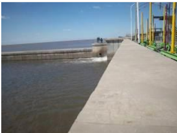
Foto 38 – Prueba de una bomba
