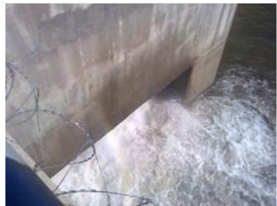
Foto 39 - Prueba de una bomba, otra vista
