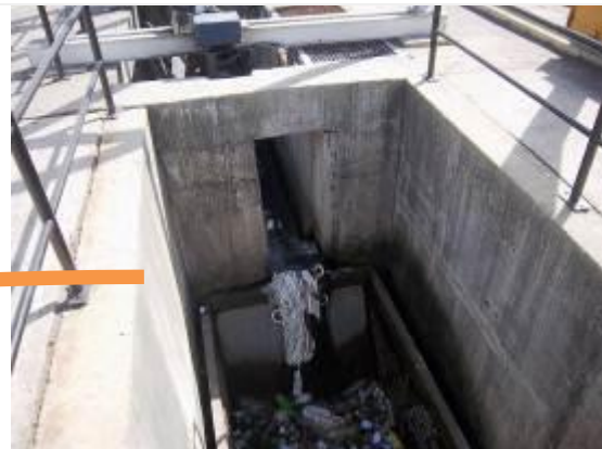
Foto 8 – Vista de contenedor de recolección de basura sobrenadante
