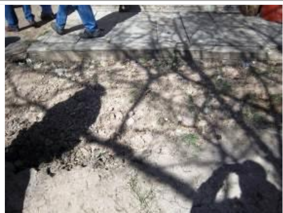
Foto 21 - Exterior de sala de bombas
