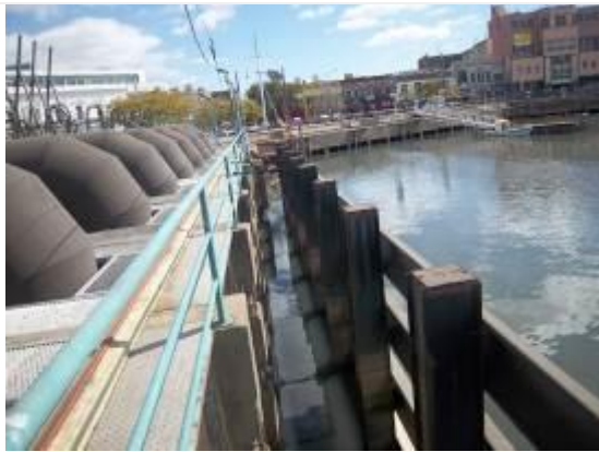
Foto 3 – Vista de salidas de Bombas
