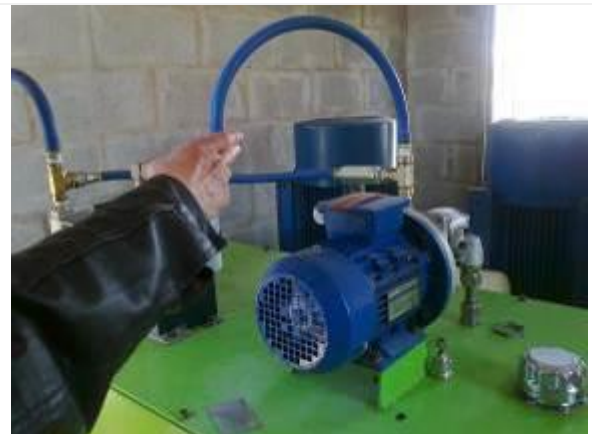
Foto 29 - Bombas del sistema hidráulico que recalientan
