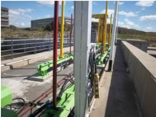
Foto 26 - Sistema hidráulico para la operación de las compuertas
