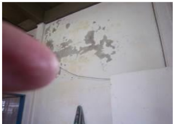
Foto 16 - Revoques deteriorados, Filtración de Humedad en muros de sala de Bombas
