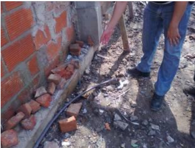
Foto 62 - Instalación , conexión domiciliaria clandestina
