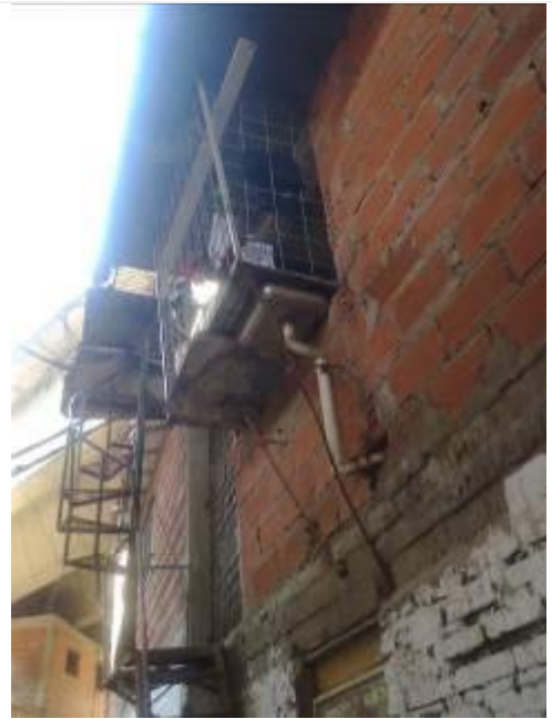
Foto 57 - Irregularidades de las instalaciones existentes
