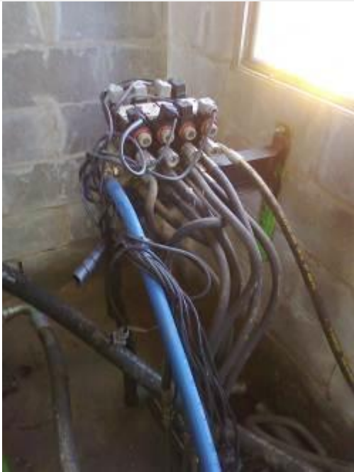
Foto 30 - Detalle de terminación de instalación de cableado
