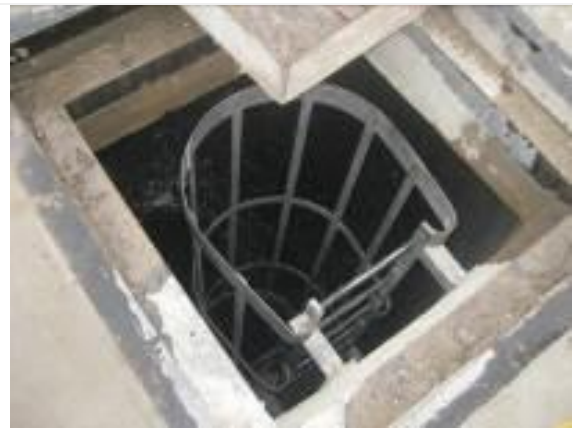
Foto 67 - Acceso a Túnel Corto – A° Maldonado
