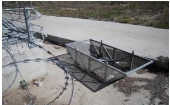
Foto 33 - Contenedor especial para basura retenida en rejillas de filtrado
