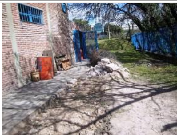
Foto 20 - Exterior de sala de bombas
