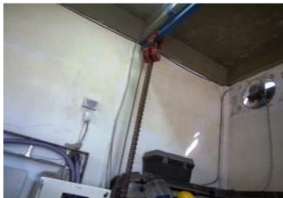
Foto 17 - Filtración de Humedad en muros de sala de Bombas
