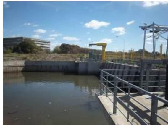
Foto 23 - Embalse en desembocadura de Arroyo Vega
