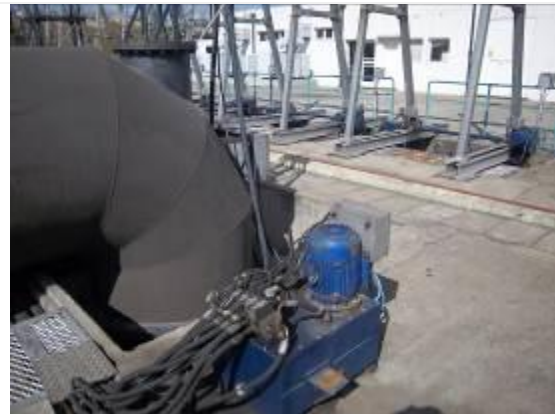
Foto 4 – Detalle de conexiones
