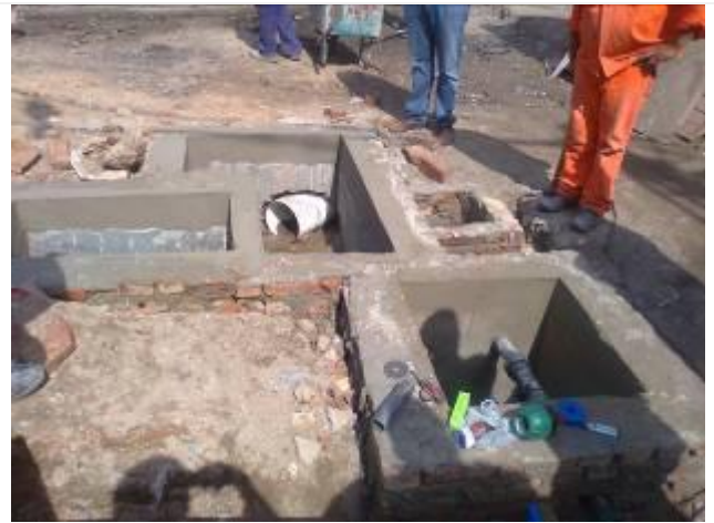
Foto 63 - Instalación en ejecución
