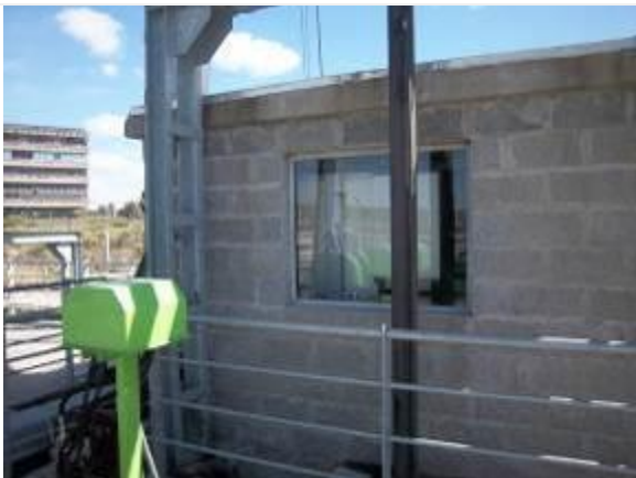
Foto 28 - Casilla que aloja el sistema Hidráulico
