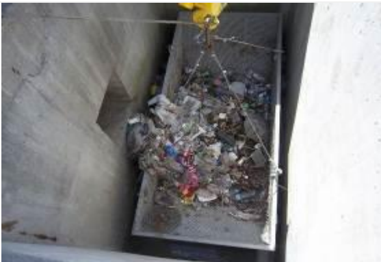
Foto 32 - Contenedor especial para basura retenida en rejillas de filtrado
