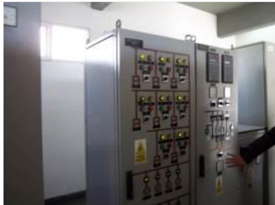
Foto 5 – Controles Est. Bombeo Nº 1
