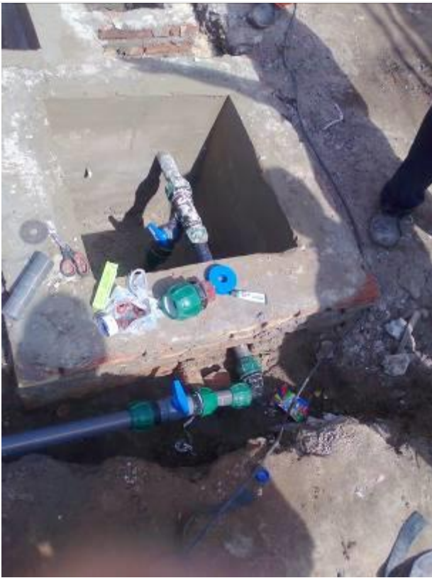
Foto 60 - Instalación en ejecución
