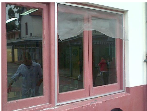
3 y 4– Faltante de vidrios y mosquiteros rotos en ventanas del comedor escolar.
