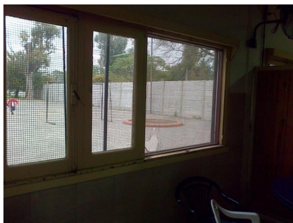
3 y 4– Faltante de vidrios y mosquiteros rotos en ventanas del comedor escolar.
