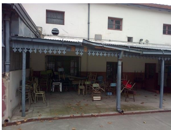
5– Canaleta en patio desprendida. 6- Reparaciones que necesitan terminación en sala de teatro y danzas.
