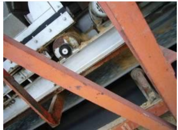
Foto N° 5 Tolva de dosificación de arena
