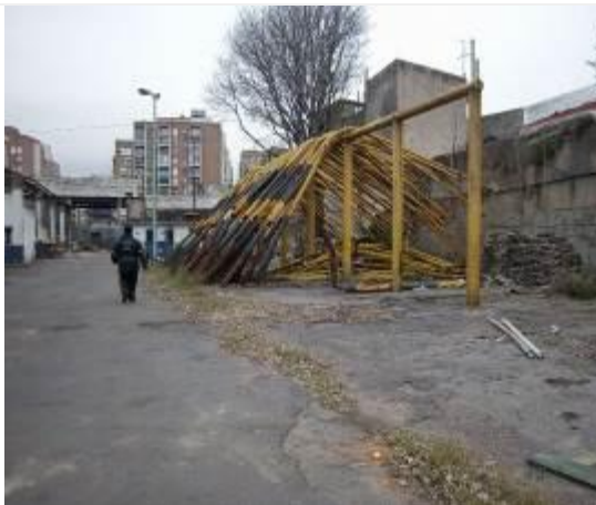
Foto N° 85 Vista Interna Obrador
