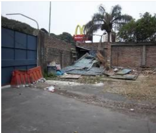
Foto N° 89 Vista Interna Obrador
