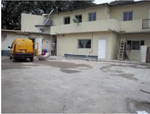
Foto N° 92 Vista Interna – Sector Oficinas
