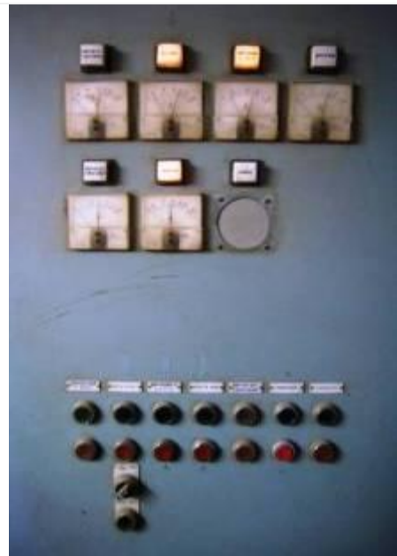
Foto Nº 15 Medidores y niveladores
