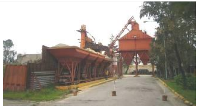
Foto N° 2 Playón de descarga de tolvas de almacenamiento para dosificación
