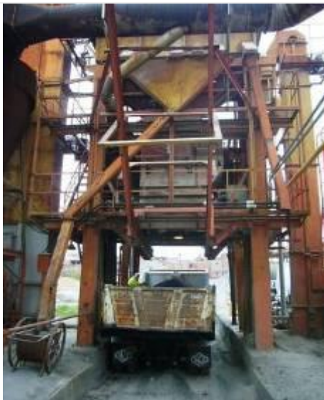
Foto N° 10 Descarga de mezcla terminada en camión
