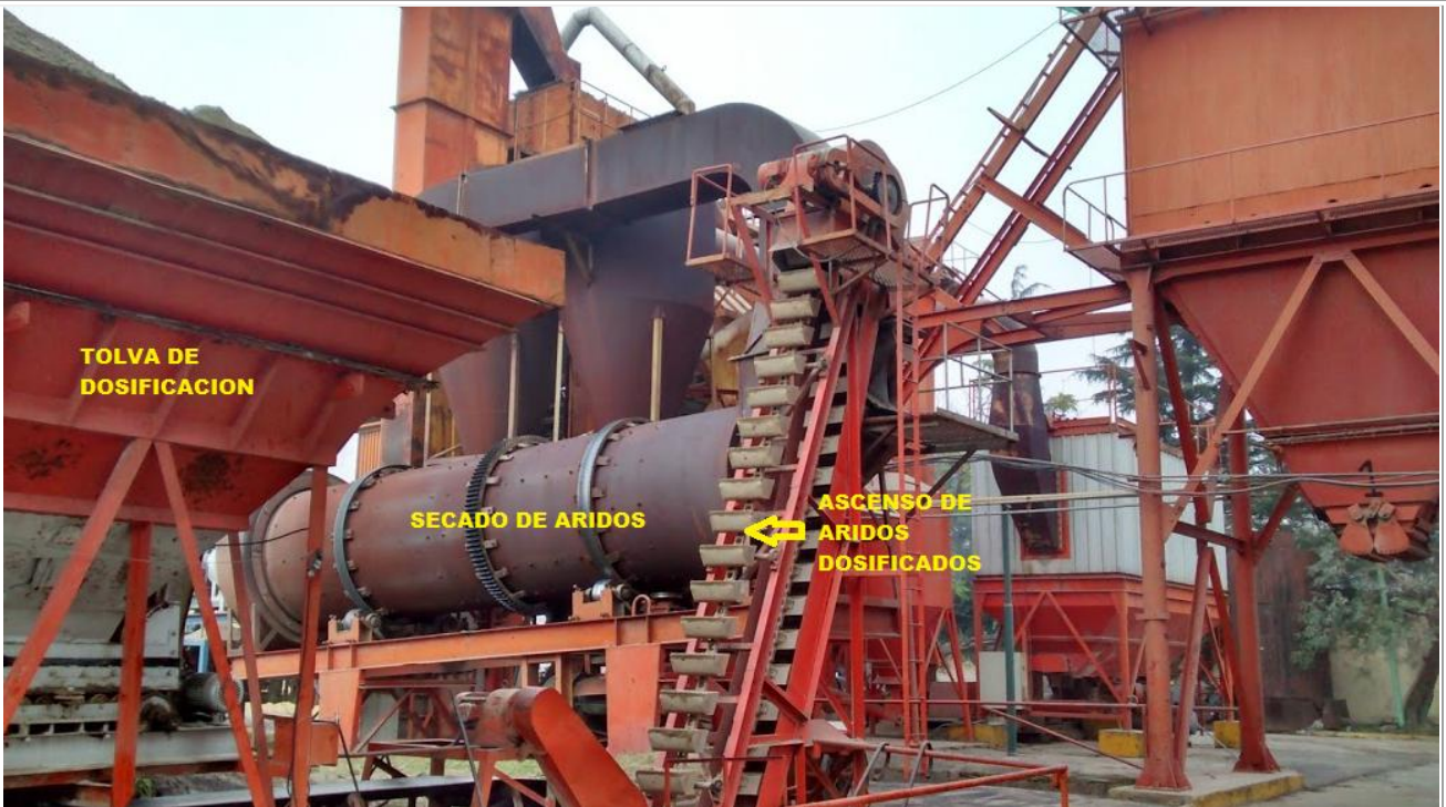
Foto N° 9 Vista general de la Planta Asfáltica - ascenso de áridos dosificados Túnel de secado de áridos por calor
