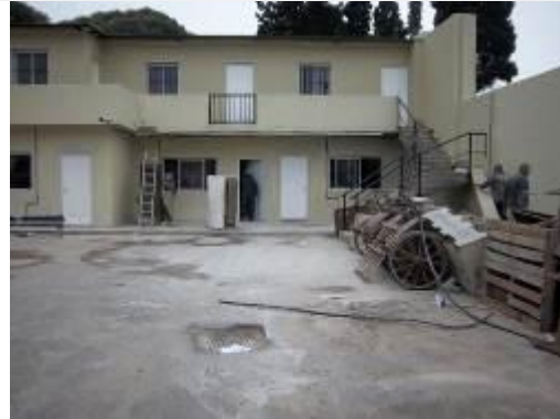
Foto N° 93 Vista Interna – Sector Oficinas
