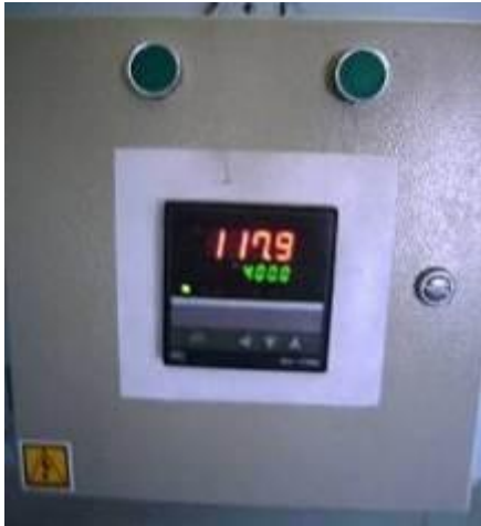
Foto Nº 12 Medidor de Temperatura de Mezcla
