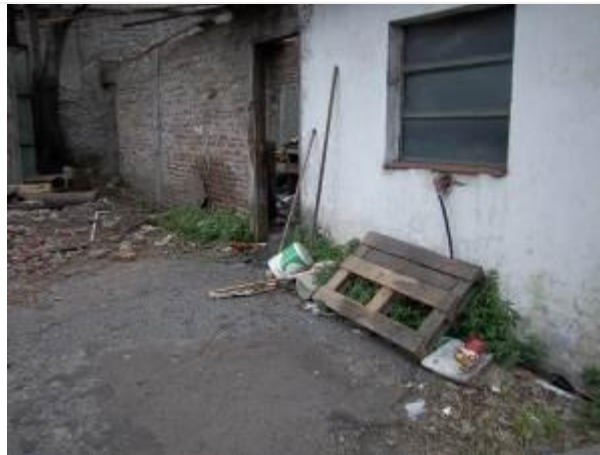
Foto N° 84 Vista Interna Obrador
