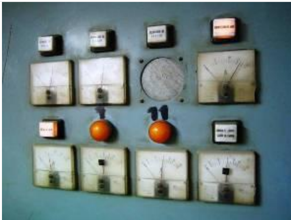
Foto N° 16 Tablero de indicadores
