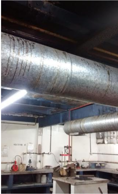
Foto Nº 18 Vista general del Laboratorio
