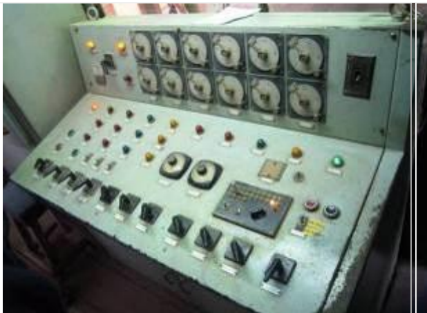
Foto Nº 14 Control Principal de Planta
