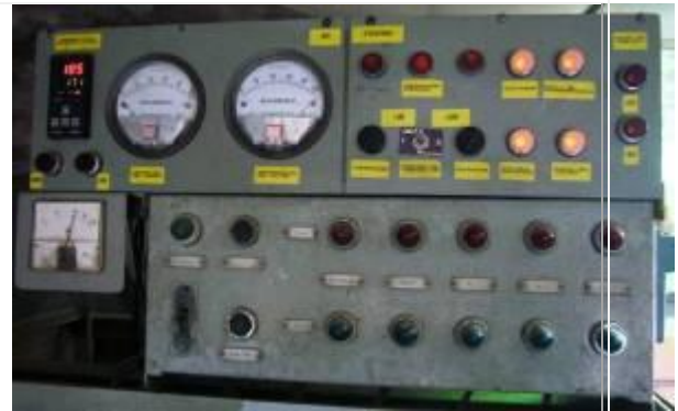
Foto N° 17 Indicadores de filtro y válvulas
