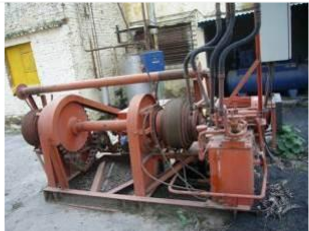
Foto N° 11 Sistema de poleas, cadena y cable fuera de uso, pertenecientes a las tolvas de almacenamiento
