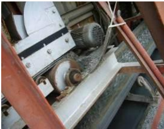
Foto N° 4 Tolva de dosificación de áridos
