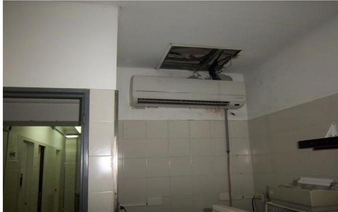
Equipo de Aire acondicionado funcionando en mal estado 1 - Obs N° 26.
