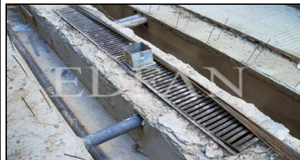
Detalle del conducto central y conexión pluvial de frentistas. Conductos laterales para servicios. Rejillas
