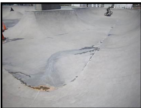
Foto 3. Slalom. Filtraciones de agua Foto 4. Slalom. Filtraciones de agua
