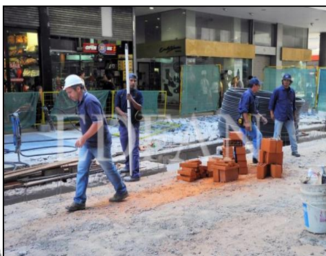
Construcción contrapiso, canal central, piso parcialmente ejecutado, pasarela peatonal entre vallado y línea municipal.
