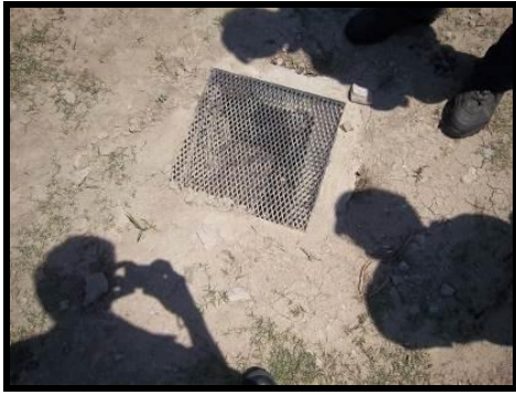
Foto 11. Caja de desagüe reparada
