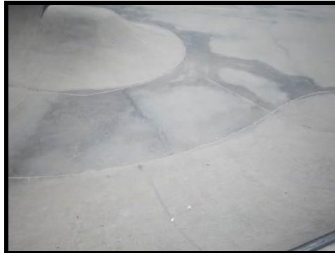
Foto 1. Slalom. Humedad por filtraciones Foto 2. Slalom. Humedad por filtraciones
