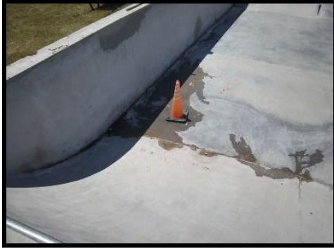
Foto 5. Slalom. Filtraciones de agua
