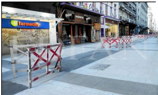
Vista del solado terminado. Vallas de protección sobre las tapas de acceso.
