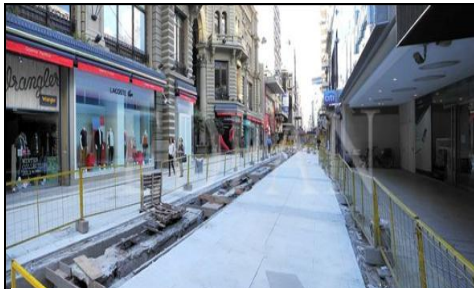
Vallado de protección volcado. Demolición piso existente y contrapiso en ejecución. Canal central en ejecución. Solado parcialmente ejecutado y pasarela peatonal.
