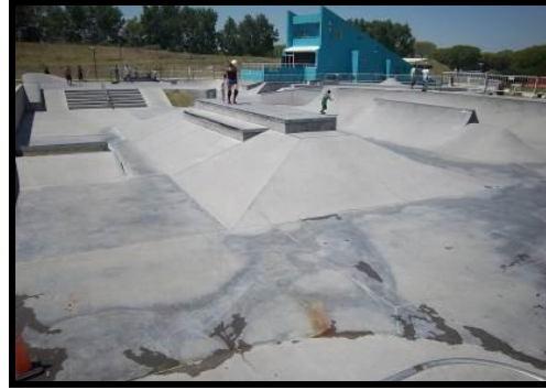
Foto 6 Slalom. Filtraciones de agua
