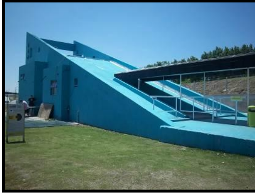
Foto 12. Edificio Sardini - Administración
