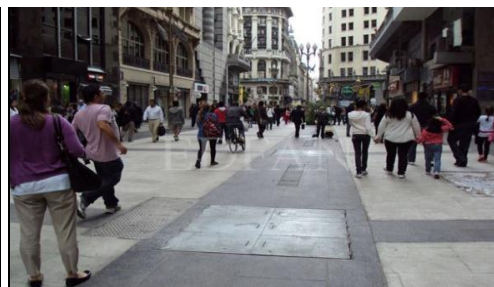
Vista del solado terminado y habilitado al público, tapa de acceso sin macetero y tapa de servicios existente fuera del sector central.
