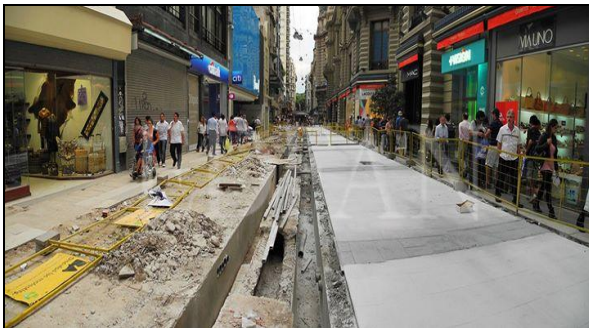
Vallado de protección caído. Conducto central y piso parcialmente ejecutado. Vallado de protección colocado
