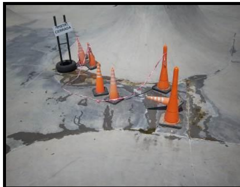
Foto 3. Slalom. Filtraciones de agua Foto 4. Slalom. Filtraciones de agua
