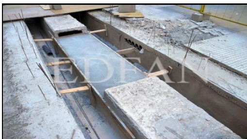
Vista del canal central en ejecución. Vallado de protección. Demolición parcial del piso existente.
