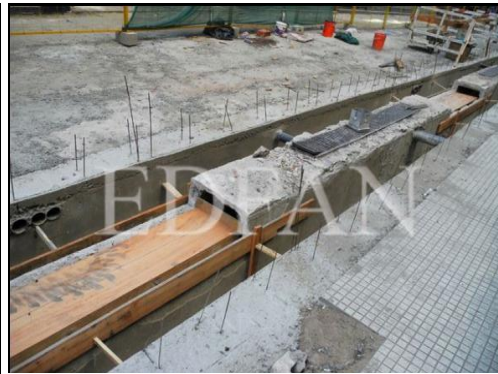
Vallado de protección. Detalle del canal central, conexiones pluviales, conductos laterales para servicios piso sin demoler.
