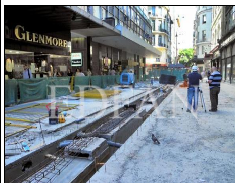
Pasarela de protección peatonal. Piso existente sin demoler. Canal central. Construcción nuevo contrapiso.
