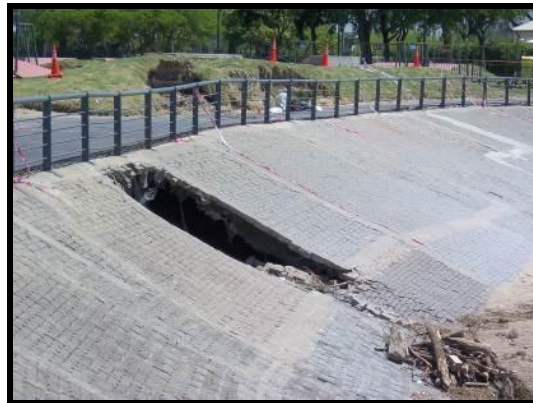
Foto 14. Defensa de costa, hundimiento
