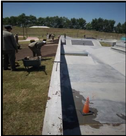
Foto 7. Slalom Reparación filtraciones
