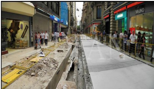
Solado parcialmente ejecutado. Canal central en construcción. Vallado de protección peatonal.
