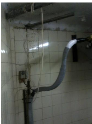
Instalación mal estado
