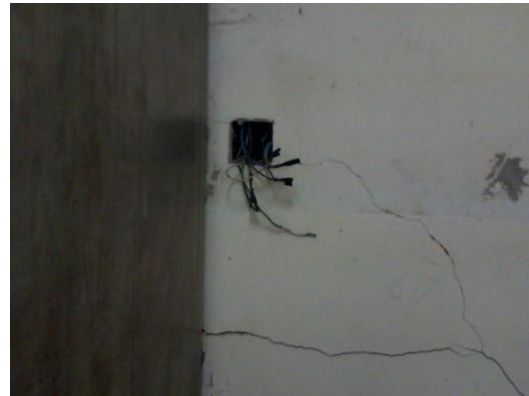
Mal estado de mantenimiento
