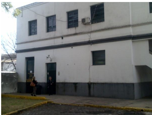
Pabellón en regulares condiciones exteriores
