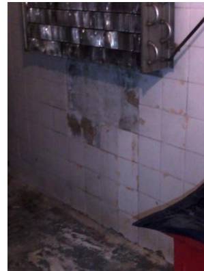
Paneles de frío y paredes en muy mal estado
