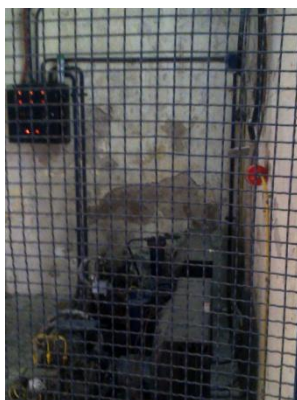
Equipos de enfriamiento
