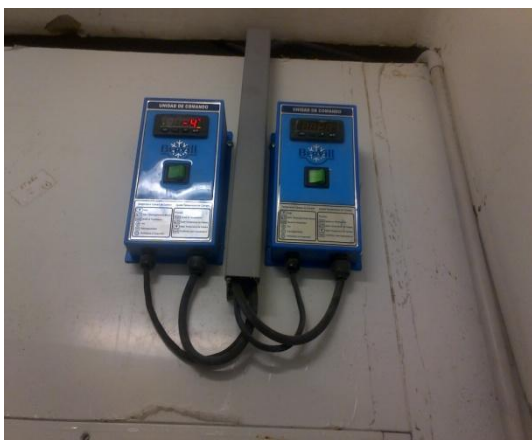
Control de temperatura exterior
