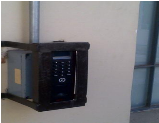
Control digital de acceso
