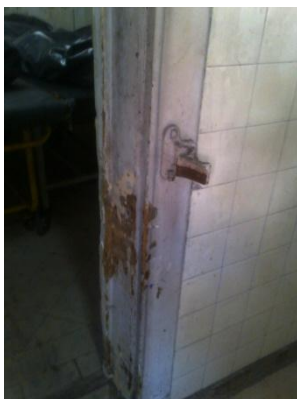
Puerta acceso antecámara en mal estado
