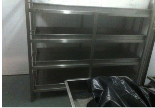
Equipamiento interior en buenas condiciones
