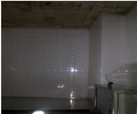
Filtraciones en cielorraso
