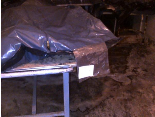
Estado general malo
