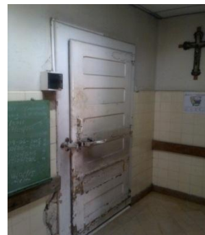
Puerta acceso antecámara en mal estado
