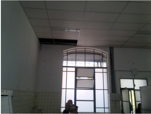
Cielorrasos desmontables en regular estado
