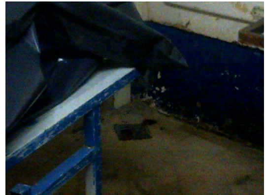
Antecámara en mal estado de mantenimiento
