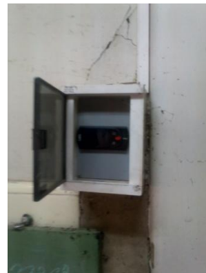
Control de temperatura
