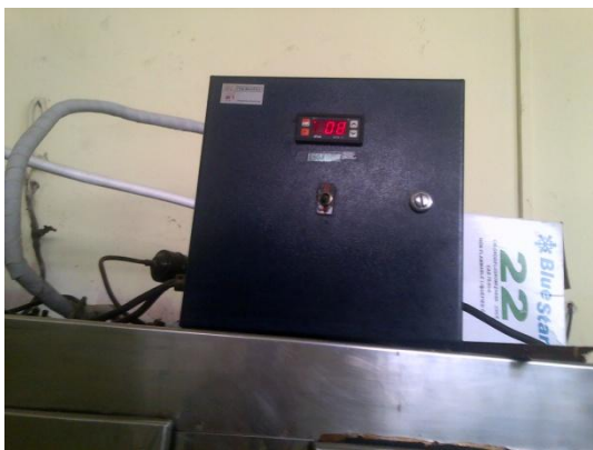
Control de temperatura exterior
