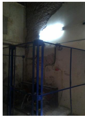
Mal estado de mantenimiento
