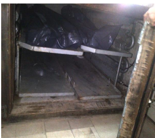
Interior de la cámara en mal estado
