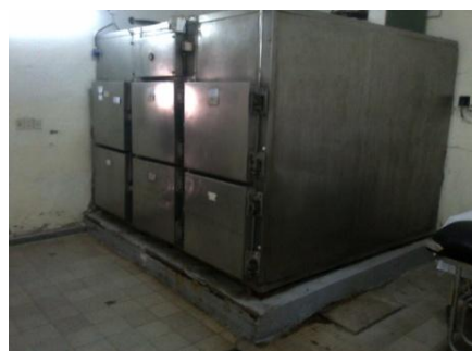
Cámara en regular estado
