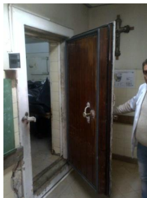
Puerta acceso antecámara en mal estado
