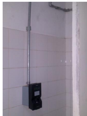
Control digital de acceso
