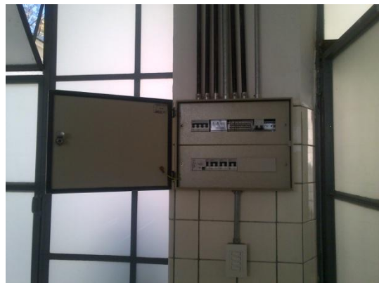
Instalación eléctrica nueva
