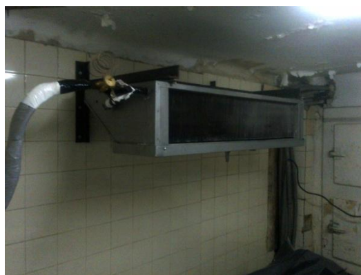
Refrigeración antecámara (no funciona)
