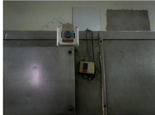
Control de temperatura obsoleto
