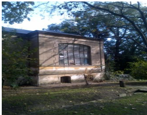
Exterior en malas condiciones
