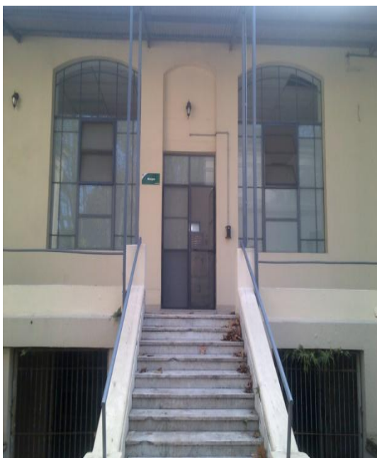
Morgue y servicio de Anatomía Patológica Falta rampa de acceso
