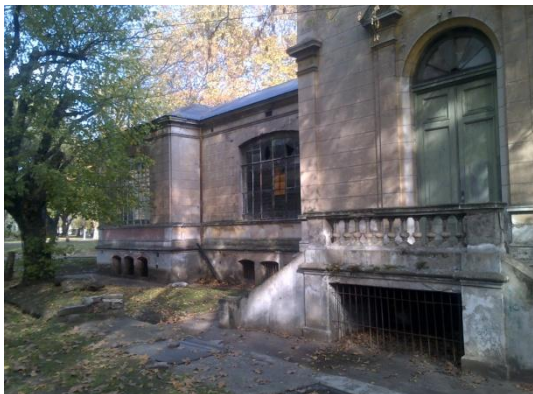
Estado exterior del edificio en muy malas condiciones
