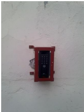
Control digital (en instalación)
