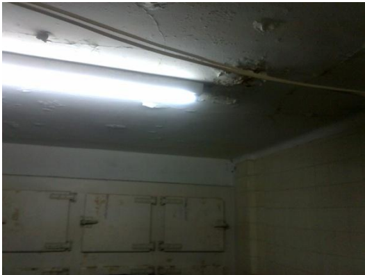
Antecámara en mal estado de mantenimiento
