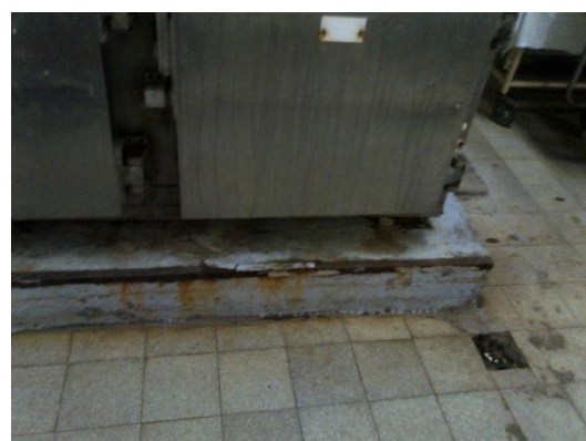
Mal estado general
