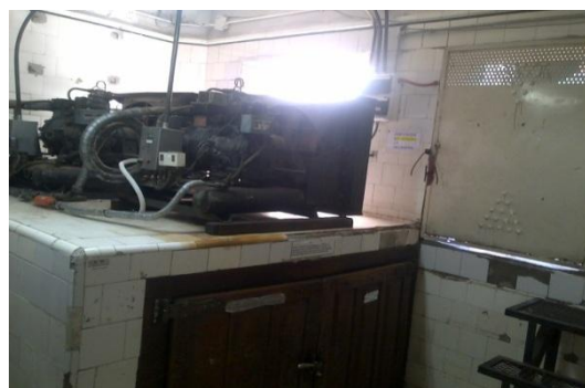
Equipos de refrigeración en regular estado
