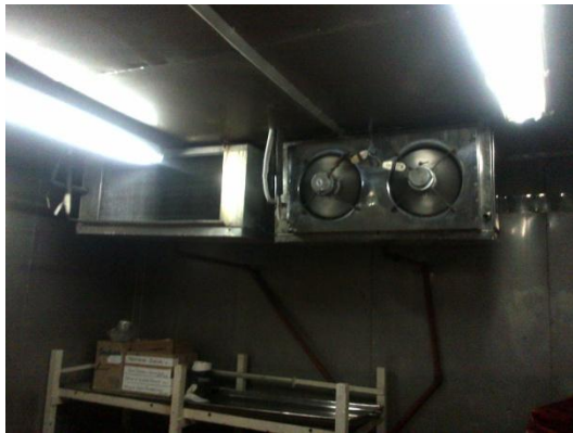
Cámara y equipos de frío en buenas condiciones
