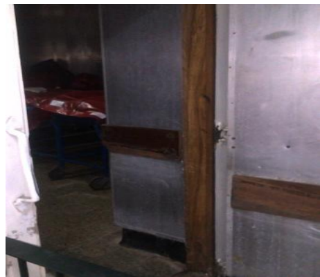
Puerta cámara en regulares condiciones
