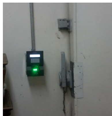
Control digital de acceso
