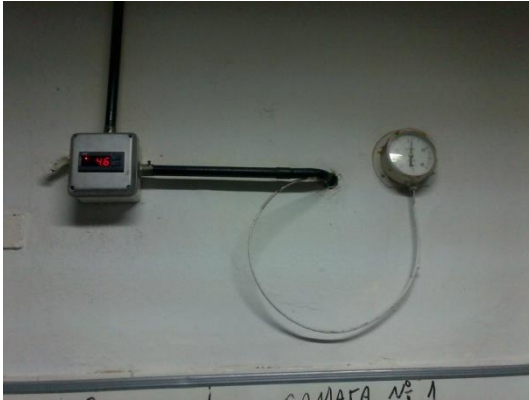
Control de temperatura exterior
