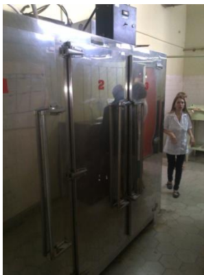
Cámara ubicada en una circulación interna
