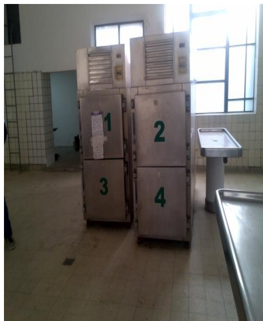
Cámaras en regular estado. Cantidad 4
