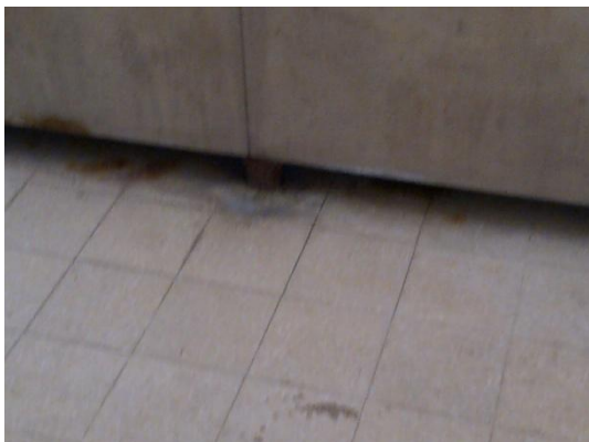
Cámaras en regular estado
