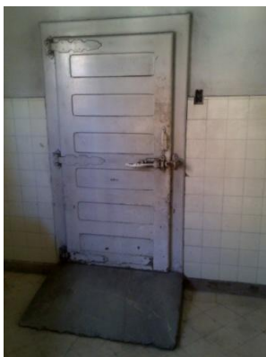
Puerta acceso antecámara en mal estado
