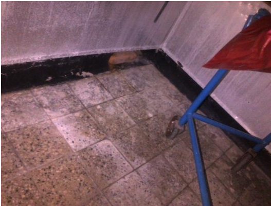
Interior de la cámara en regulares condiciones
