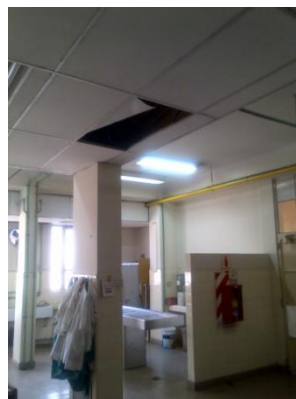
Sala autopsias en regular estado
