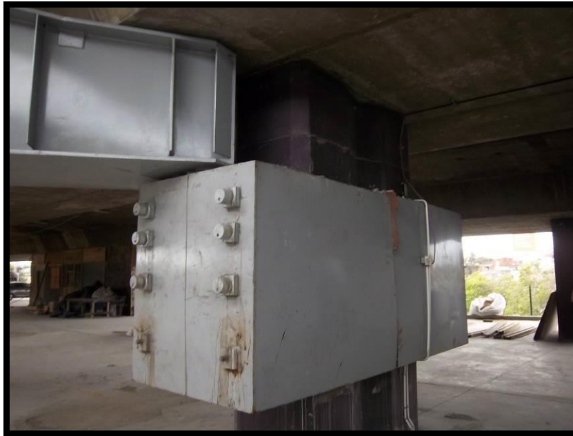
Figura 6 – Vista de capitel con apoyo de viga transversal en estacionamiento Estación Plaza de los Virreyes de la Línea de Subte E
