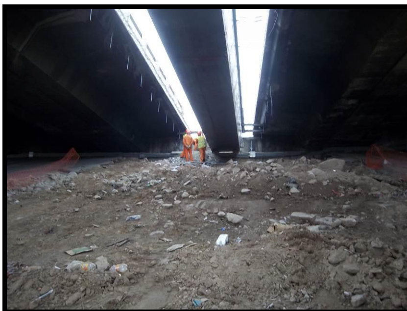
Figura 4 – Vista de comienzo de la viga cajón longitudinal en terraplén de Av. Lafuente
