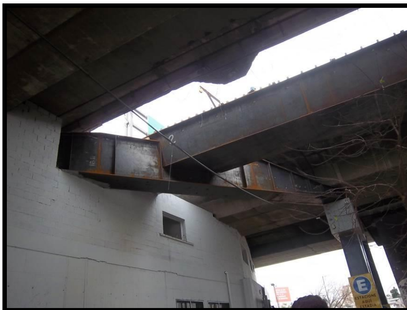
Figura 3 – Vista de la viga cajón longitudinal con rebaje del alma para respetar altura reglamentaria del estacionamiento de la Estación Plaza de los Virreyes de la Línea de Subte E
