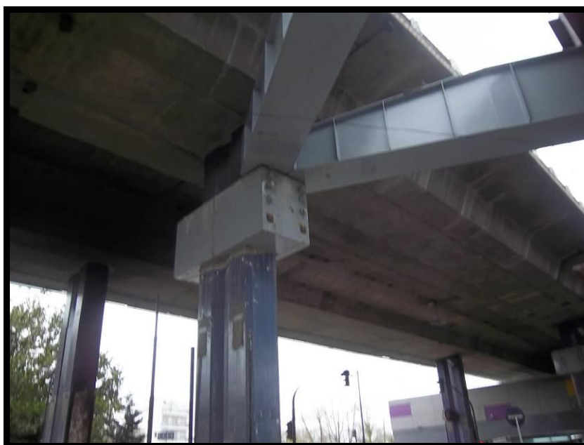
Figura 5 – Vista de apoyos de las vigas transversales sobre el capitel
