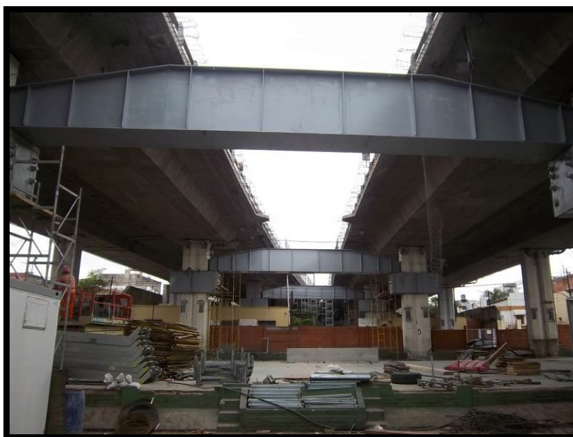
Figura 2 – Vista de los refuerzos de columna y de las vigas transversales sin la viga cajón longitudinal montada
