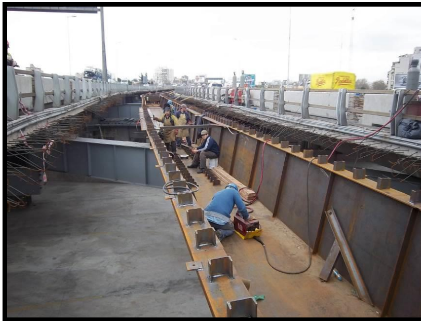
Figura 7 – Vista de la viga cajón longitudinal, apoyada sobre las vigas transversales, sobre la cual se construirá la losa de vinculación rígida de ambos tramos de la autopista. Se observan, además, los anclajes previstos para vincular la losa futura a los viaductos existentes
