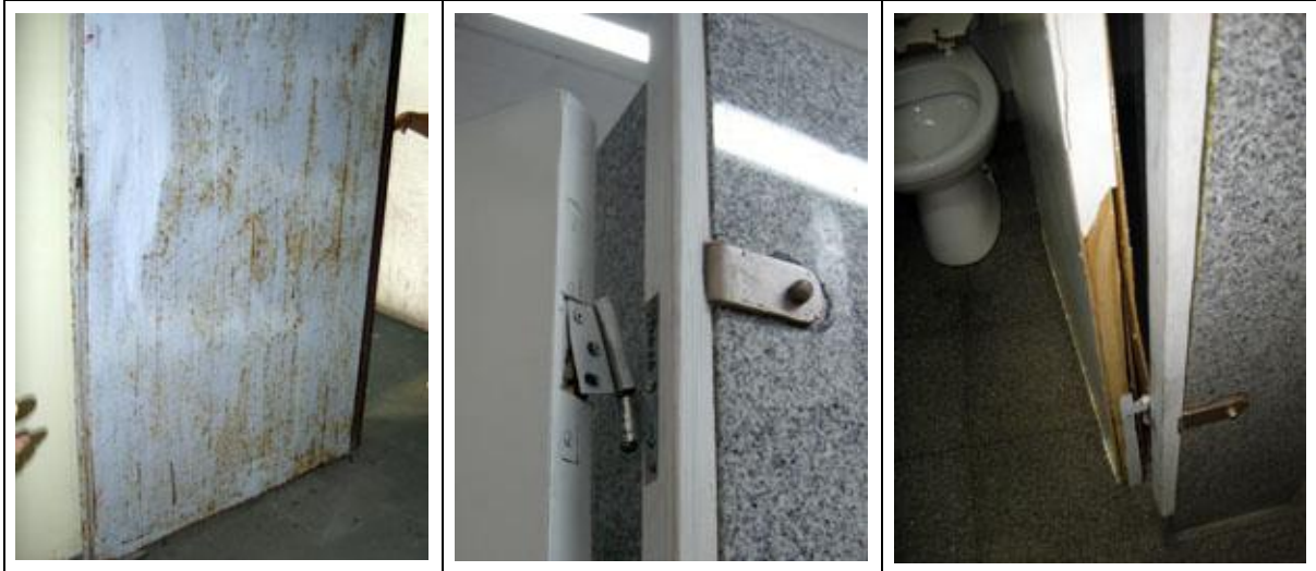
Puertas y bisagras rotas u oxidadas.
