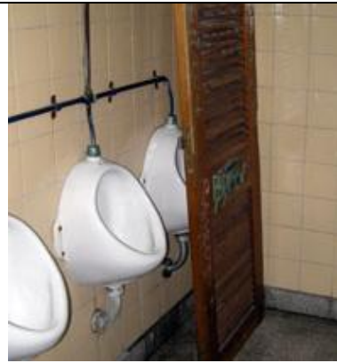
Algunos de los sectores con puertas y ventanas rotas o fuera de su lugar, piezas de revestimiento faltantes y revoques desprendidos.
