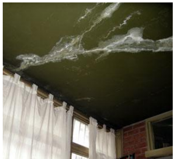
La membrana hidróduga rota de la terraza, facilita el ingreso de humedad en varias aulas.
