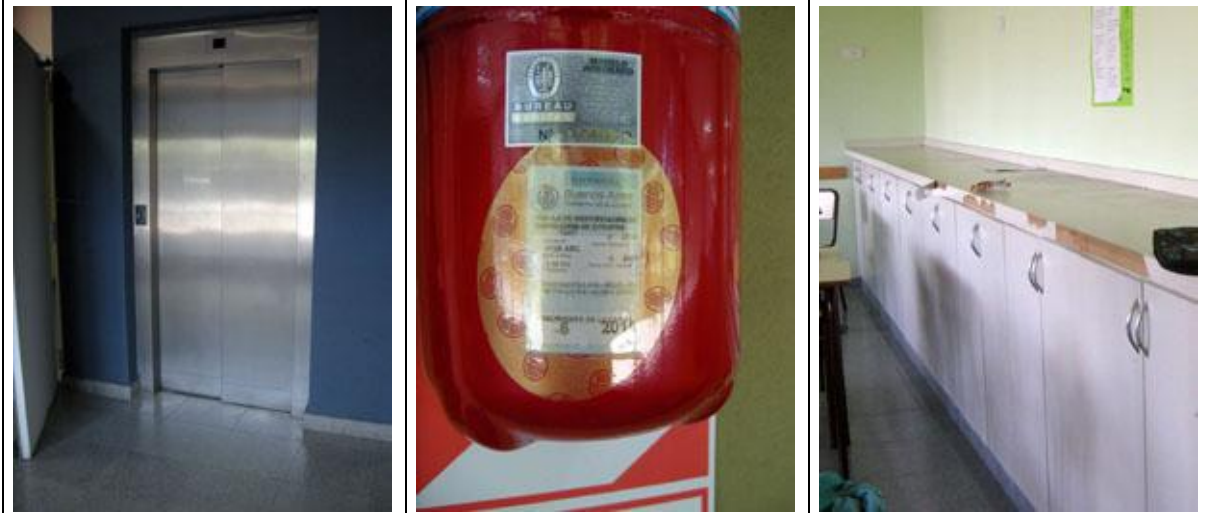
El ascensor no se detiene en el 2do piso.
