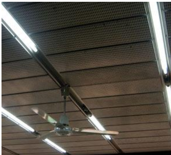
Ventiladores que no funcionan y artefactos de iluminación que parpadean o les faltan los precintos de seguridad.
