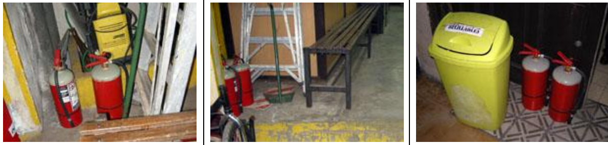
Extintores de incendio ubicados en lugares inadecuados, con accesos obstruidos con equipamiento.
