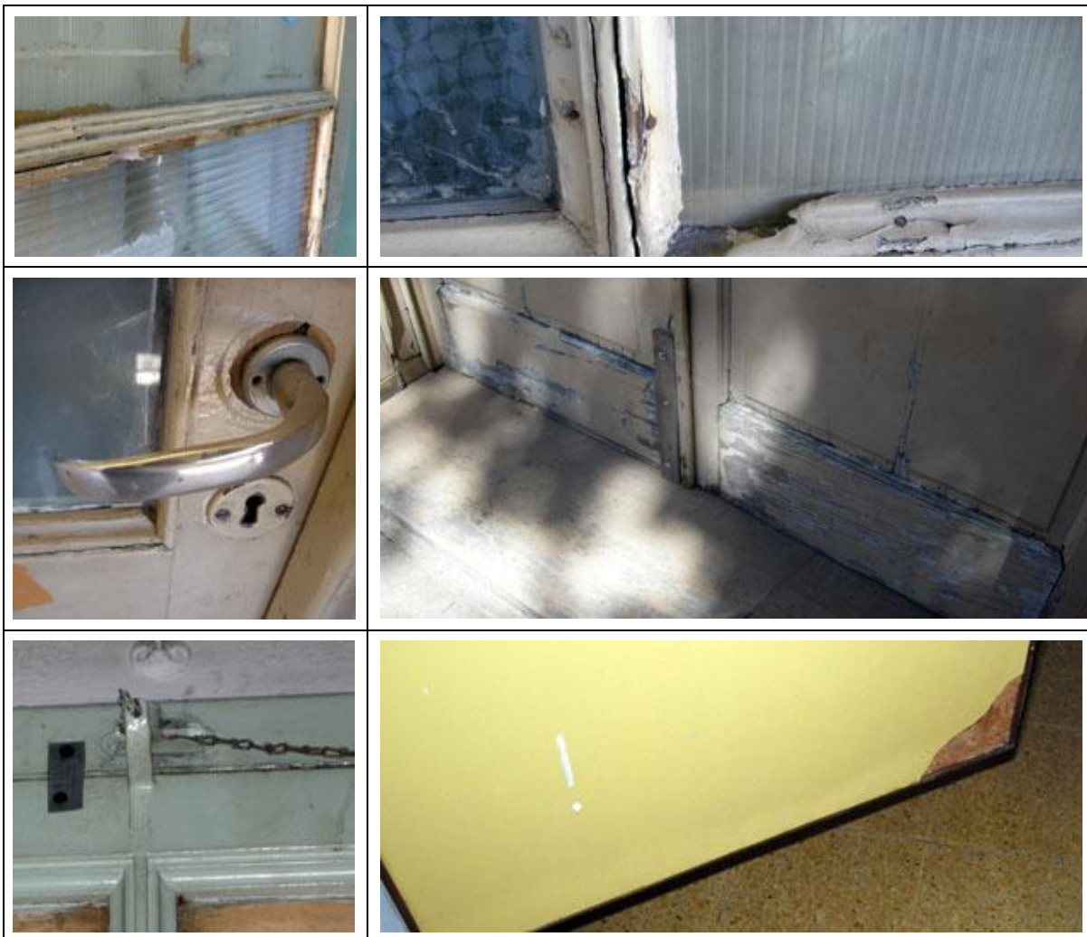
Los vidrios rotos reemplazados por policarbonato. Elementos de marcos y hojas de ventanas y puertas rotos. Piezas de revestimiento de piso y pared rotas, faltantes o desprendidas. Manchas de humedad y pintura desprendida en varios sectores.
