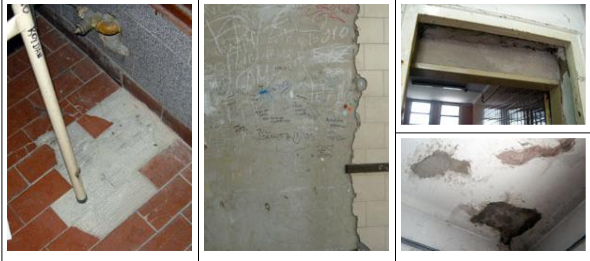
Piezas de revestimiento faltantes el pisos y paredes y revoques sin pintar.
