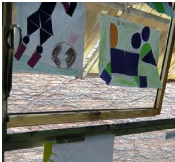
Herrajes faltantes y mecanismo de accionamiento de las banderolas deteriorado.
