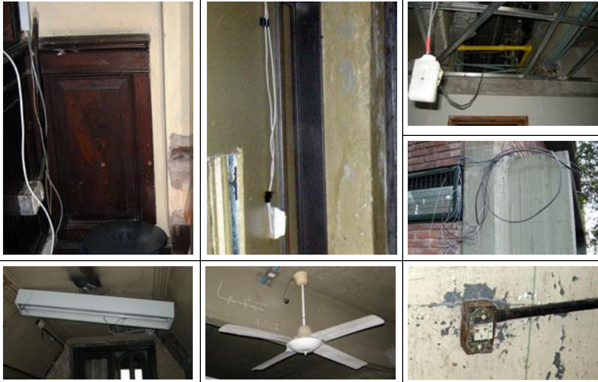
Instalación eléctrica con cables sueltos en diferentes sectores del establecimiento. El contacto de algunos con humedad generó paredes electrificadas. Hay ventiladores que no funcionan correctamente.
