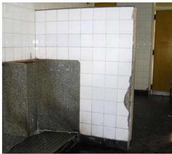
Piezas de revestimiento cerámico de pared rotas y faltantes.
