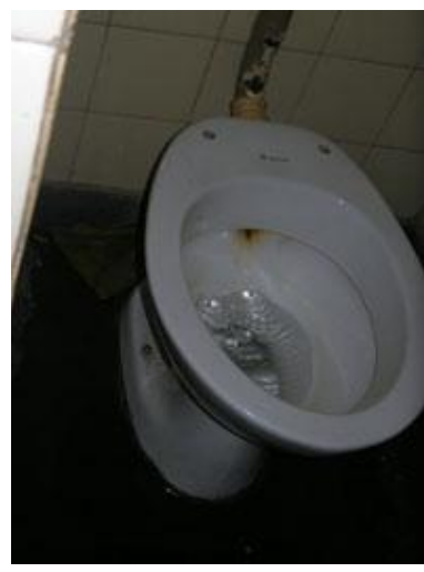
Depósitos de inodoro con flotantes rotos dejan correr agua en forma permanente.
