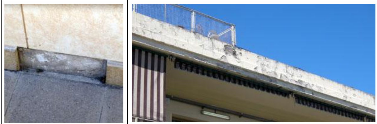
Los vidrios rotos reemplazados por policarbonato. Elementos de marcos y hojas de ventanas y puertas rotos. Piezas de revestimiento de piso y pared rotas, faltantes o desprendidas. Manchas de humedad y pintura desprendida en varios sectores.
