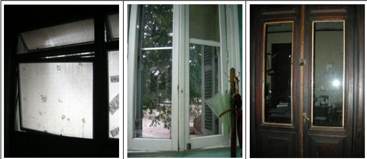
Ventanas que permanecen abiertas por tener sus herrajes rotos. Ventanas y puertas con herrajes y cerraduras reemplazados por otros de menor calidad.
