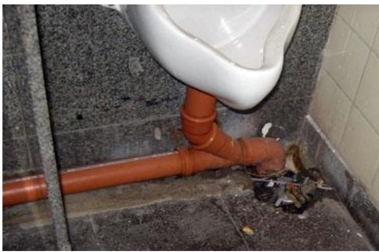
Empalmes de caños mal sellados por las que se filtran los desechos y cajas de desagüe sin rejillas.
