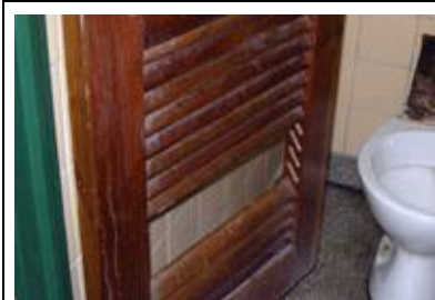
Algunos de los sectores con puertas y ventanas rotas o fuera de su lugar, piezas de revestimiento faltantes y revoques desprendidos.
