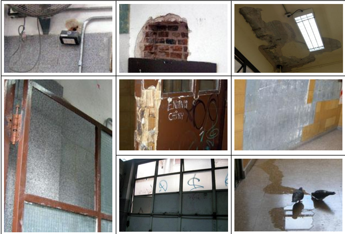
Puertas y ventanas rotas o con vidrios faltantes, permanecen abiertas y permiten el ingreso de palomas. Todas las aulas tienen filtraciones de humedad en los techos y algunas en las paredes.
