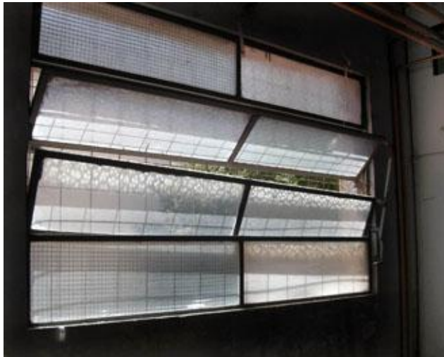
Herrajes que no funcionan, ocasionando que algunas ventanas permanezcan abiertas y faciliten el ingreso de palomas.
