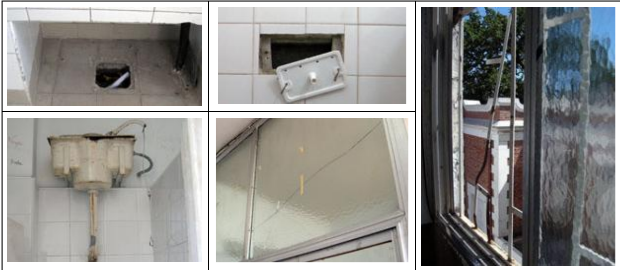
Hay desagües obstruidos, sin tapas, depósitos de inodoros que no funcionan, vidrios rotos y faltantes.
