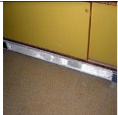
Piezas de piso, zócalos y cielorrasos, faltantes en terraza y otros sectores del edificio. Este y otros factores, causan el ingreso de humedad.
