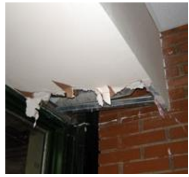
Marcos de ventanas oxidados y herrajes con reparaciones precarias
