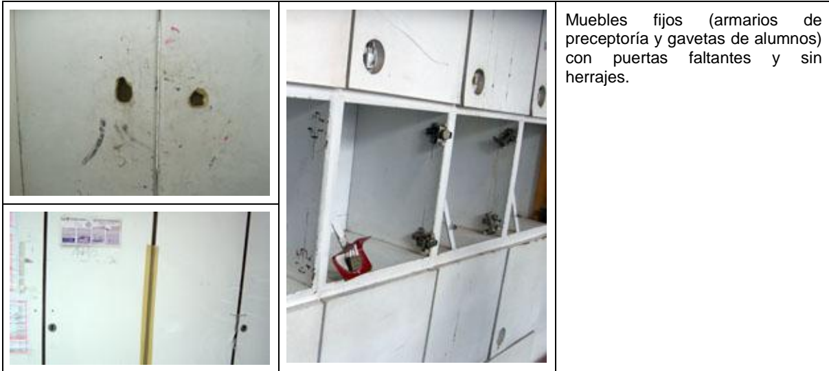
Puertas y bisagras rotas u oxidadas.
