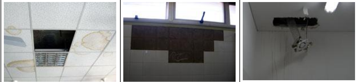
Manchas de humedad, piezas de revestimiento faltantes, extractor desprendido, y perforaciones en techos.
