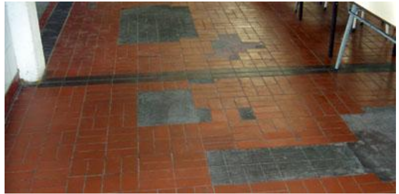
Revestimiento de piso con piezas faltantes
