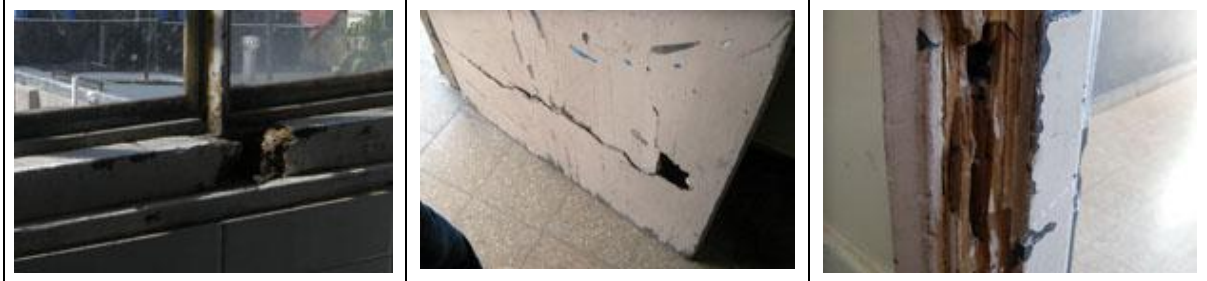
Pizarrones, dinteles, y revestimientos de piso y paredes rotos y faltantes.
