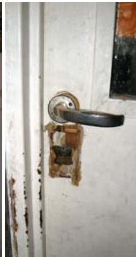
Herrajes que no funcionan, ocasionando que algunas ventanas permanezcan abiertas y faciliten el ingreso de palomas.
