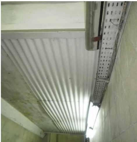
Foto 9: Escalera fija vestibulo anden sur: adecuar canalización a fin de evitar filtraciones sobre espacio operativo, se mantiene la filtración.
