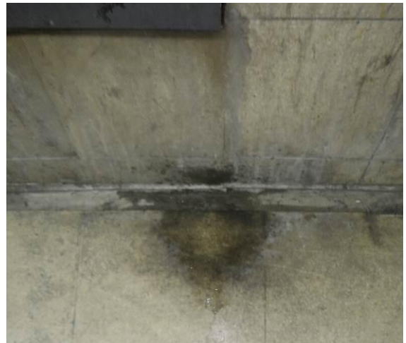
Foto 10: Andén sur: Filtración activa sobre espacio operativo en mitad lado oeste de andén, se mantiene la filtración.
