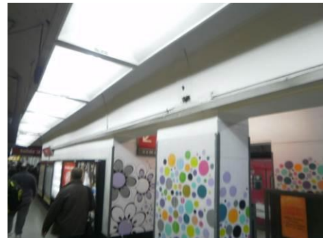
Foto 4: Escalera mecánica N° 22: filtración activa (cañería deteriorada).
