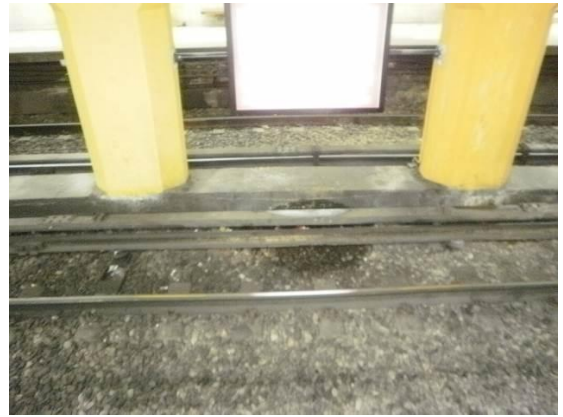
Foto 12: Bóveda: Filtración activa sobre tercer riel en punta este lado sur, se mantiene la filtración.
