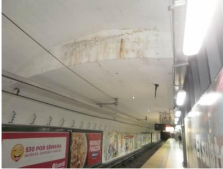
Foto 1: Andén norte: filtración activa sobre espacio operativo en mitad de andén, se constata la persistencia de la filtración.
