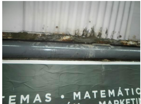
Foto 8: Andén sur: Filtración activa canalización por bandeja corroída, se mantiene la filtración.
