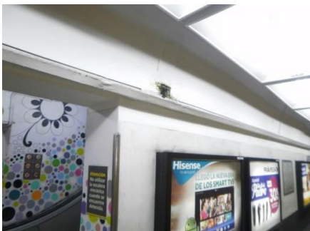
Foto 5: Escalera mecánica N° 22: filtración activa (cañería deteriorada).
