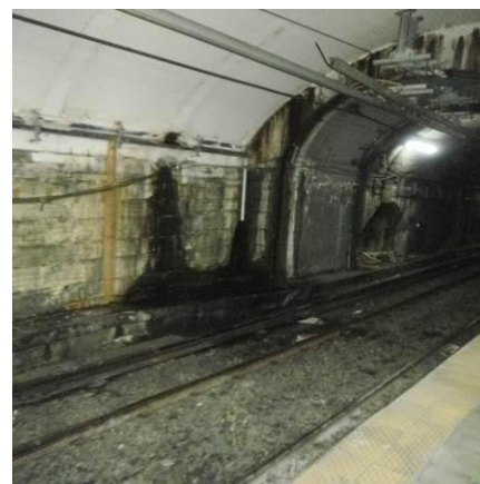
Foto 6: Bóveda: filtración activa en punta noreste.
