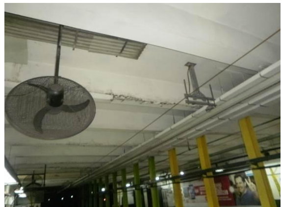
Foto 15: Andén Sur: filtración activa sobre espacio operativo en mitad de andén, se constata la persistencia de la filtración activa.
