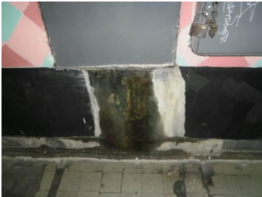
Foto 13: Andén Norte: Filtración activa proveniente de tablero antiguo, se mantiene filtración.
