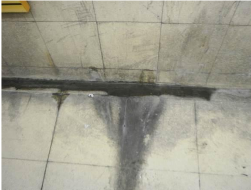
Foto 11: Andén sur: Filtración activa sobre espacio operativo en mitad lado oeste de andén, se mantiene la filtración.
