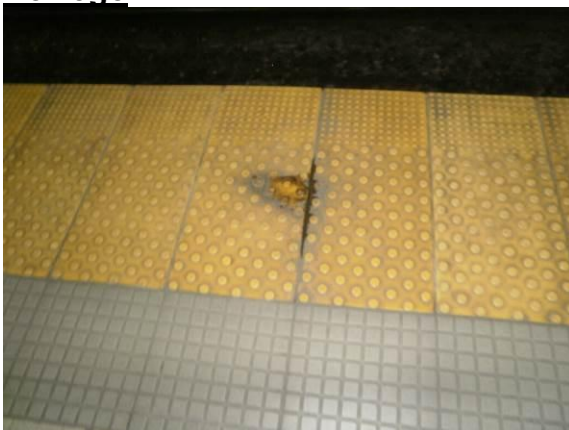
Foto 14: Andén Sur: filtración activa sobre espacio operativo en mitad de andén, se constata la persistencia de la filtración activa.
