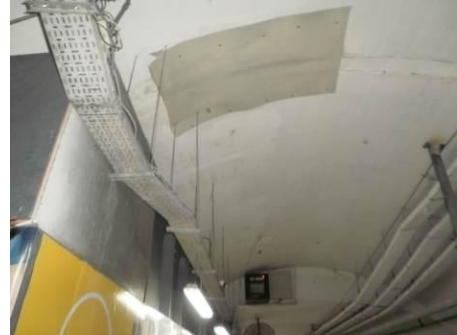
Foto 2: Andén sur: Adecuar canalizar en mitad de andén, se constata la persistencia de la falta.
