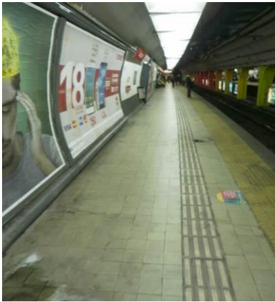
Foto 7: Andén sur: Filtración activa canalización por bandeja corroída, se mantiene la filtración.
