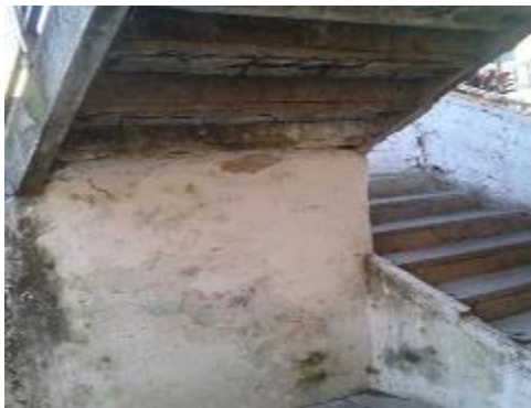
Escalera sin apuntalar con estructura colapsada mostrando sus hierros.
