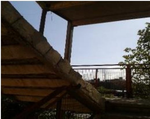
Riesgo de derrumbe.
