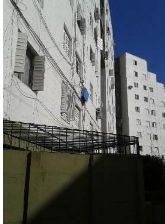
Cables en toda la fachada. Entran y salen sin ningún tipo de orden.
