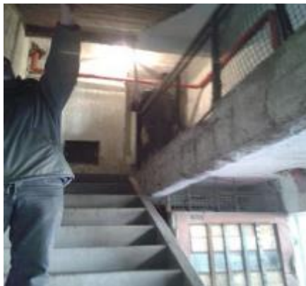
Escalera interna de edificio alto (Nº 26). Escalera sin baranda. Se aclara que el tramo siguiente tenía baranda pero sin sujeción correcta, con movimiento peligroso.
