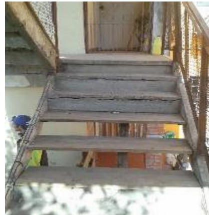
Al desprenderse los escalones de hormigón, se reemplazan con tablas de madera.
