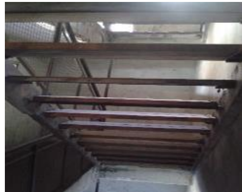
La misma escalera del Edificio Nº 26 con tramos realizados con peldaños en madera, realizado por la Administración del edificio.
