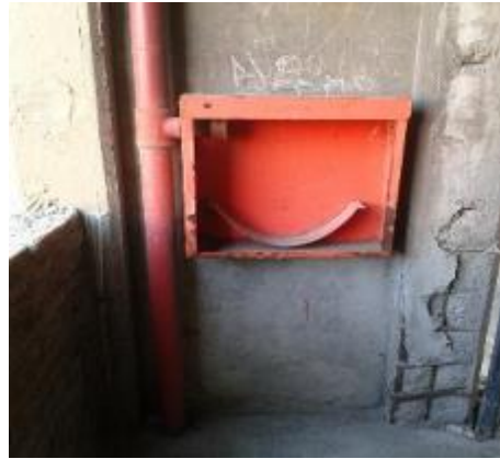
Faltan esclusas, bocas, lanzas y mangueras contra incendio.
