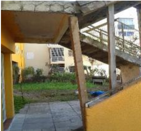
Escaleras conectoras de edificios bajos, algunas están apuntaladas y evidencian su estructura fisurada mostrando hierros oxidados.
