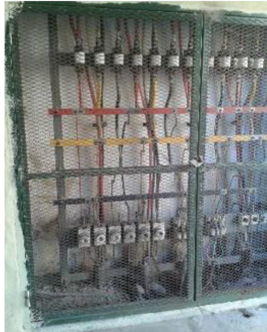
Edificio 26 A, nudo 9. Tablero principal eléctrico cuya puerta es una malla artística: las puertas deben ser ciegas con ventilación inferior y superior con advertencia de riesgo eléctrico.
