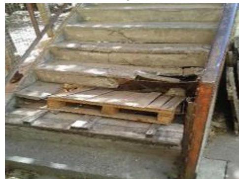
Riesgo de derrumbe.
