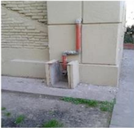
Conexión de bomberos, sin habilitar.
