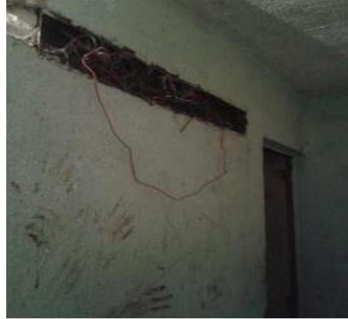
Cables de electricidad sueltos en pasillos.
