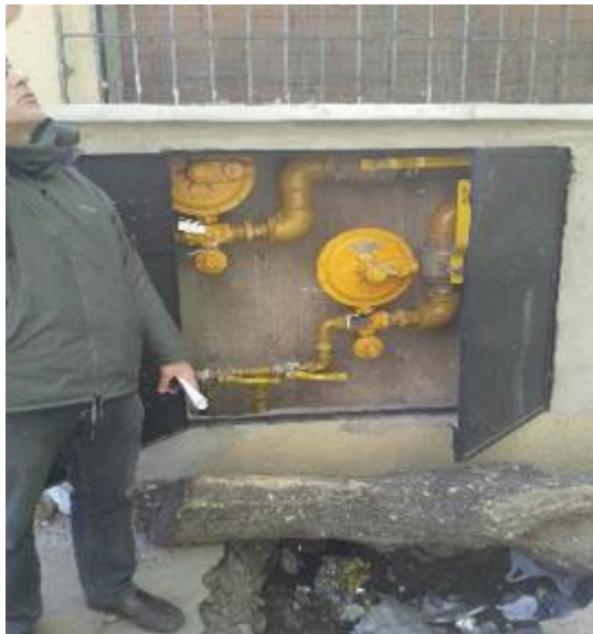
Edificio 23 y 26, nudo 11. Tapa de gas sin señalizar en el edificio. El gas no está habilitado aún por Metrogas.
