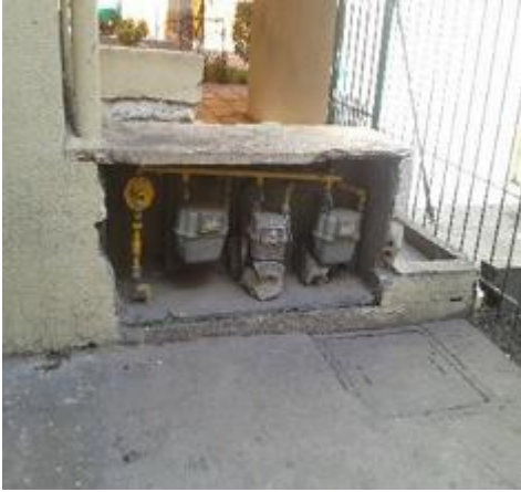
Medidores de gas con caño vencido, apuntalados con piedras, y sin cerramiento reglamentario.
