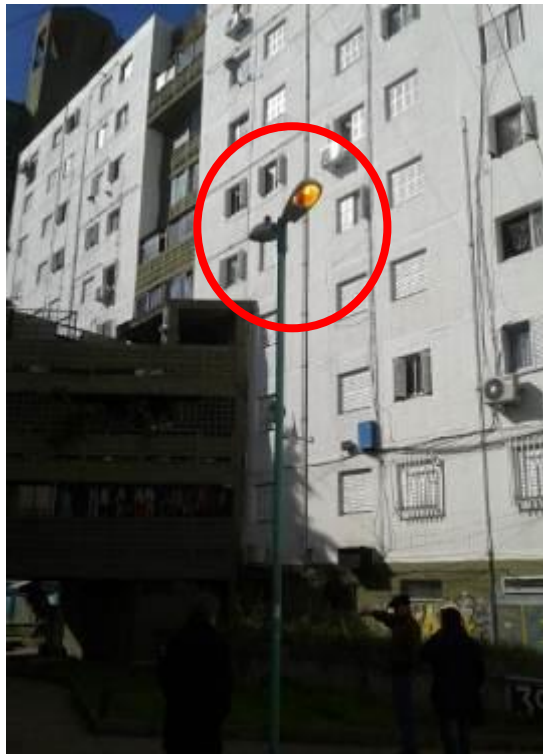
Otra luminaria encendida durante la recorrida de la mañana.
