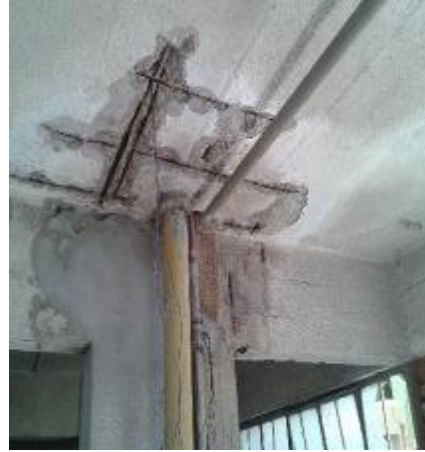
Estructura de hormigón a la vista en cielorraso PB por pérdida de agua.
