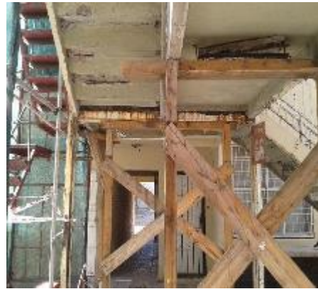
Apuntalamiento que lleva mucho tiempo.
