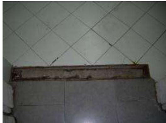
Observación 2: Hay un resalte en el solado del baño para discapacitados, en el umbral de la puerta, lo que dificulta el acceso con las sillas de ruedas.
