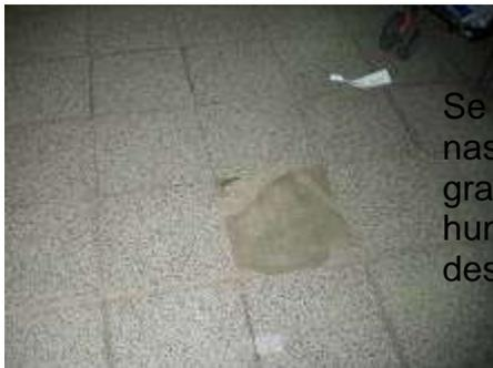
Se observa la falta de algunas baldosas en el piso granítico y problemas de humedad en algunas paredes por la falta de zócalos.
