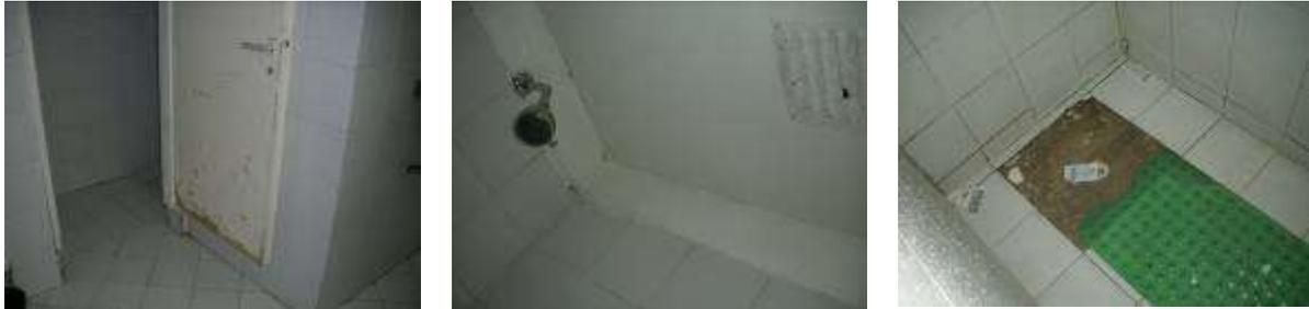
En una de las duchas faltan piezas cerámicas en el piso y la pintura general no está en buenas condiciones de mantenimiento.
