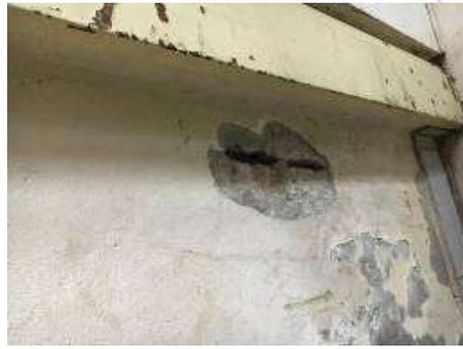
Se verificó falta de mantenimiento en varios sectores del Parador tales como falta de revoques y terminaciones en paredes, techos y pisos tanto de cemento alisado, como el caso de la escalera que conduce al comedor como los de baldosas cerámicas del dormitorio.
