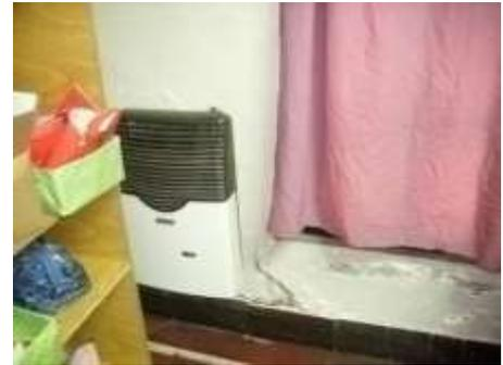
**Observación 1: problemas de humedad en paredes y pintura deteriorada**
