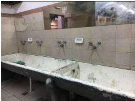
Se verificó la existencia de espejos rotos y cerámicas rotas, se consideran elementos de alto riesgo en este tipo de paradores.
