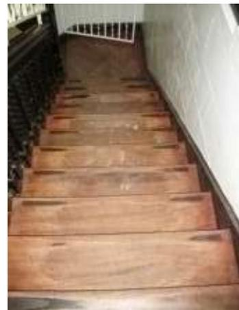
En el caso de las escaleras, hay tres. Una de madera, otra de mármol y la tercera de cemento rodillado. En las tres faltan las bandas antideslizantes reglamentarias. (Observ 10.3)
