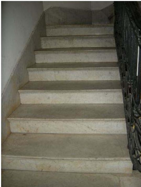
La escalera original del edificio que vincula la planta baja con la alta, no cumple con la normativa tanto en lo edilicio (1.10 m de ancho) como en su equipamiento. No tiene doble baranda, zócalo de contención, cinta antideslizante ni bandas de señalización.
