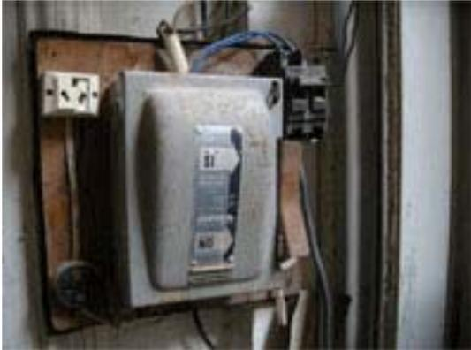
Hay tableros eléctricos con los circuitos sin identificar, sin disyuntor y sin jabalina. Hay cables sueltos en diferentes sectores del edificio.
