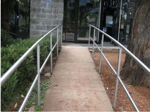
La rampa exterior de acceso al edificio no tiene zócalo de contención ni señalización de textura. Si bien posee doble baranda, la misma no cuenta con pasamanos anatómico, doble y continuo.
