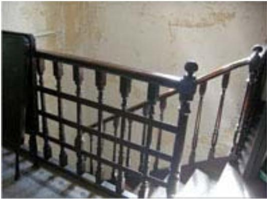
Las escaleras que vinculan la planta baja con el primer nivel son de material combustible (una de madera y la otra revestida en alfombra), no tienen doble baranda, cinta antideslizante, ni bandas de señalización.
