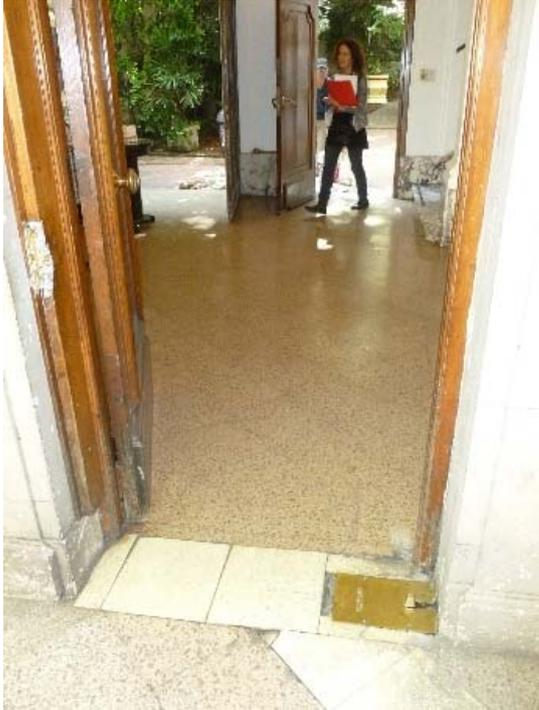
La única puerta, de acceso al edificio tiene un ancho reducido de 0,90 m y es de material combustible sin tratamiento ignífugo.
