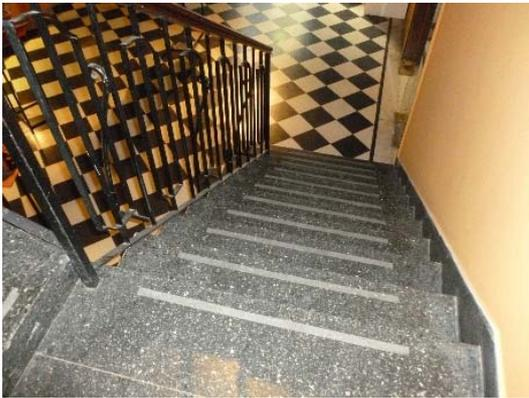
Ni la escalera exterior, ni la única escalera de acceso a la Sala de Exposición del primer piso del segundo cuerpo, cumplen con la normativa en lo que respecta a su equipamiento, ya que tienen baranda a un solo lado y no poseen zócalo de contención.
