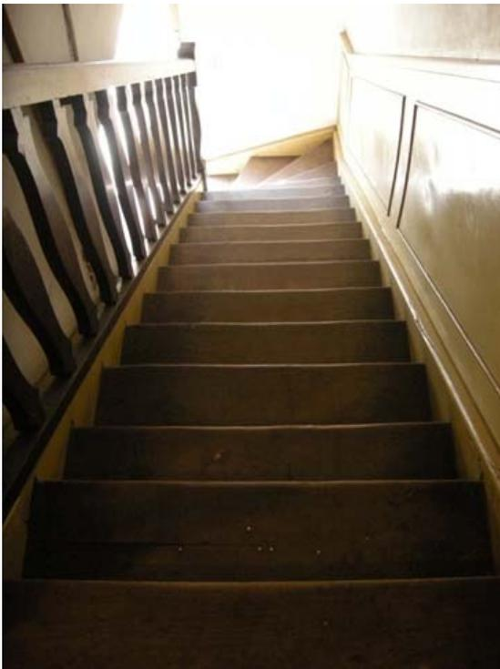
La escalera de acceso a la planta alta del Pabellón Central (usada solo por el personal del Museo) no cumple con la normativa. Tanto desde el punto de vista edilicio, por tratarse de una construcción del año 1942, (es de madera, tiene 0,94 m de ancho, escalones con variaciones en sus dimensiones y escalones compensados) como en su equipamiento y mantenimiento (una sola baranda desprendida y sin cinta antideslizante).
