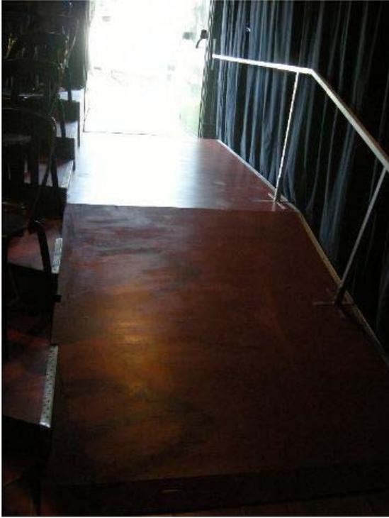
Las rampas interiores y exteriores del Auditorio no tienen zócalo, barandas, ni señalización de textura. Además, las del interior son de material con terminación lisa y combustible y sin rellanos.
