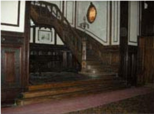
La escalera principal es la original del edificio y no cumple con la normativa tanto en su aspecto constructivo, ya que es de material combustible y tiene escalones compensados, como en su equipamiento ya que tiene baranda a un solo lado, no posee cinta antideslizante, ni señalización.
