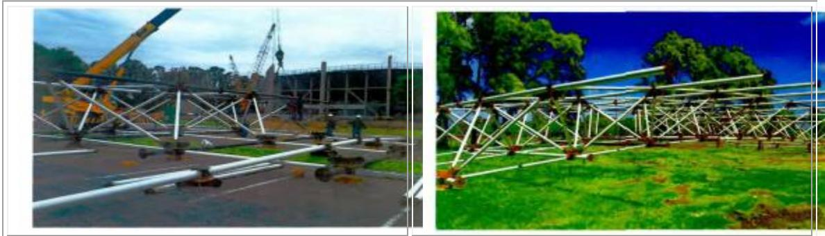
Armado en obra de la estéreoestructura E3
