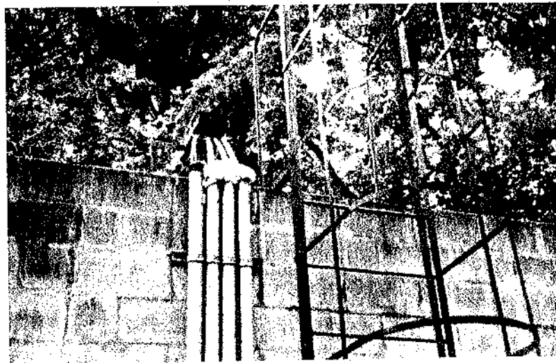
FOTO N ° 9 Vista de la instalación eléctrica efectuada Para los equipos de aire condicionado
