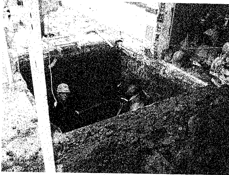
FOTO 15 Excavación de bases
