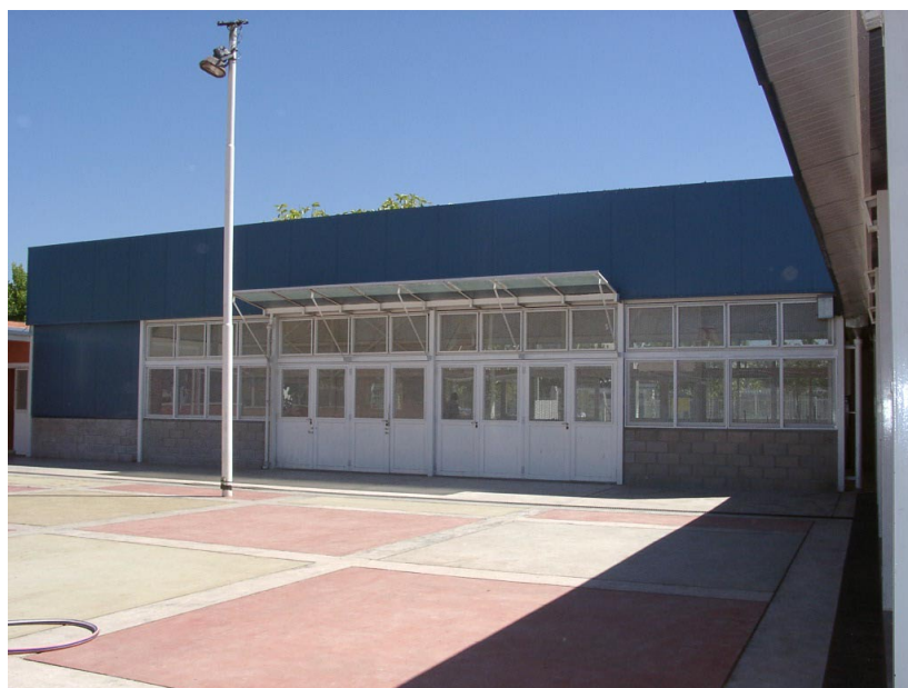
Foto N° 9: Vista desde el patio abierto de la escuela N°21 D.E 19 construida por administración.
