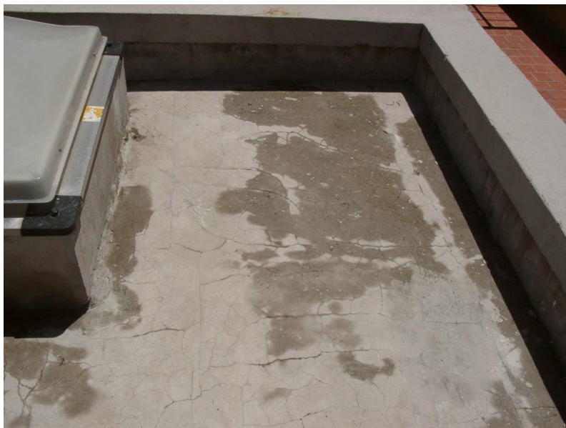
Foto N° 7: Vista de la azotea sobre vivienda del portero – Pampita
