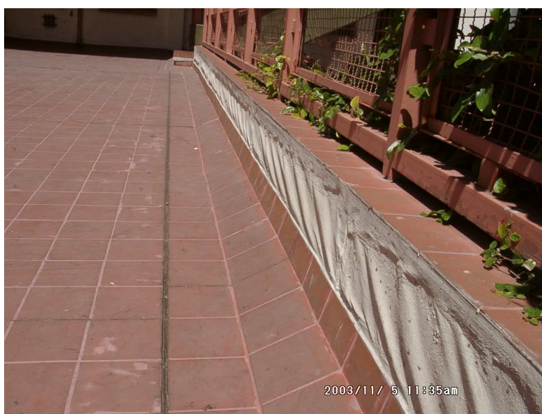
Foto N° 6: Vista de la ejecución de aislaciones en azotea en la Escuela Juan Larrea
