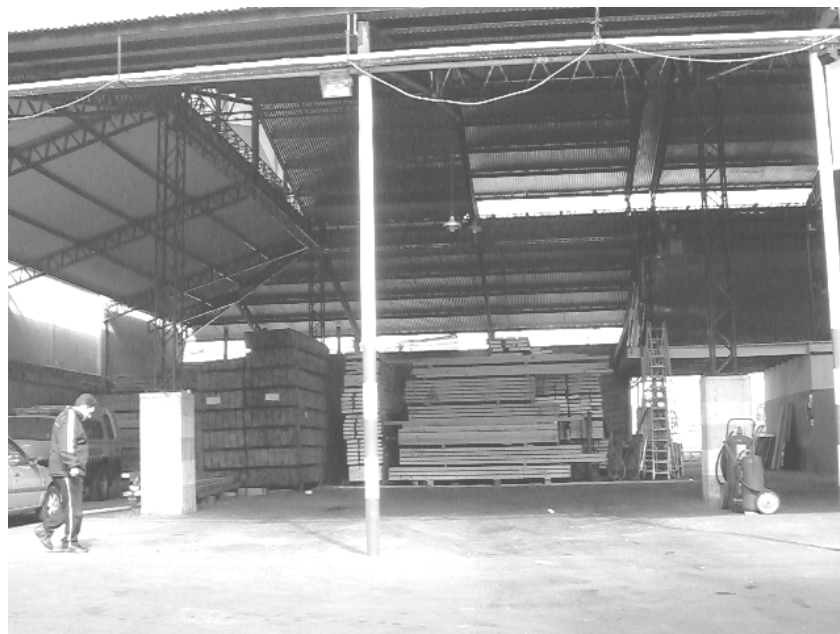
Foto N° 2 – Vista de una parte del interior del galpón-depósito desde la playa de maniobras del acceso. Al fondo se observan maderas apiladas y a la derecha los equipos de matafuegos y detrás un pasaje que comunica con el callejón de la foto N° 16.
