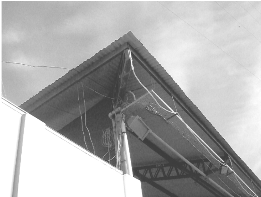
Foto N° 5 – Vista de la estructura de reticulado de hierro ángulo y la cubierta de chapas del galpón, la iluminación en base a lámparas halógenas cuelgan por medio de los conductores desde la estructura.
