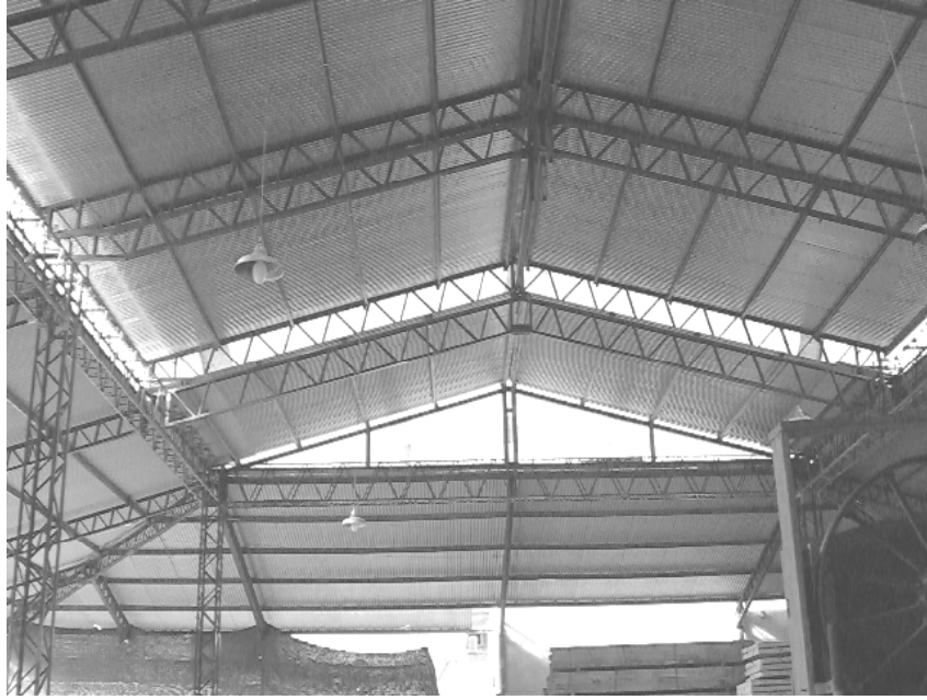
Foto N° 5 – Vista de la estructura de reticulado de hierro ángulo y la cubierta de chapas del galpón, la iluminación en base a lámparas halógenas cuelgan por medio de los conductores desde la estructura.
