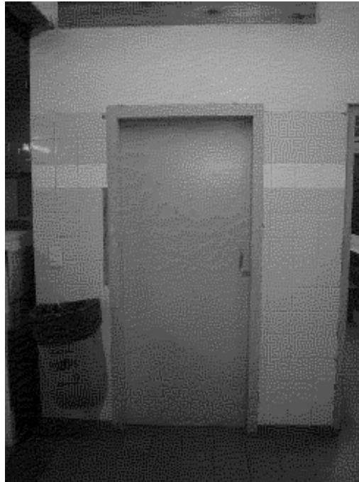
Foto N° 23 – Acceso al depósito y archivo.
