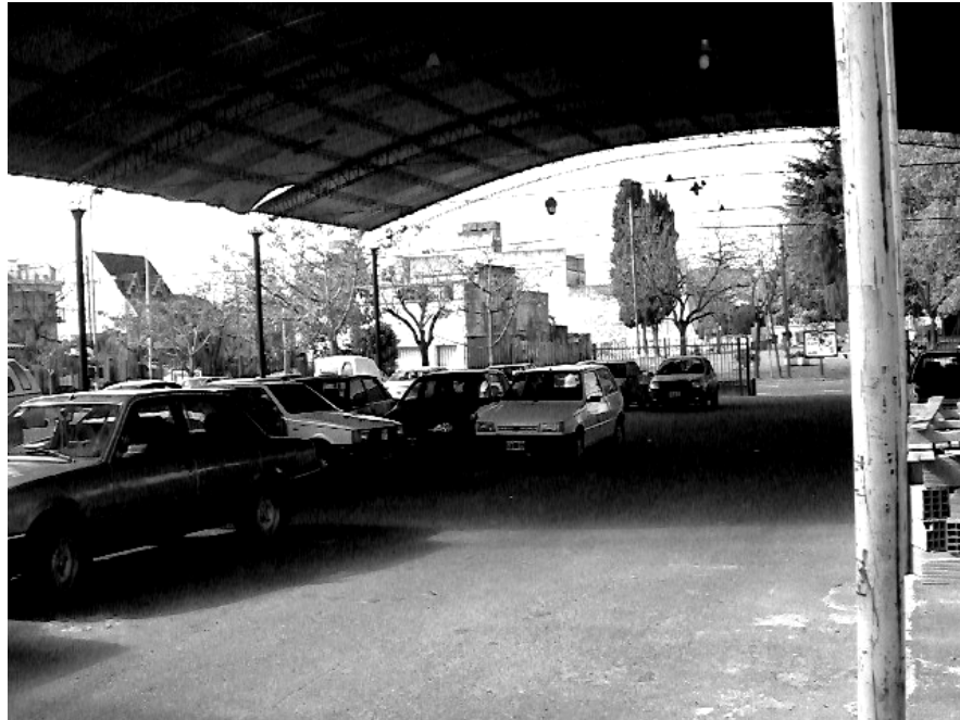
Foto 17 –Estacionamiento de automóviles del personal del organismo cubierto con un tinglado de reticulado parabólico con techo de chapas ubicado sobre la calle Monroe. Esta playa se conecta con el resto del organismo por el corredor de la foto N° 16 y se comunica también con el terreno de la esquina (a la izquierda de la foto).
