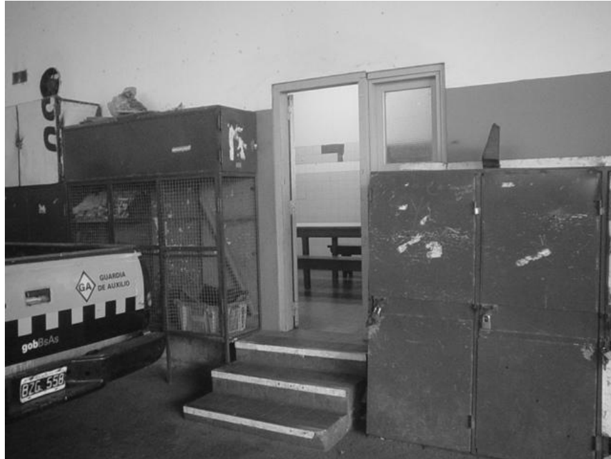
Foto N° 19 – En la presente imagen se puede observar el acceso al sector de archivo y vestuario, ubicado a la derecha del galpón-taller.
