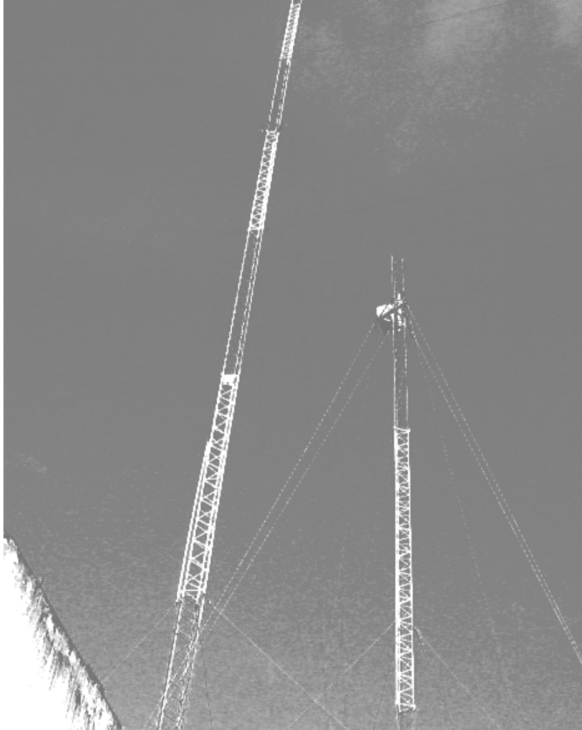
Foto N° 11 – Antenas de comunicaciones sujetadas con tensores empotrados en la pared medianera y en el galpón-taller.
