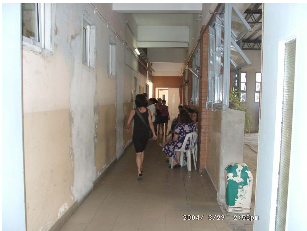
Sector de espera/Pasillo Oficina 16
