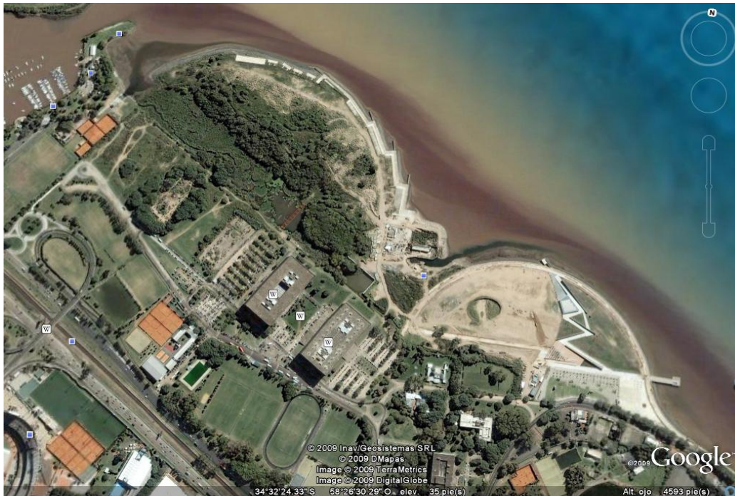
Foto: Vista panorámica de la obra obtenida de Google Earth
