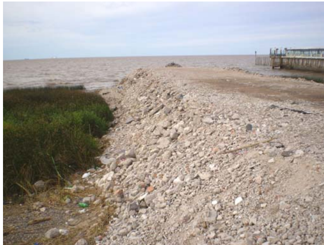
Foto: Terraplén de Avance
