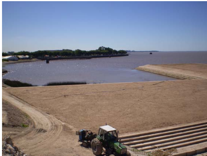
Foto: Preparación del espigón
