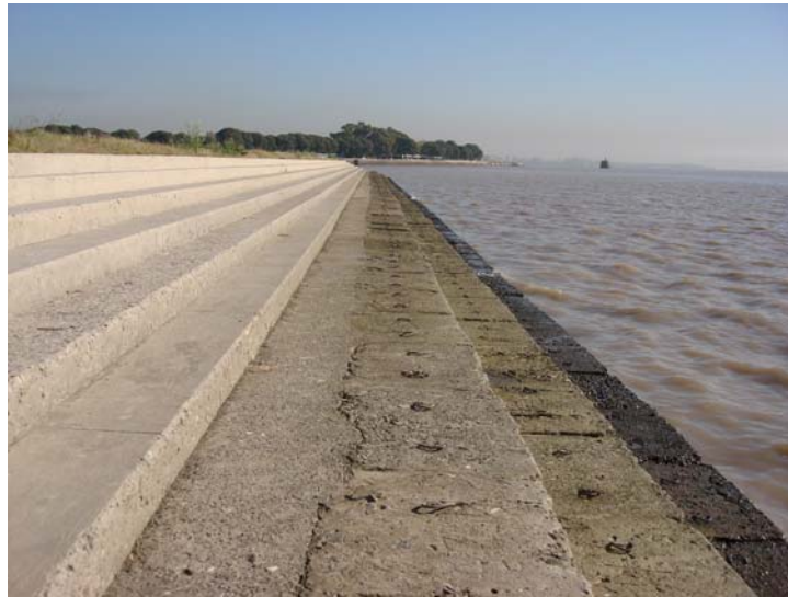
Foto: Borde de frente al río con doble fila de bloques de hormigón pobre lo cual genera mayor protección
