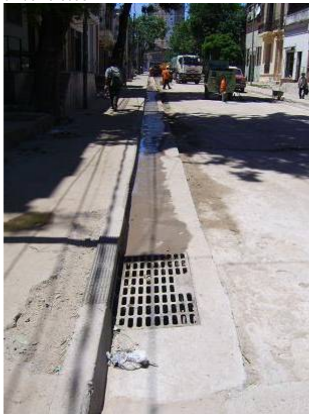
Foto 42. Necochea entre B. Pérez Galdós y Blanes. Obra del conducto terminada. Etapa de pavimentación y refacción de veredas.
