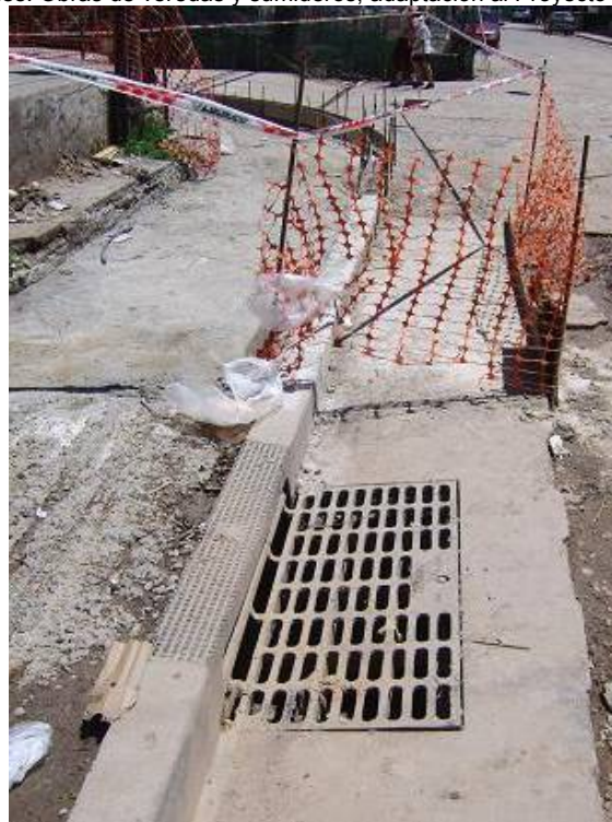
Foto 38. Calle Necochea y Blanes. Obras de veredas y sumideros; adaptación al Proyecto Necochea I.
