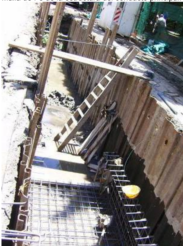
Foto 30. Calle Necochea entre vías del Ferrosur Roca SA y calle Gualaguay. Construcción del conducto principal. Se puede apreciar el tablestacado y el encofrado del conducto principal.
