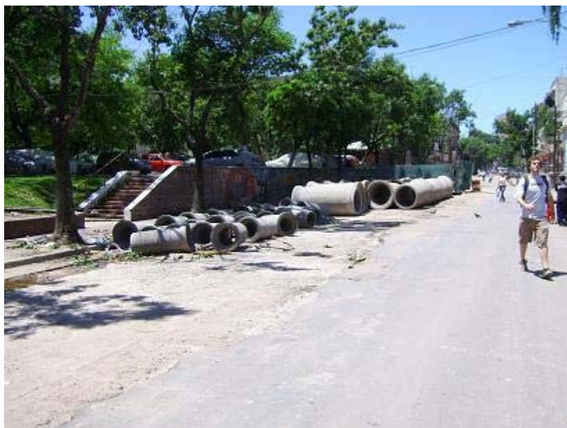
Foto 36. Calle Necochea entre las calles Arzobispo Espinosa y Guaquay. Se observa los conductos a ser utilizados en el tramo secundario de las calles 20 de Septiembre y Almirante Brown.
