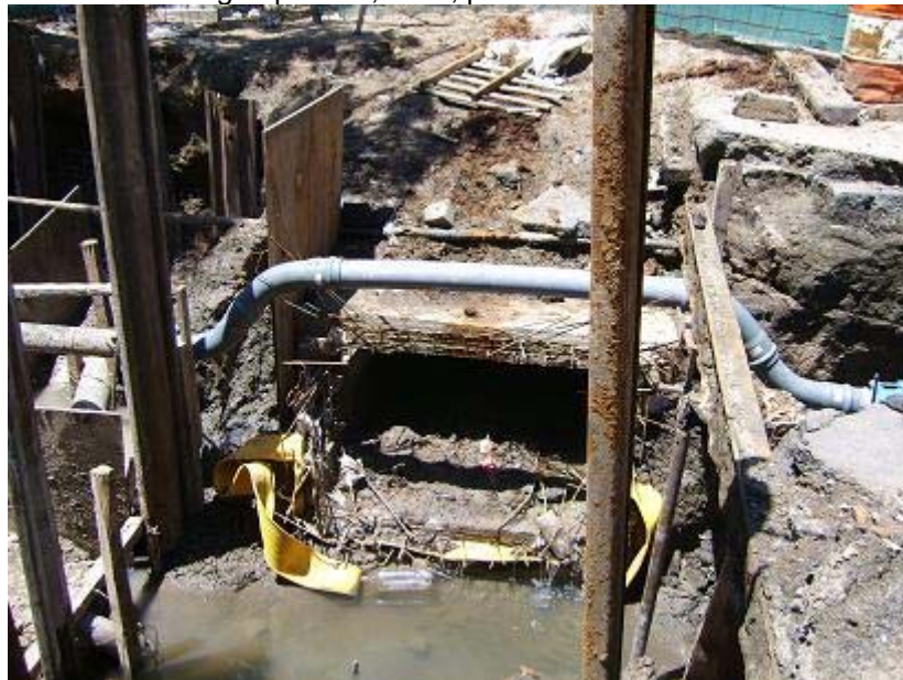
Foto 34 y 35. Calle Necochea y Cruce de vías del Ferrosur Roca SA. Puede observarse la construcción del conducto de agua potable, en \Omega , para salvar la interferencia.
