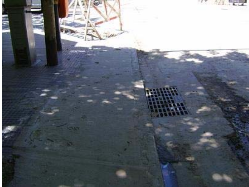
Foto 43. Calle Necochea y Gualleaguay. Adaptación de la obra al Proyecto Necochea I. Ampliación de veredas y reubicación de sumideros.
