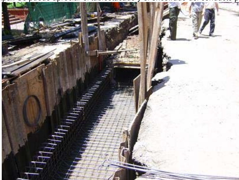
Foto 30. Calle Necochea entre vías del Ferrosur Roca SA y calle Gualaguay. Construcción del conducto principal. Se puede apreciar el tablestacado y el encofrado del conducto principal.
