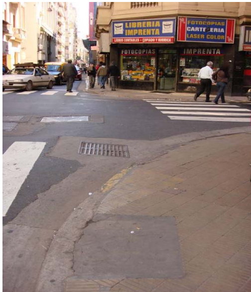
Foto N° 3 (51) – Se solicitó construcción de rampa - Reclamo en trámite pendiente
