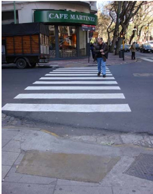
Foto N° 13 (2) – Rampa antirreglamentaria y con cuneta sobre elevada y deteriorada que dificulta su uso - Reclamo en trámite pendiente
