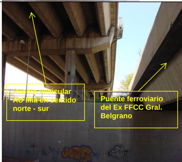
Foto N° 9: Vista hacia el Sur de la Ciudad / Puente Ferroviario del Ex FFCC Gral. Belgrano visto desde el interior del cruce Bajo Nivel.
