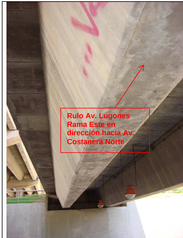
Foto N° 8: Vista del Rulo Rama Este en dirección al Río de la Plata hacia la Av. Costanera Norte. Foto tomada desde el interior del Cruce Bajo Nivel.
