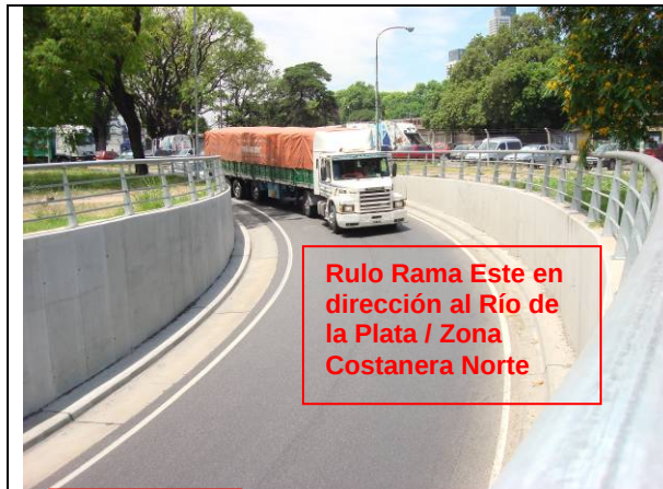
Foto N° 3: Vista hacia el Sur / Entrada al Rulo Este en dirección al Río de la Plata / Zona Costanera Norte.
