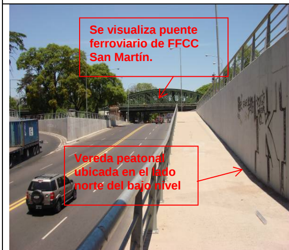
Foto N° 7: Vista hacia el Oeste / hacia el interior de la CABA.
