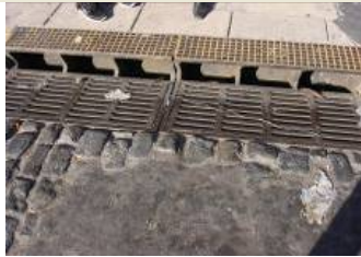
Foto N° 1.47 Sumidero Av. Libertador Poste 50134G
