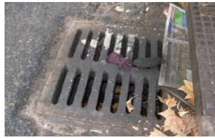
Foto N° 3.4 Yermal 2798 (Reja con grasa)
