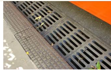
Foto N° 1.9 Sumidero Av. F. Lacroze 1906
