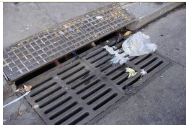
Foto N° 1.18 Sumidero Av. Cabildo 491
