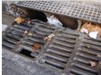
Foto N° 1.48 Sumidero Av. Cabildo 505
