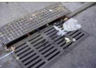
Foto N° 1.50 Sumidero Av. Cabildo 491
