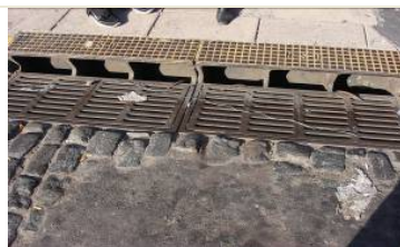
Foto N° 1.11 Sumidero Av. Libertador Poste 50134G
