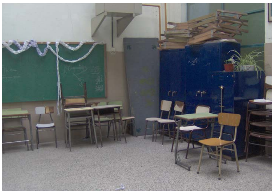
Foto N°6: ESC. N° 10 DE 6 “ Ricardo Rojas” sita en la calle Av. Jujuy 150 Patio descubierto de pequeñas dimensiones obstaculizado con mobiliario.
