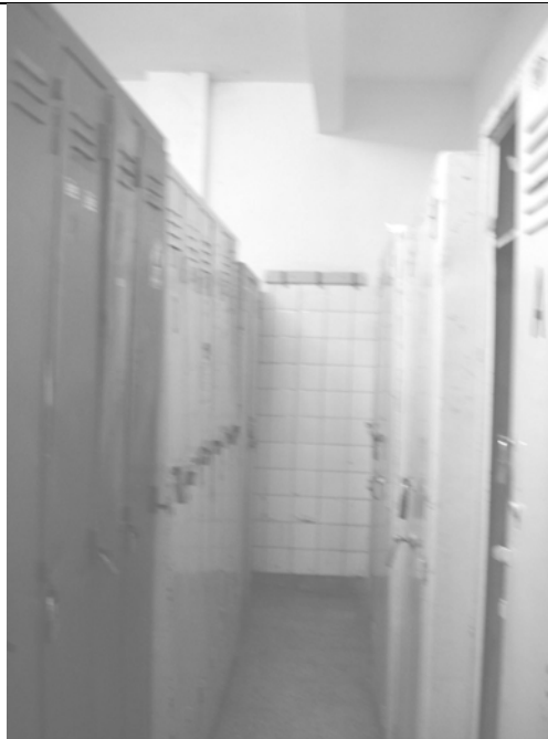
Foto N° 15 – Vista del interior del vestuario del personal donde observamos que los armarios están colocados con un pasillo muy estrecho, de 60 cm de ancho entre los mismos.
