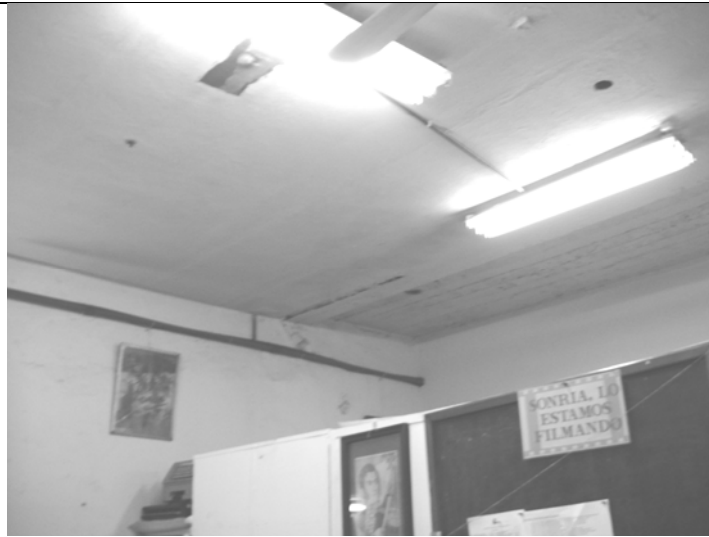
Foto N° 30 – En la presente vista se puede observar en el cielorraso varios centros de electricidad con cables expuestos y sobre la pared del fondo junto al cielorraso manchas de humedad de una filtración de agua .
