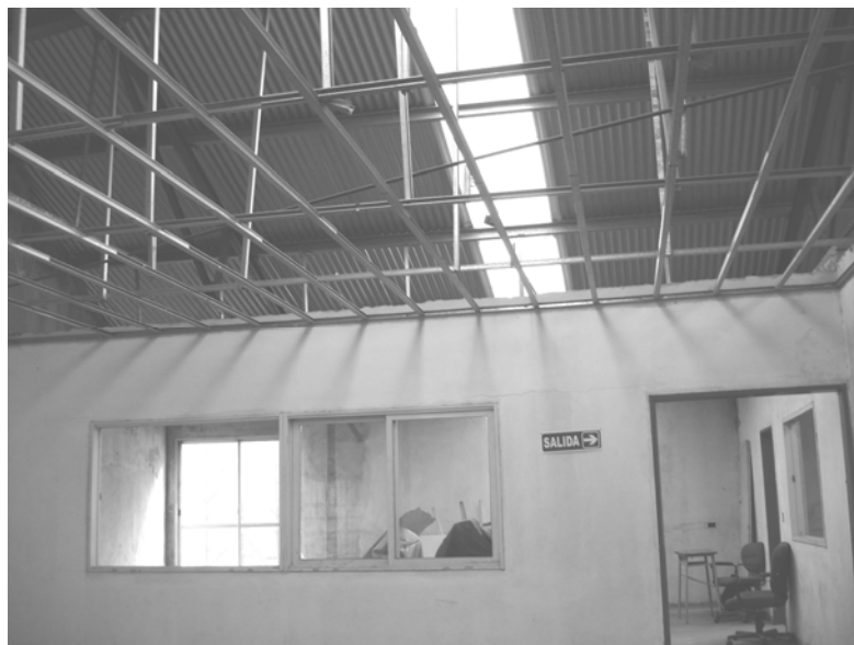
Foto N° 39 – En la presente vista se puede observar en la planta alta en el techo la estructura soporte de un cielorraso de “Durlok” sin colocar y mas arriba el techo de
