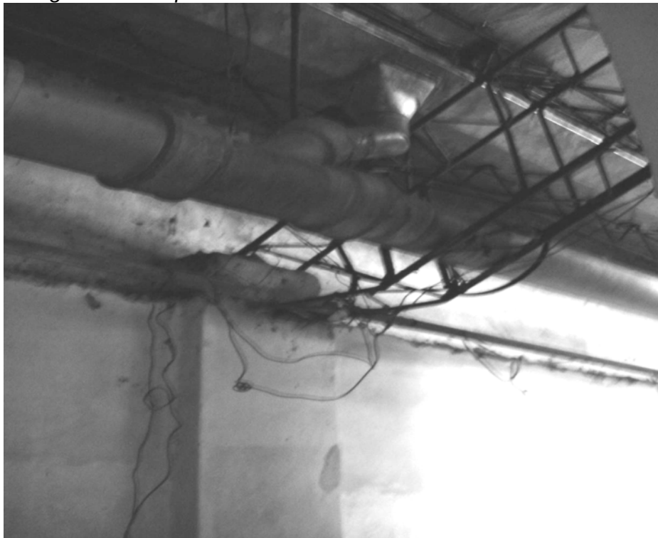
Foto N° 51 – En la presente foto se puede ver en la planta alta todo un sector en construcción, sin ventanas y sin terminaciones pero con cables de electricidad expuestos colgando de la pared.
