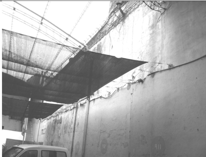
Foto N° 6 – Vista de el acceso de vehículos cubierto con una malla de media sombra, en la pared derecha que es medianera, podemos observar deterioros en el revoque, humedad, falta de pintura y cables de electricidad expuestos y encintados , al fondo una de las escaleras de acceso a la planta alta.
