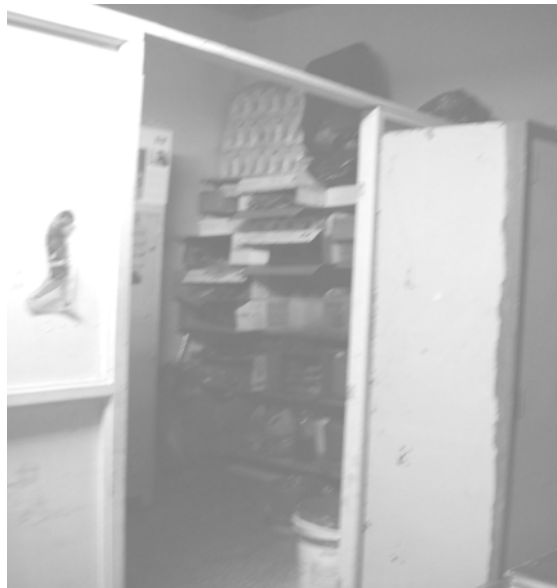
Foto N° 28 – Dentro del local depósito y taller de armas podemos observar un espacio cerrado con paneles de bastidor de madera y placas de hardboard para guardar elementos del taller en estantes.
