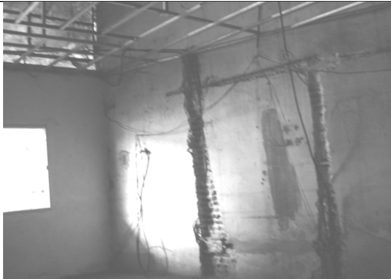
Foto N° 51 – En la presente foto se puede ver en la planta alta todo un sector en construcción, sin ventanas y sin terminaciones pero con cables de electricidad expuestos colgando de la pared.
