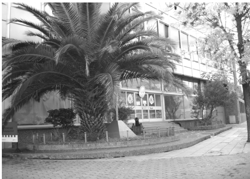
Foto N° 2 – Imagen del frente del edificio del Organismo "Defensa Civil", en la misma se puede observar una rampa para discapacitados que accede al primer escalón, luego la escalera continúa y no se observa en este tramo la continuación de la rampa.
