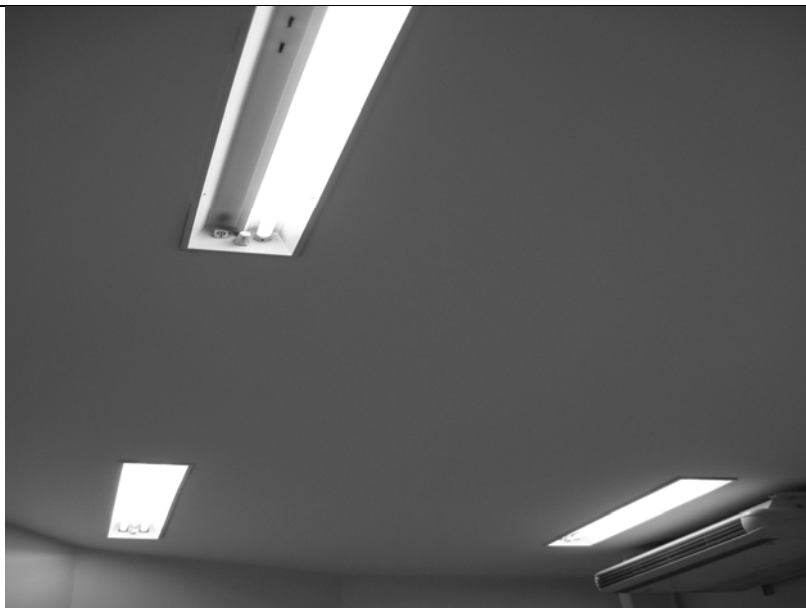
Foto N° 15 – En la presente vista se puede apreciar este cielorraso con artefactos de iluminación con tubos fluorescente (falta un tubo) sin algún elemento que impida la caída de los mismos.
