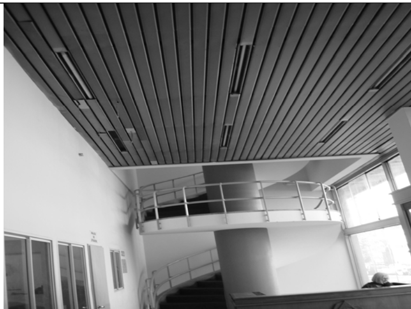
Foto N° 5 – Imagen del hall de acceso donde se puede observar la escalera helicoidal de acceso a los niveles superiores.
