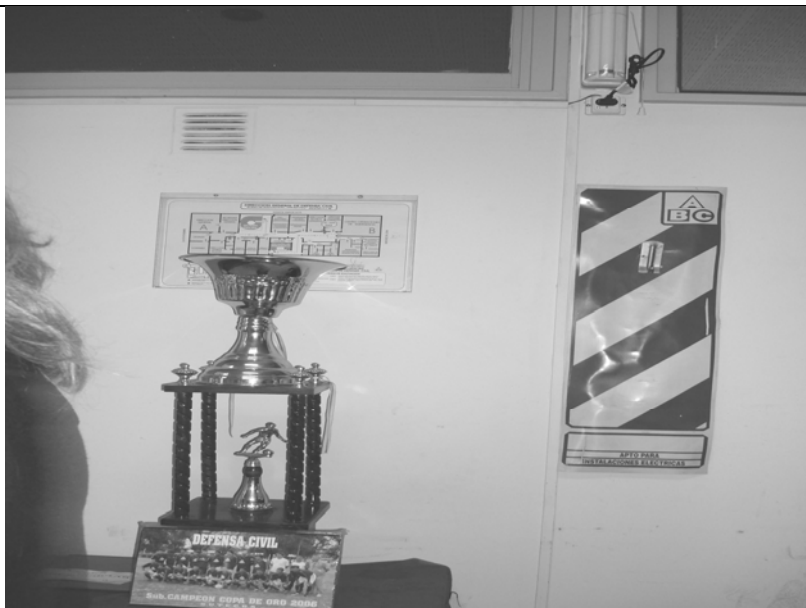
Foto N° 33 – En la presente vista se puede observar en el primer piso sobre una pared un plano para evacuación, arriba un tubo de iluminación de emergencia y a la derecha una chapa reglamentaria soporte de un matafuego pero el mismo no se encuentra en este lugar.
