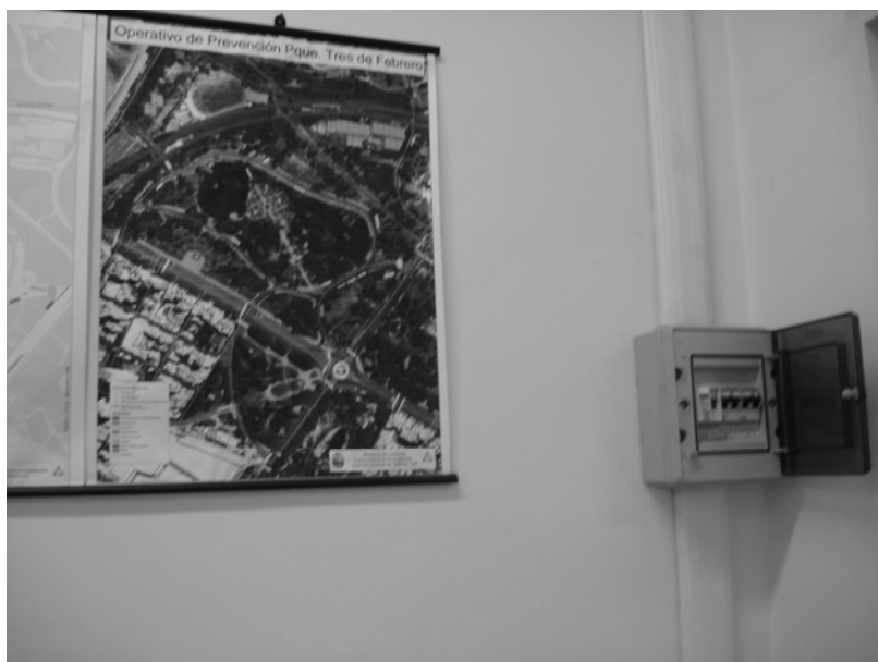
Foto N° 16 – En la presente vista se puede apreciar en una oficina de planta baja un tablero seccional exterior con llaves térmicas y un disyuntor diferencial.
