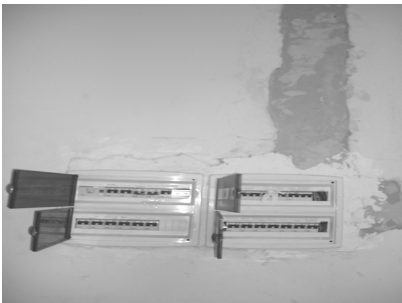
Foto N° 34 – En la presente vista se pueden observar cuatro tableros seccionales recién instalados con llaves de corte de electricidad térmicas y dos llaves de corte diferenciales.
