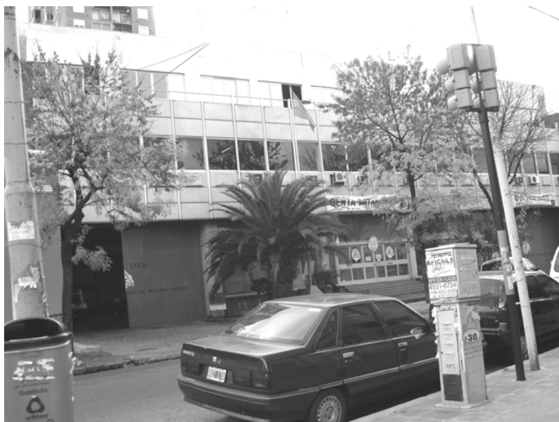
Foto N° 1 – Imagen del frente del edificio del Organismo "Defensa Civil".
