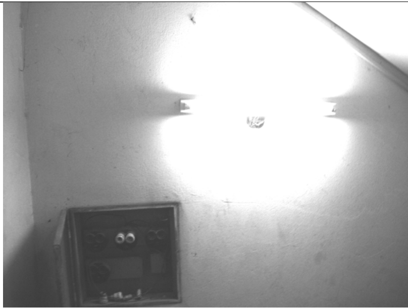
Foto N° 17 – En la presente vista se puede apreciar bajando al sótano un tubo de iluminación fluorescente con los cables de la conexión eléctrica expuestos y encintados y a la izquierda un tablero de electricidad seccional con los fusibles a cartucho en un circuito y el resto sin fusibles y con los portacartuchos expuestos .
