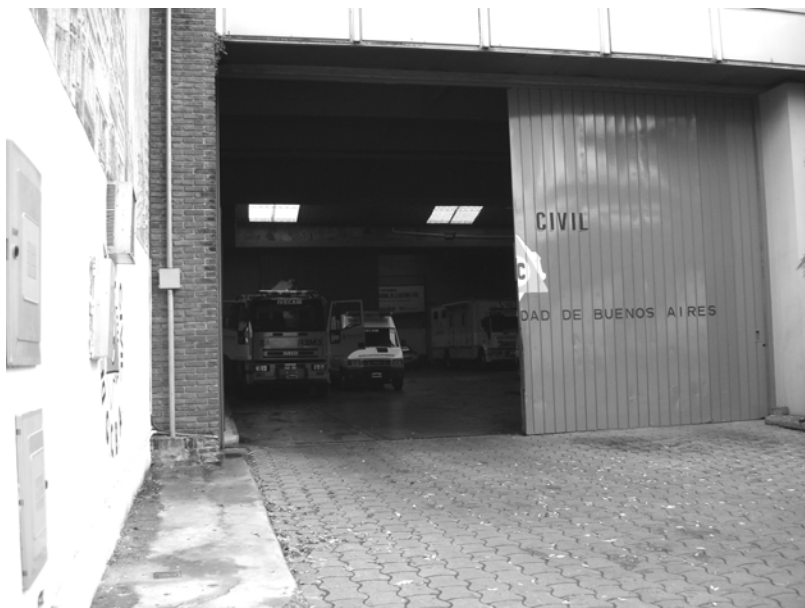
Foto N° 3 – Imagen del frente del edificio del Organismo “Defensa Civil”, en la misma se puede ver el acceso de vehículos en el mismo no se observa la señal luminosa y sonora a la salida de de los mismos . La fachada de este edificio se encuentra detrás de la línea de frente lo que permite que los vehículos tengan un espacio intermedio antes de salir a la calle.
