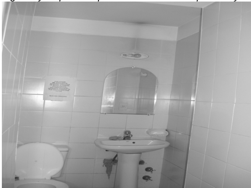
Foto N° 13 – En la presente vista se puede apreciar en el cielorraso un centro de electricidad al le que falta el artefacto de tubos fluorescentes y en su lugar hay un portalámpara con los cables expuestos y encintados.
