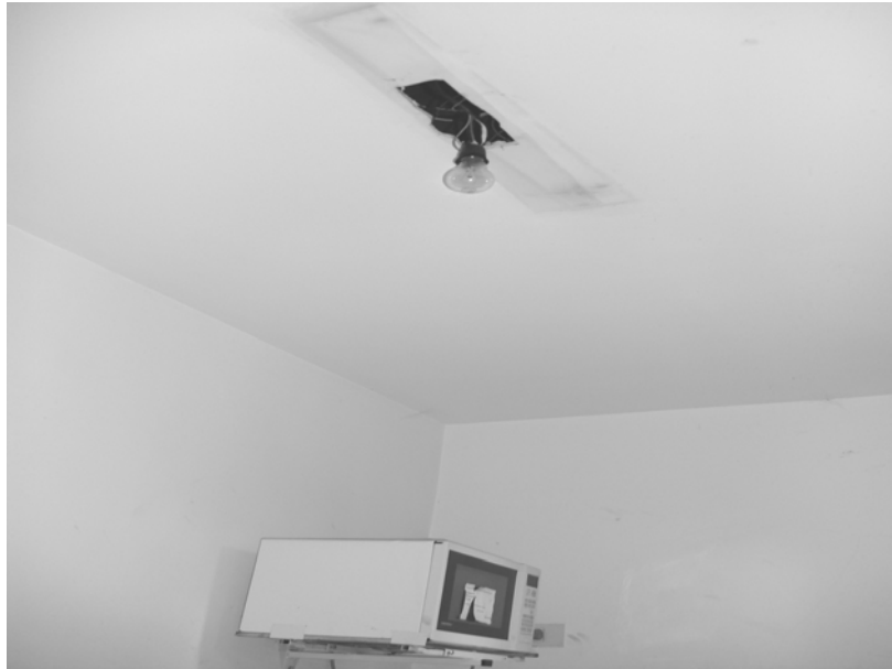
Foto N° 13 – En la presente vista se puede apreciar en el cielorraso un centro de electricidad al le que falta el artefacto de tubos fluorescentes y en su lugar hay un portalámpara con los cables expuestos y encintados.
