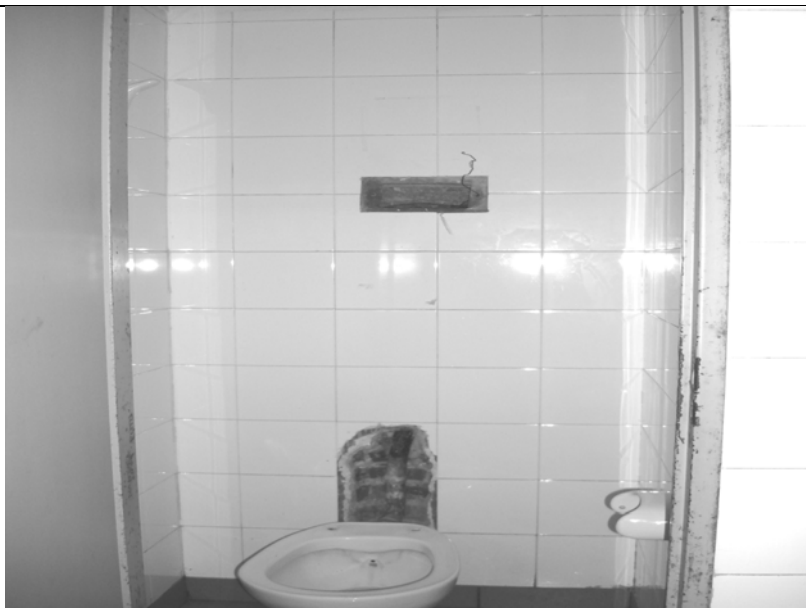
Foto N° 9 – En la presente vista se puede apreciar en el interior del baño de varones en planta baja un inodoro sin tapa y detrás la pared presenta una abertura donde queda a la vista el caño de descarga, también falta el botón y la tapa del tanque de descarga.
