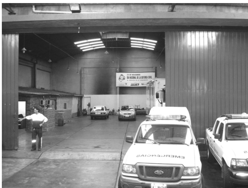
Foto N° 8 – En la presente vista se puede apreciar los estacionamientos de vehículos ubicados en la parte posterior del edificio con solado de cemento alisado y cubiertos por tinglados con estructuras de cabriadas de hierro y chapas acanaladas transparentes y galvanizadas, estas últimas tienen un revestimiento inferior de lana de vidrio como aislante térmico.
