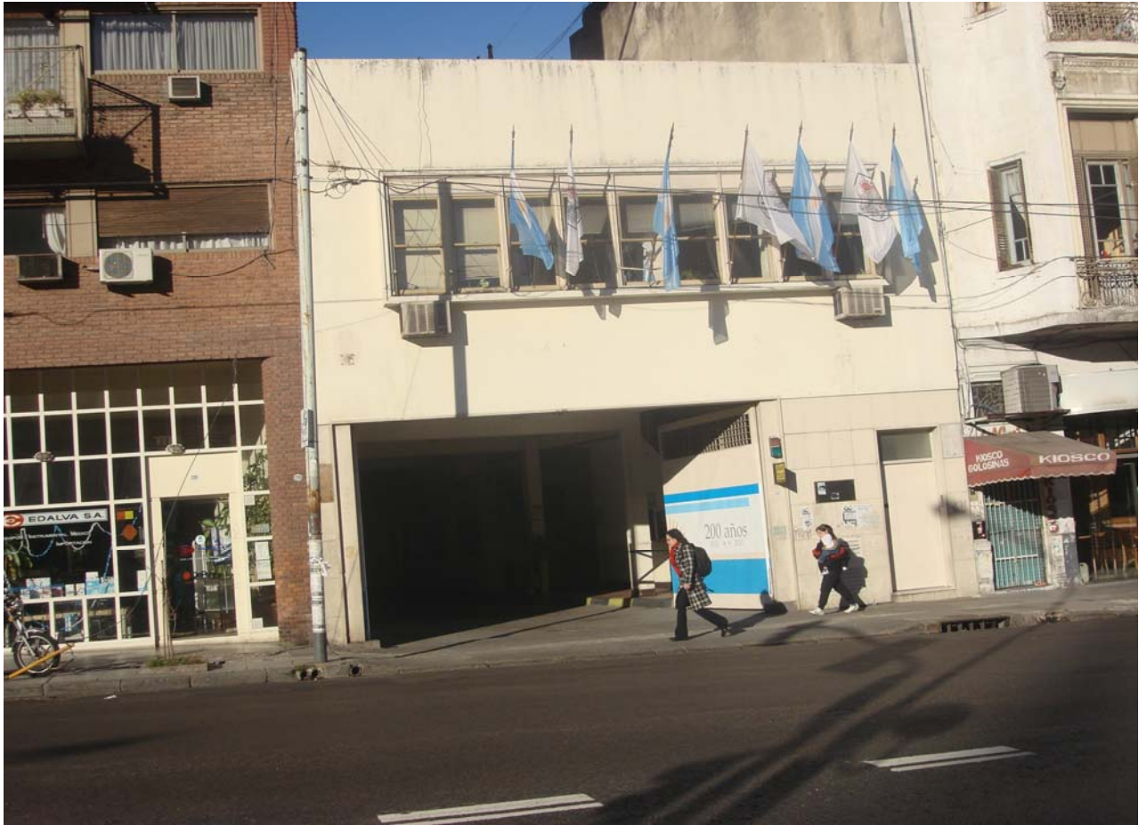
Foto N° 9 – El frente del edificio de este organismo no presenta “salida de emergencia”.
