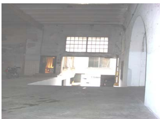
Salida del estacionamiento a calle Ecuador. Se encuentra en obra pero es utilizado por el personal. La rampa de bajada a la calle carece de baranda en el costado izquierdo.
