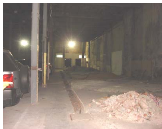
Salida del estacionamiento a calle Ecuador. Se encuentra en obra pero es utilizado por el personal. La rampa de bajada a la calle carece de baranda en el costado izquierdo.
