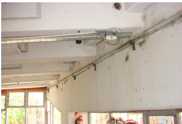
FOTO 8- CABLES EXPUESTOS
