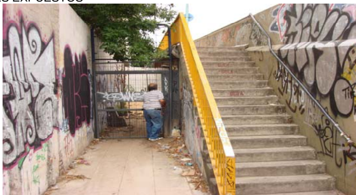
FOTO N° 9 DEPÓSITO DE MATERIALES NO CUENTA CON PERSONAL DE SEGURIDAD (PUENTE DE BUSTO)
