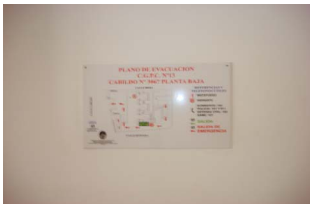
FOTO N° 18 FALTA DE SEÑALES DE SALIDA DE EMERGENCIA EN TODO EL EDIFICIO PLANOS SIN FIRMA DE PERSONAL RESPONSABLE DE DICHO PLANO FALTA DE EQUIPOS DE EMERGENCIA EN LOS DIFERENTES PISOS NO HAY RESPONSABLE NI CAPACITACIÓN PARA DICHA EVACUACIÓN.
