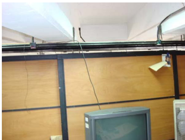
FOTO N° 6 ALTURA DE TECHOS EN DECLIVE
