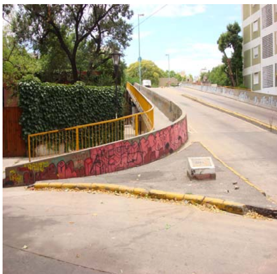
FOTO N° 16 LUGAR DE INGRESO AL CGPC N° 13 (PUENTE DE BUSTO)
