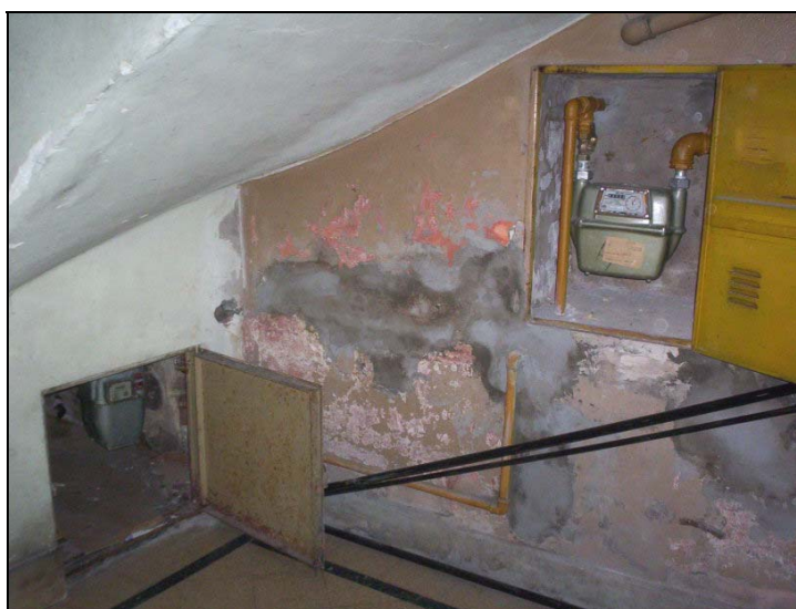
Vista de la instalación de los medidores sobre nichos existentes.
