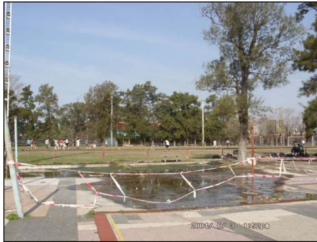
Vista del sector de la cancha de pelota al cesto donde, según se nos informan, la empresa contratista produjo la rotura de un caño.
