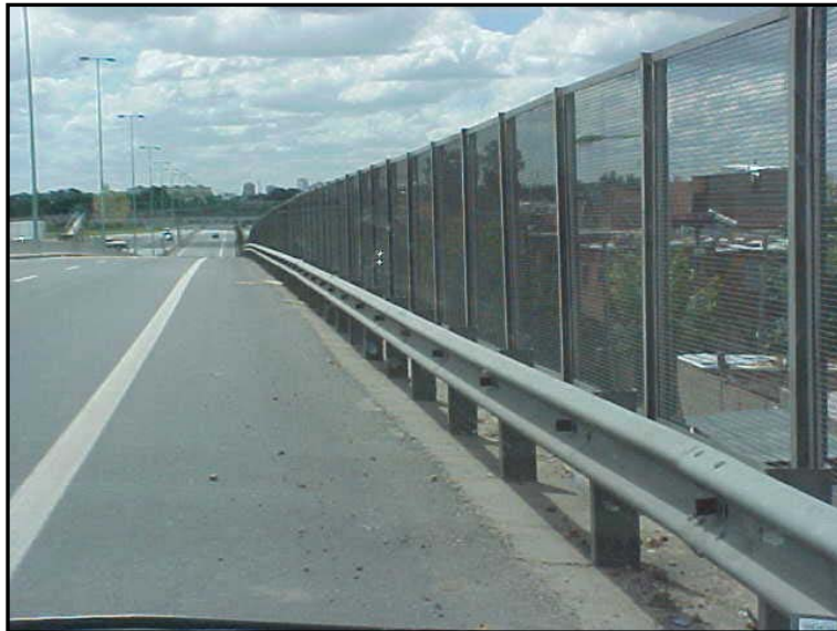
18/11/04. Banda A. Posición: entre intersecciones de Av. Roca y Av. Castaños. Viviendas en la Zona No Edificable. Rejas de protección.
