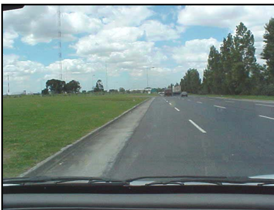
18/11/04. Banda B: aspecto en cercanías del empalme con la Av. 27 de Febrero
