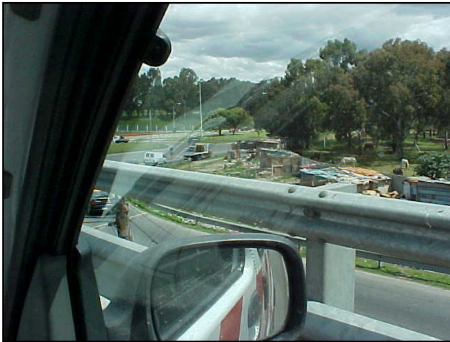
18/11/04. Banda B: aspecto de la salida de Av. Roca desde el viaducto elevado. Intrusión en la Franja No Edificable de casillas precarias. Av. Roca
