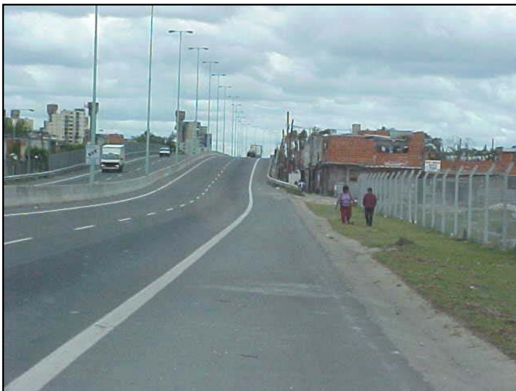
18/11/04. Banda B: Intrusión de viviendas de material en la Franja No Edificable. Rampa de elevación.
