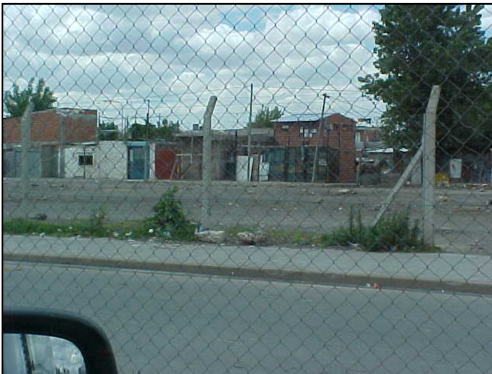
18/11/04. Banda A: aspecto de la Zona No Edificable a la altura de la intersección con la Av. Castaños.
