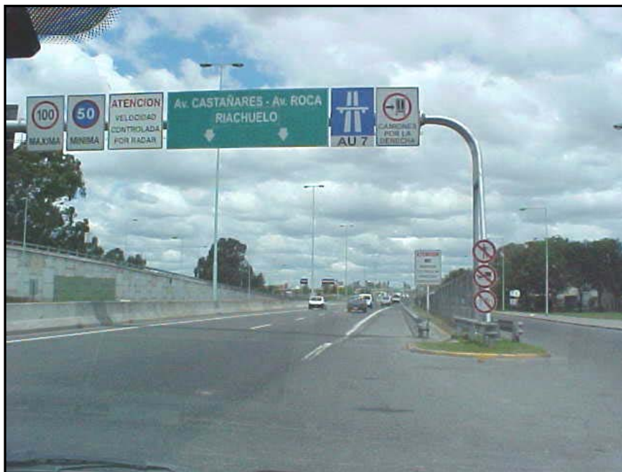
18/11/04. Inicio de la Banda B: Intersección Avenidas Dellepiane y Lacarra, a nivel
