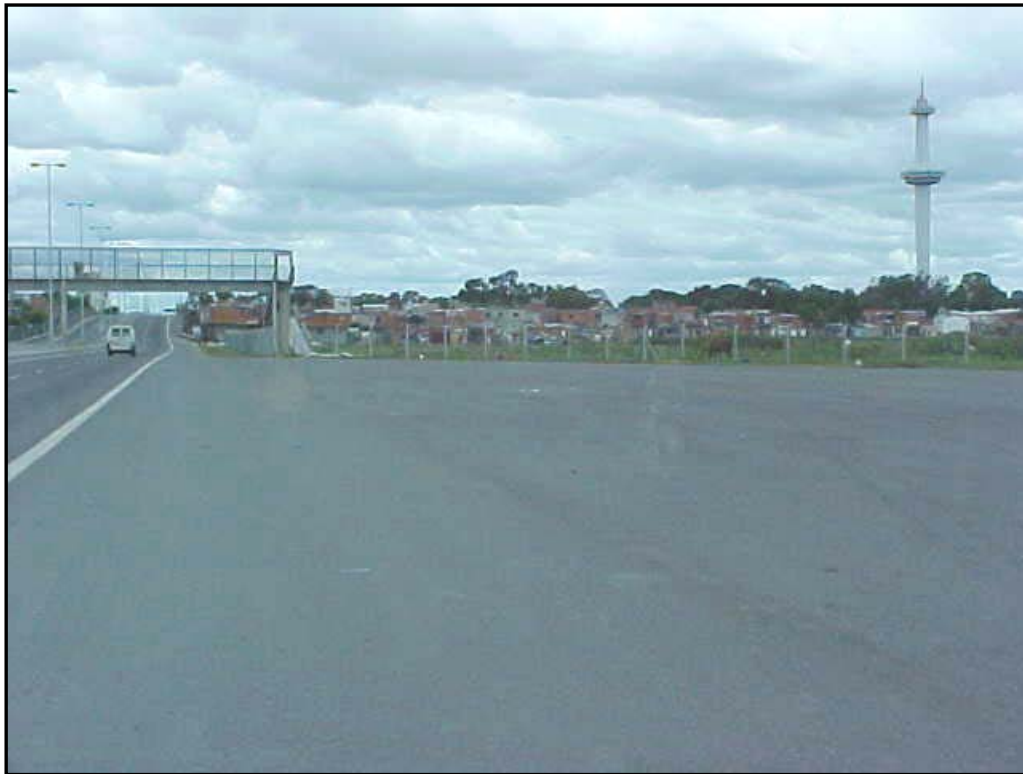
18/11/04. Banda B. Intrusión de viviendas en la Franja No Edificable. Rampa de elevación
