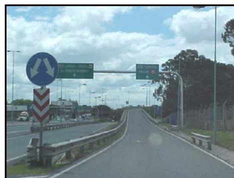
18/11/04. Banda A. Salida de Av. Castañares. Viaducto a nivel.
