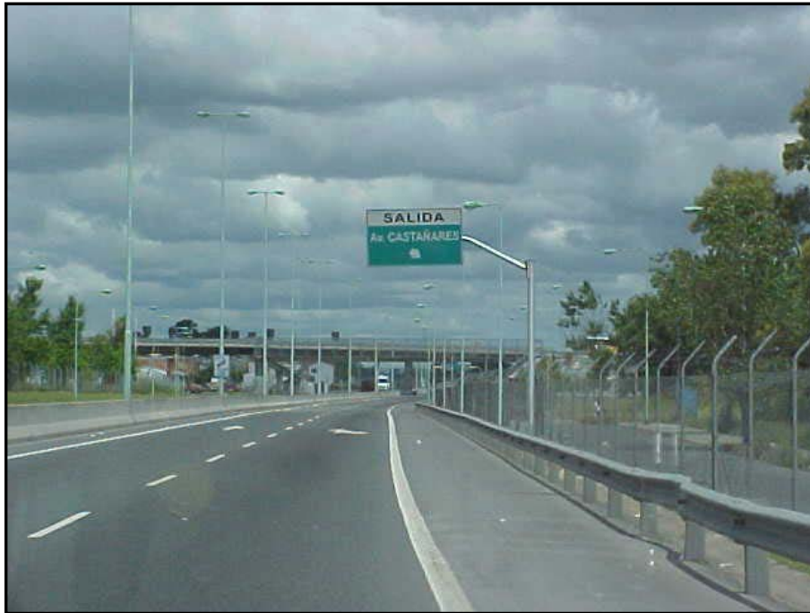
18/11/04. Banda B. Salida Av. Castañares y puente peatonal. A nivel
