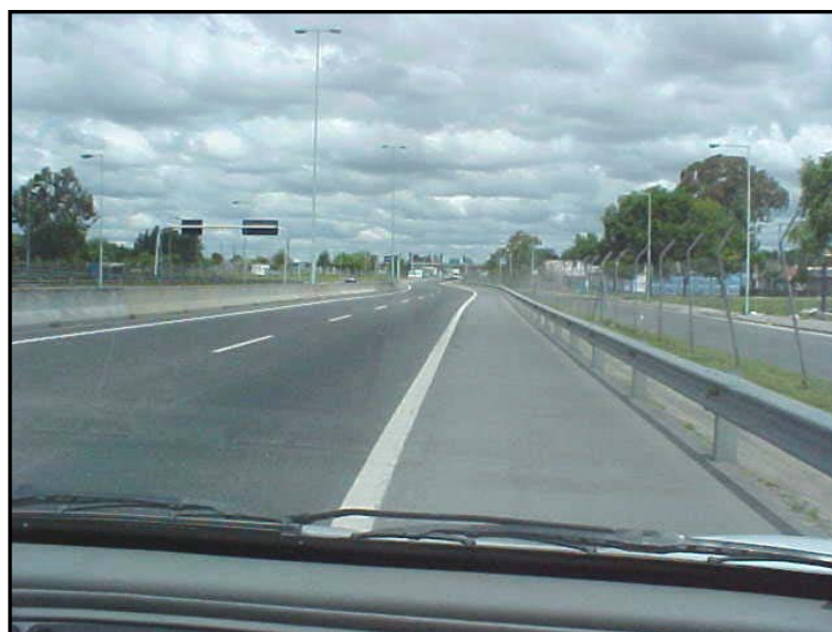
18/11/04. Banda B. Tramo a nivel previo a la intersección con Av. Castañares
