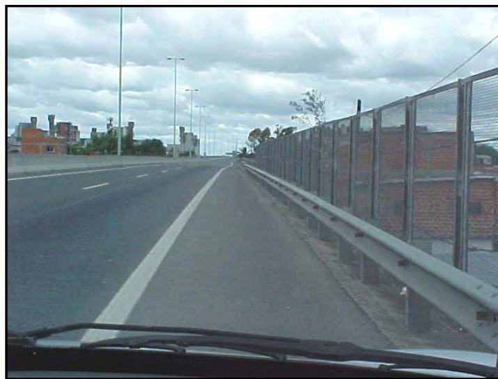
18/11/04. Banda B. Rampa de elevación. Intrusión de viviendas de material en la Franja No Edificable. Rejas de Protección
