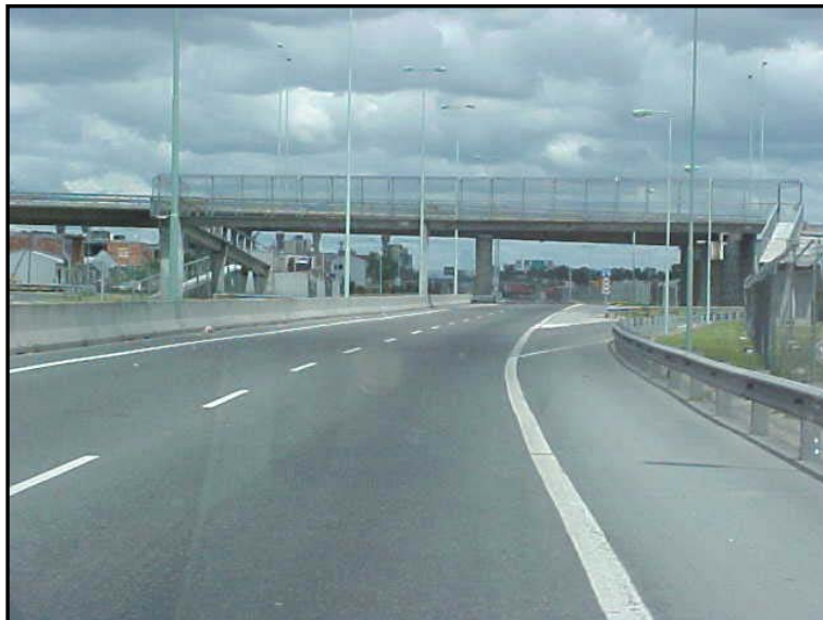
18/11/04. Banda B. Puente peatonal Av. Castañares. A nivel
