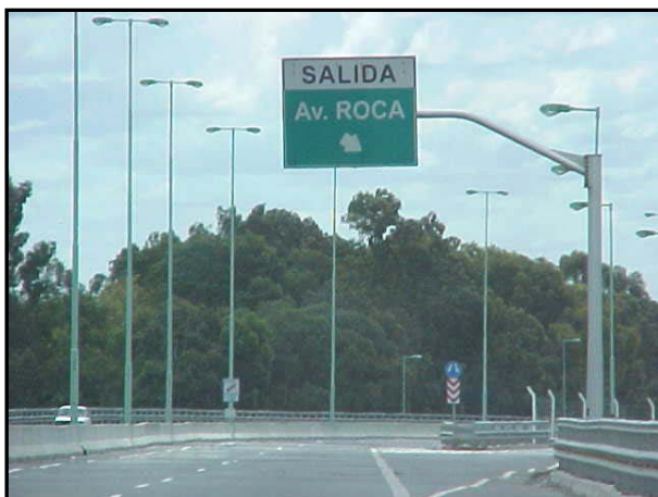
18/11/04 Banda A: viaducto elevado Salida de Av. Roca
