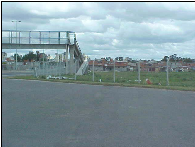
18/11/04. Banda B. Intrusión de viviendas en la Franja No Edificable
