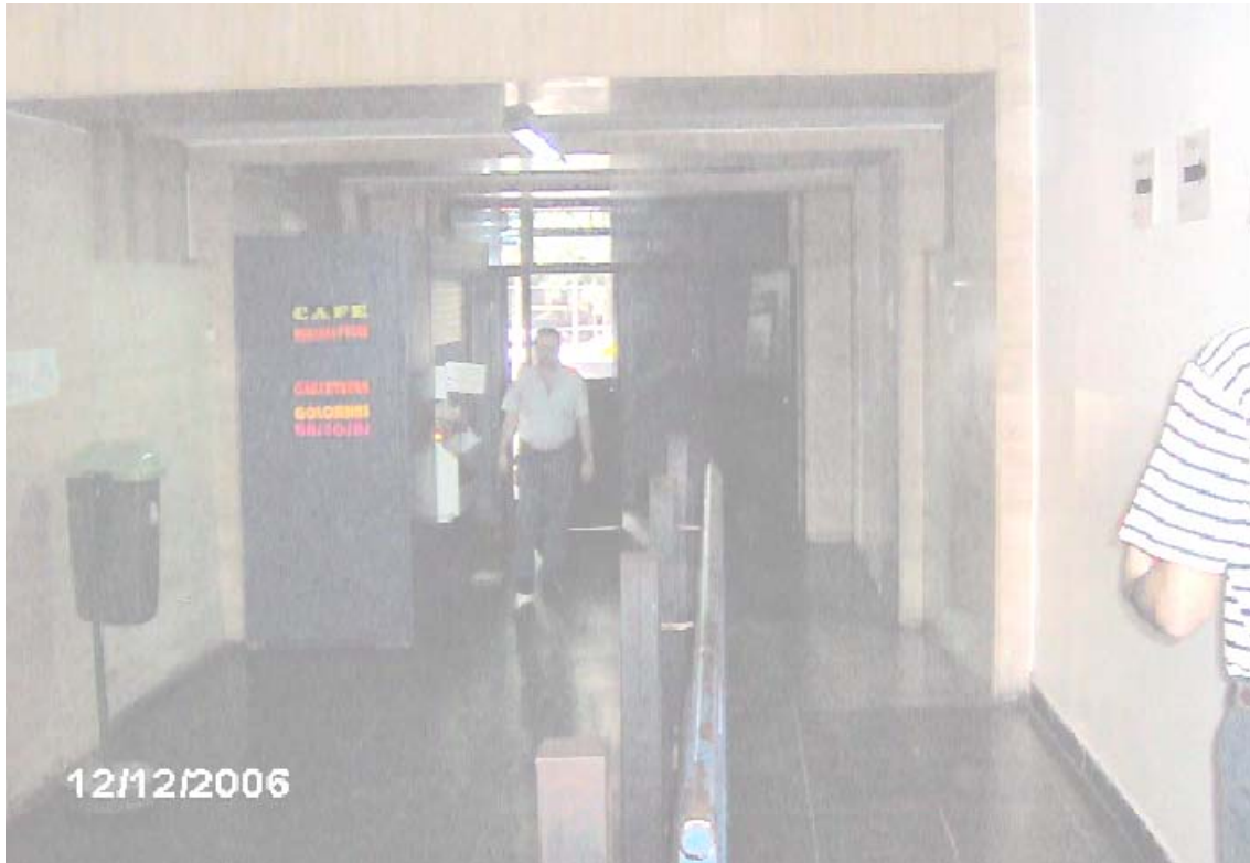
FOTO Nº 3 – VISTA DE LA ENTRADA POR LA AV. CNEL DÍAZ DESDE EL INTERIOR DEL EDIFICIO. EN ESTA VISTA SE APRECIA LA RAMPA PARA DISCAPACITADOS. ES DE NOTAR QUE LOS DISCAPACITADOS PUEDEN ACCEDER AL EDIFICIO Y RECORRER TODA LA PB, PERO NO PUEDEN SUBIR AL ENTREPISO DONDE ESTÁ EL CGP 2, PUES EL ASCENSOR NO FUNCIONA Y LA ESCALERA ES DE 0,80M DE ANCHO.
