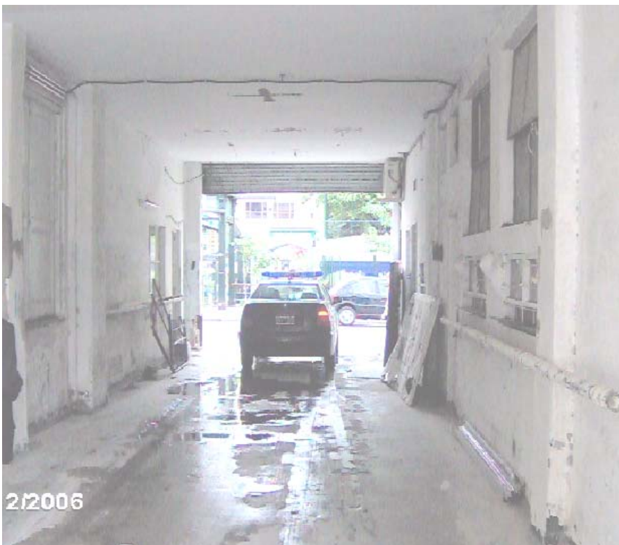
Foto N° 17 – En la presente vista se puede apreciar el mismo sector de la foto anterior donde se pueden observar cables expuestos. El hecho de estar en obra no justifica este desorden en la instalación eléctrica pues el edificio esta habitado.
