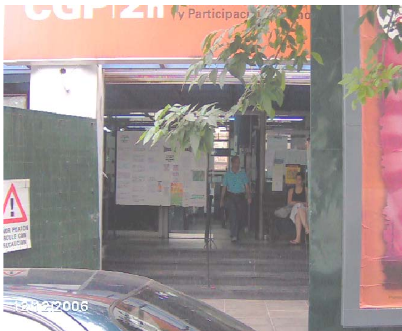
FOTO N° 1 – ACCESO AL EDIFICIO POR LA CALLE BERUTTI, EL ACCESO ES AMPLIO, SIN RAMPAS PARA DISCAPACITADOS (LA RAMPA SE ENCUENTRA POR CORONEL DÍAZ). YA DENTRO HAY UN HALL QUE RECORRE TODA LA PB, CONECTA TODOS LOS ACCESOS Y ES COMÚN A LOS TRES ORGANISMOS.
