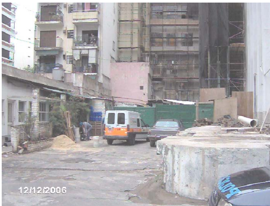
FOTO N° 16 – EN LA PRESENTE VISTA SE PUEDE OBSERVAR EN LA PARTE POSTERIOR DE LA PB DEL EDIFICIO LA PLAYA DE ESTACIONAMIENTO Y LUGAR DE DEPÓSITO DE MATERIALES Y HERRAMIENTAS COMUNES A LOS DOS CGP. ES DE NOTAR QUE EL MAL ESTADO DEL PISO Y LAS PAREDES SE DEBE A QUE TODAVÍA NO LLEGARON A ESTE LUGAR CON LAS OBRAS DE RECICLAJE QUE YA HAN INTERVENIDO EL FRENTE Y EL PATIO INTERIOR.
