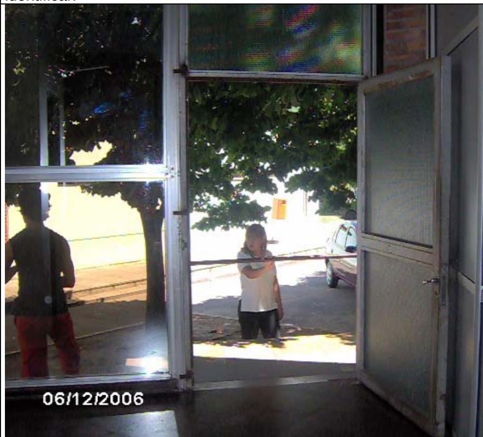
Observación N° 4: Foto N° 6 – Puerta de emergencia sin
