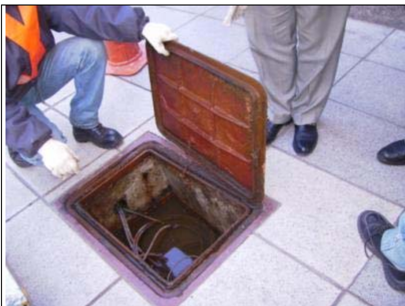
FOTO 11 – Tucumán y Bouchard Construcción de Nuevos Cruces Semafóricos
