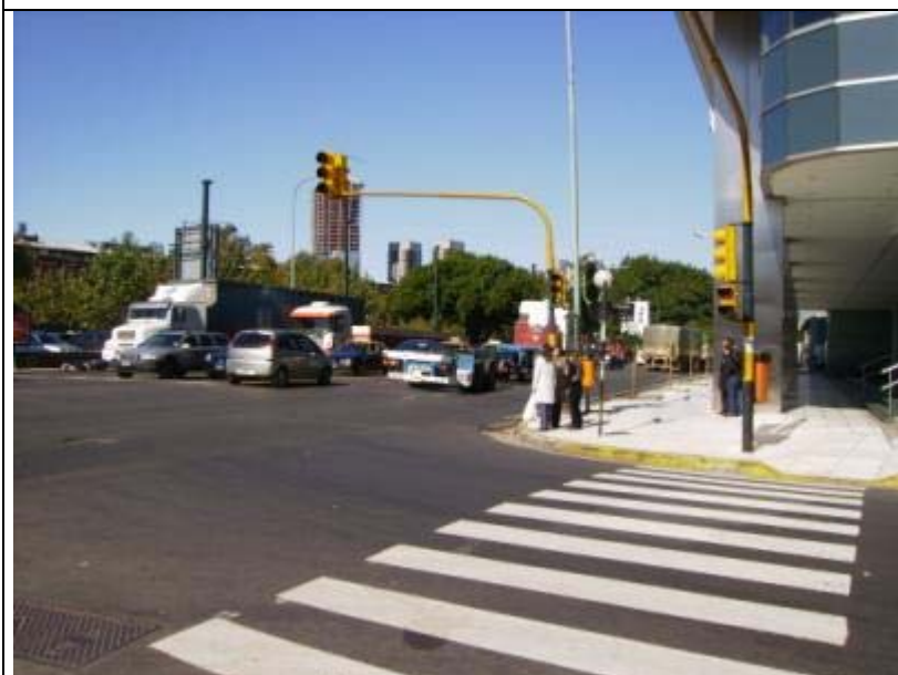
FOTO 14 – Avda. Madero y Tucumán Daños. Retiro de semáforo y su soporte. Montaje y conexionado de semáforo vehicular de aluminio (nuevo). Montaje y conexionado .Retiro de bornera en columna.
