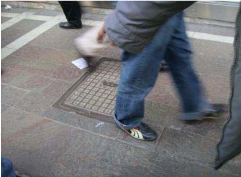
FOTO 7– Avda. Corrientes y Florida. Daños y Ampliación. (Instalación de tapa de cámara de inspección de 60 x 40 cm.)
