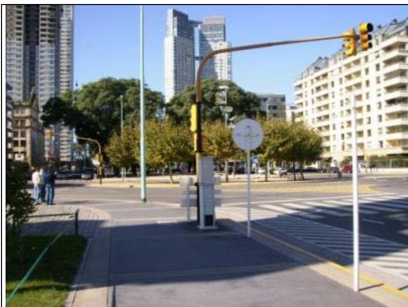
FOTO 19 – I.M.S.L. Ampliación de interconexión en Av. Belgrano – Puerto Madero
