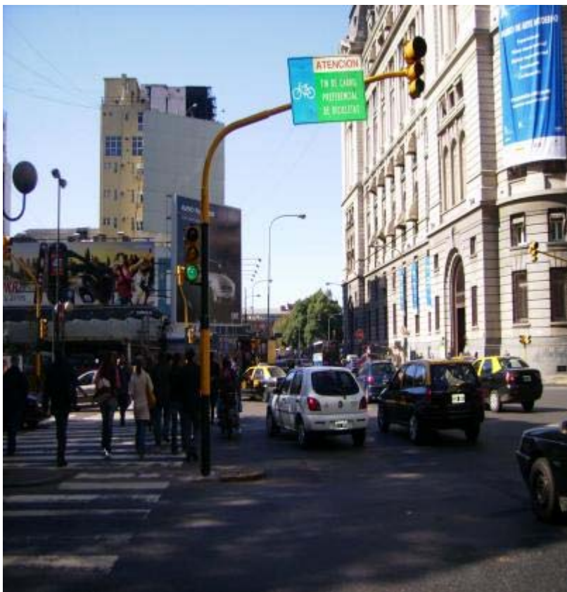
FOTO 8 - Avda. Alem y Avda. Corrientes. Daños. Montaje de columna con pescante de 4 m. Montaje y conexión de semáforo de cualquier tipo, con colocación del soporte que corresponda en parte recta de columna recta y en extremo de pescante. Montaje y conexión o retiro de bornera en columna. Retiro de columna con pescante de 4 m. Repintado de columna con pescante de 4 m.
