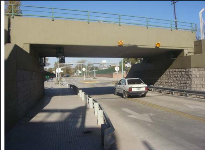
En la foto se visualiza el paso a nivel de la Av. Bonorino bajo las vías del ex FFCC Belgrano. Este es el único cruce que fue construido efectuando la apertura del terraplén del ferrocarril.
