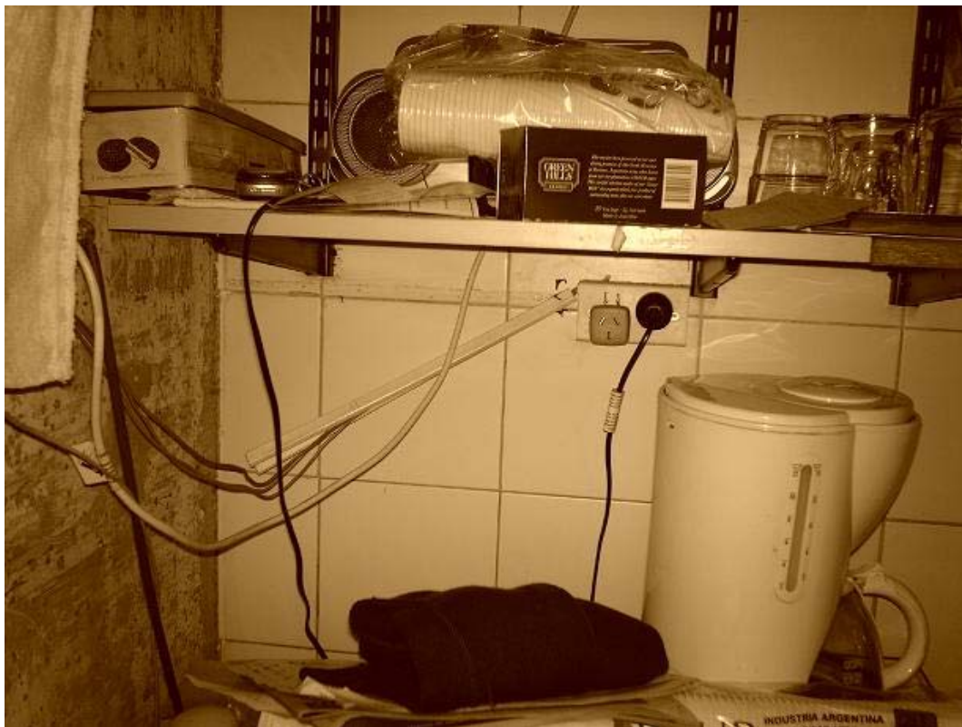
Instalación eléctrica deficiente, mal estado de conservación y sobrecarga del toma corriente. Cocina de Presidencia 8º piso.
