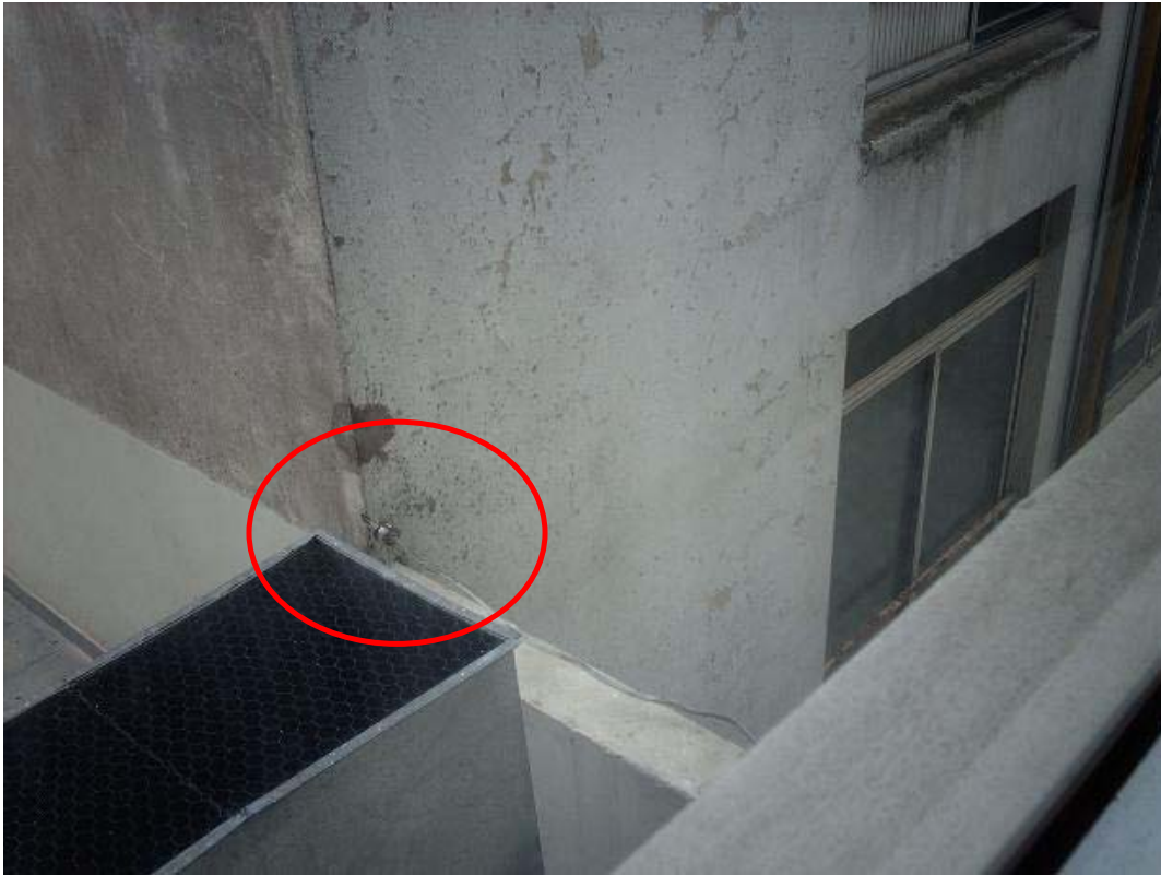
Puesta a tierra correspondiente al edificio cortada.
