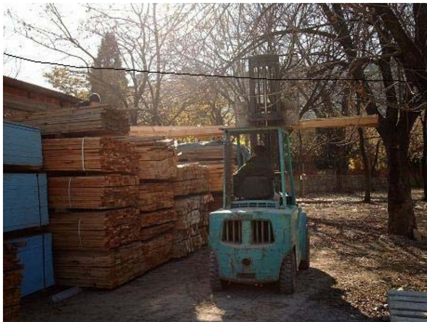
Vista de una correcta segregación y orden de los materiales
