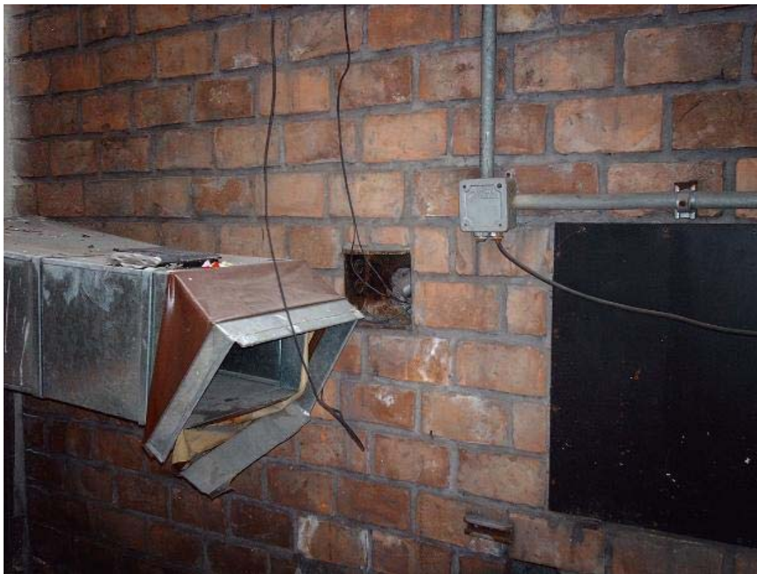
Abertura de conductos de aire sin mantenimiento y riesgo de transmisión de vectores
