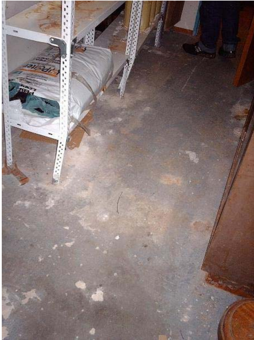
Estanterías vencidas con riesgo de caída.
