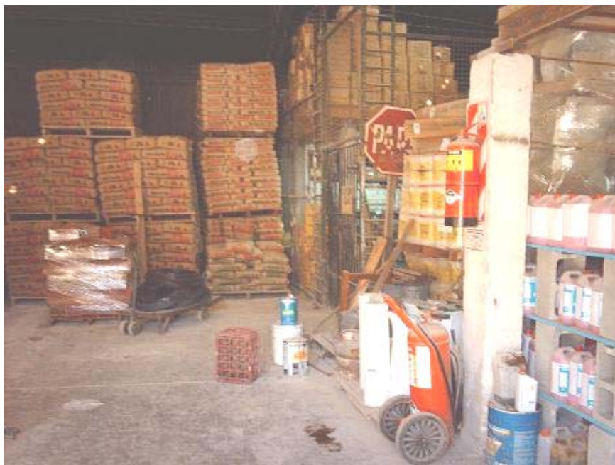
Vista general de depósito y ubicación de extintores vencidos
