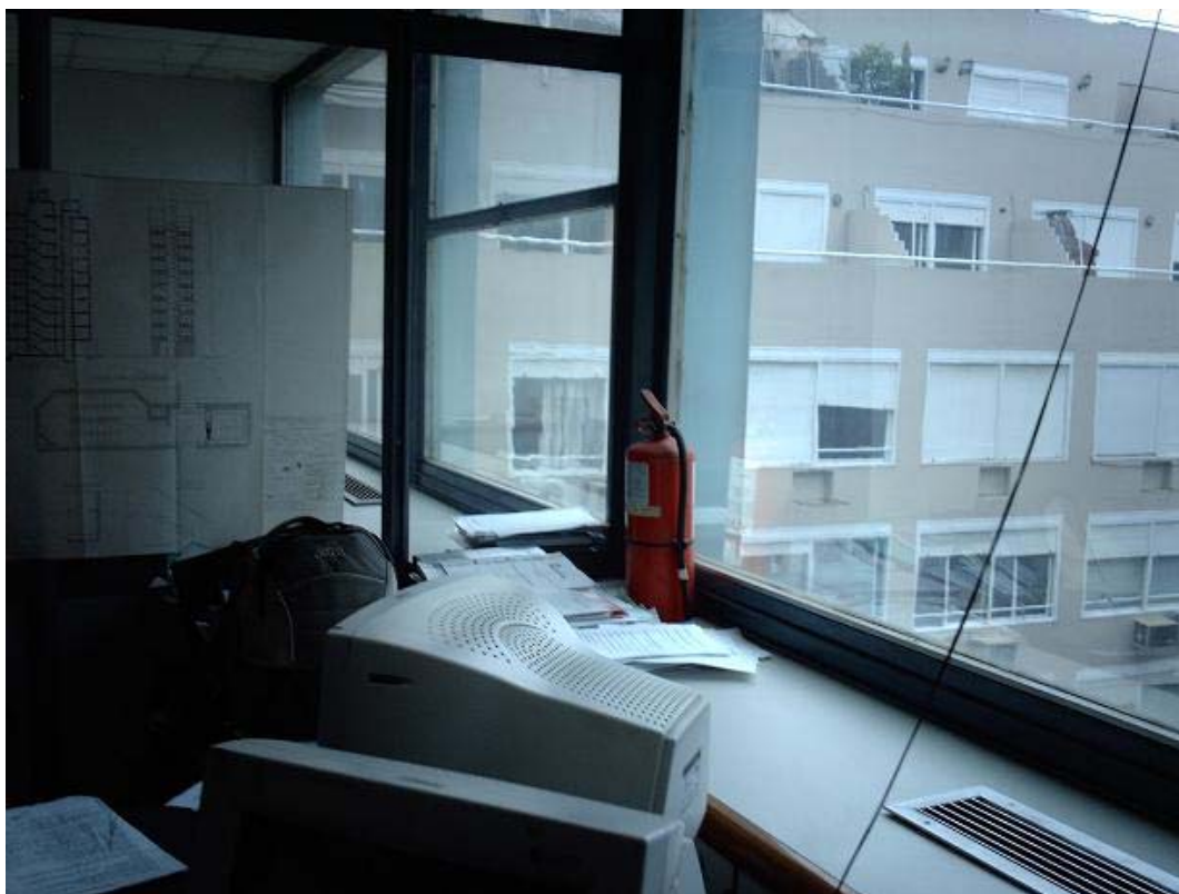
Mala distribución y ubicación de elementos de extinción de incendios
