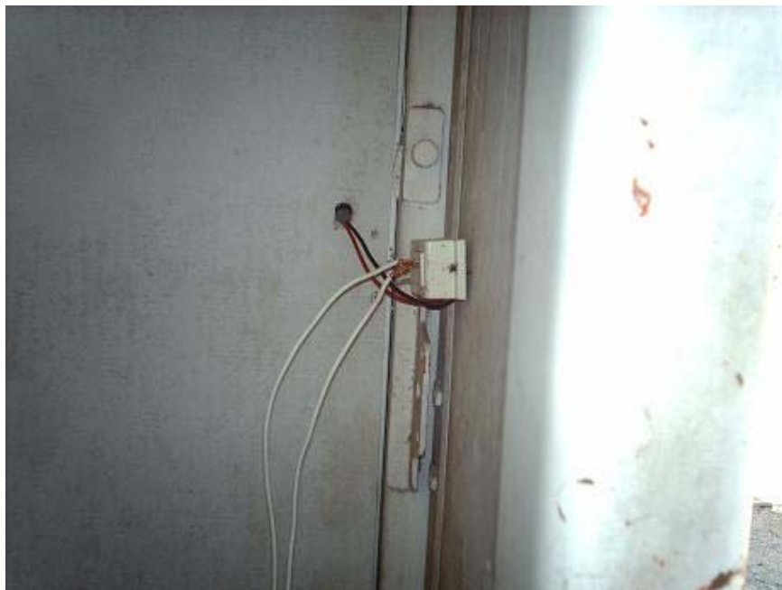
Conexión precaria de herramientas
