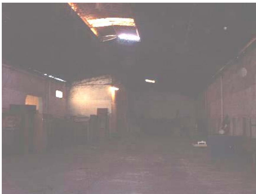
Vista de otra nave del depósito vacío
